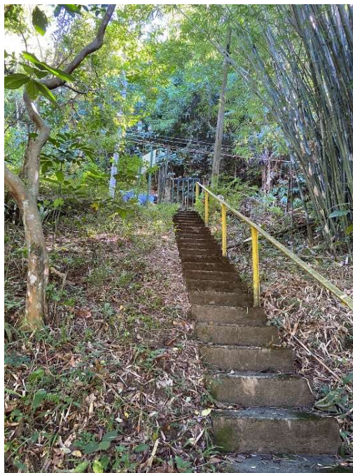
Escada acesso a captação
