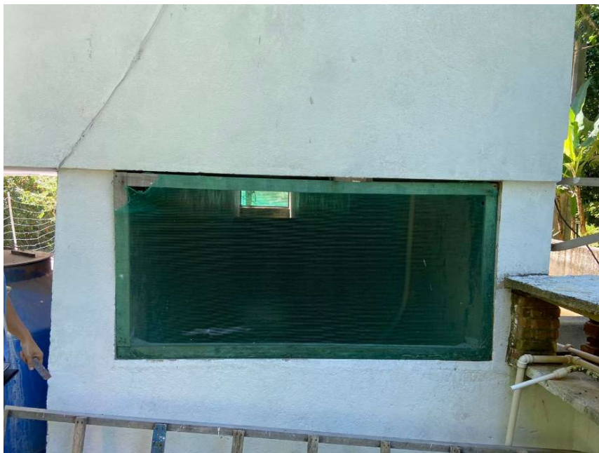
Acesso ao interior do reservatório
