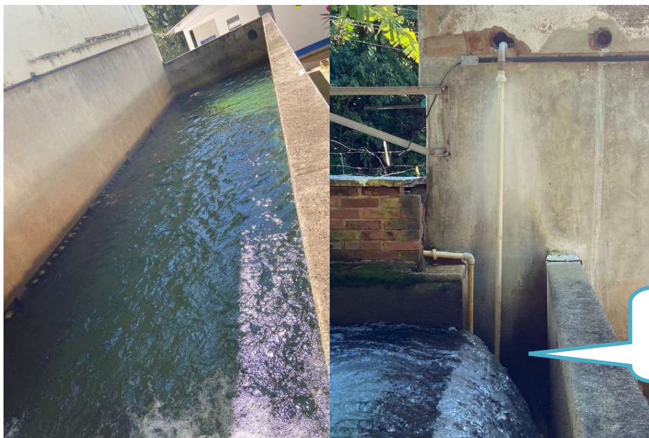
Câmara de contato com Hypocal
