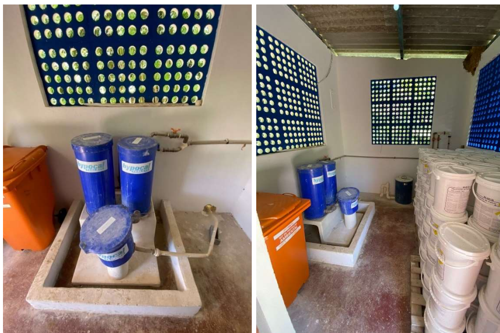
Sistema de desinfecção e depósito do Hipoclorito de Cálcio
