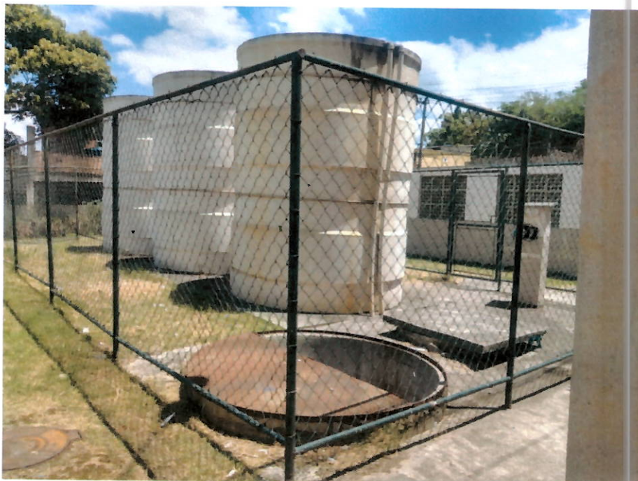
Foto 1 – Área onde está situada a estação de tratamento de esgotos
