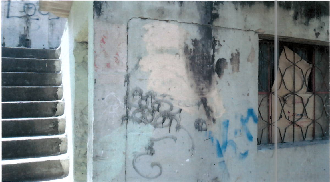
Foto 3 – Imóvel construído no terreno da ETE
