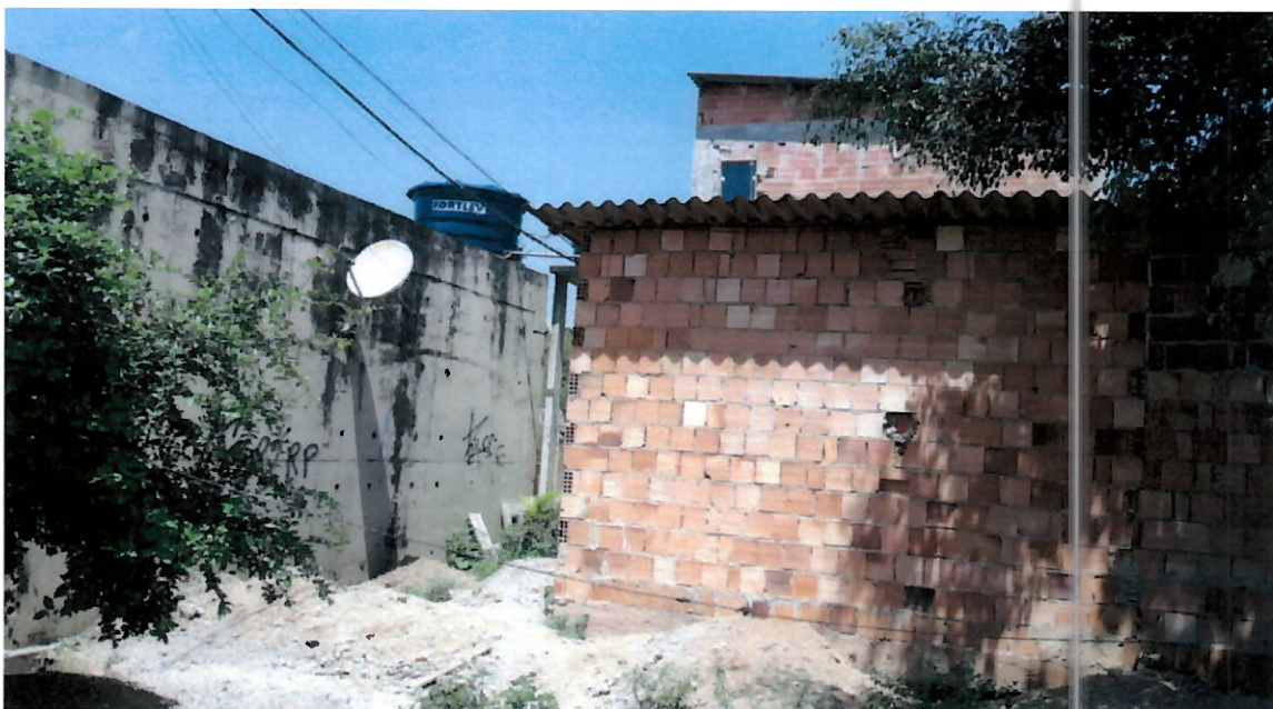
Foto 2 – Imóvel construído no terreno da ETE
