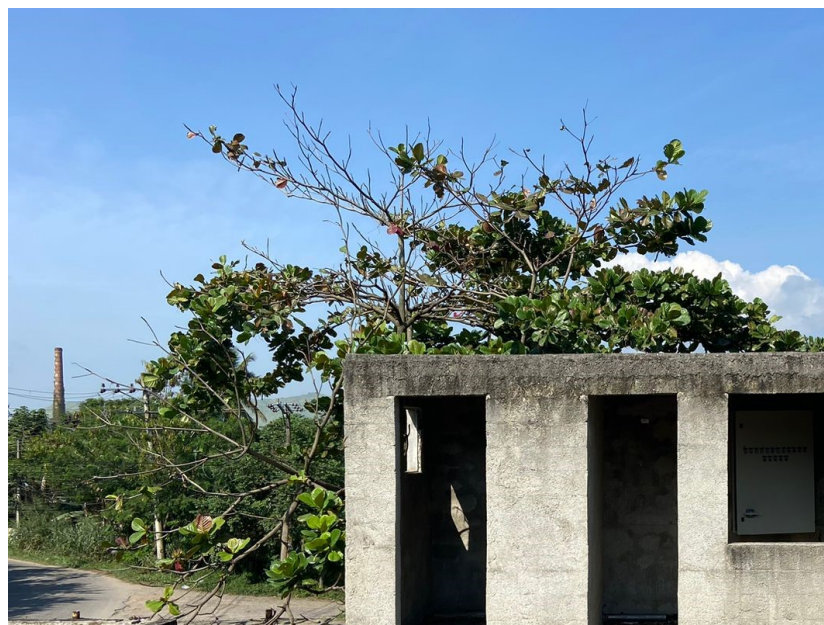
Parte de cima da ETE com a construção do que será a casa de força para abrigar o painel elétrico;
