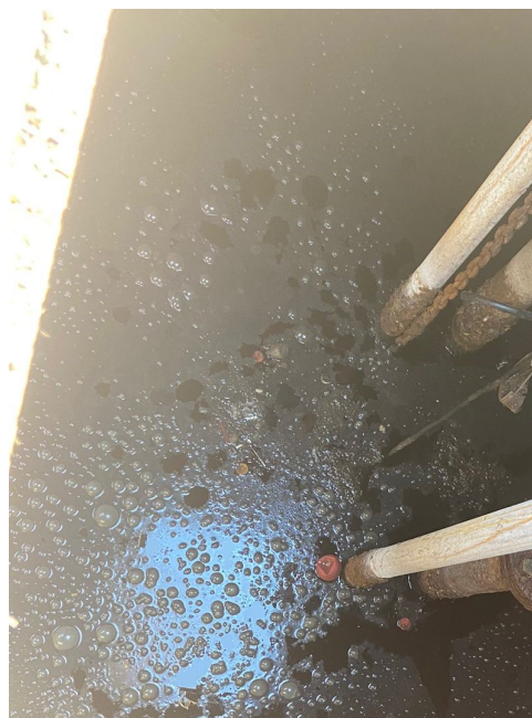
Poço das duas bombas desativado;
