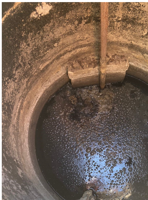
Caixa de entrada com grade de ferro fundido.
