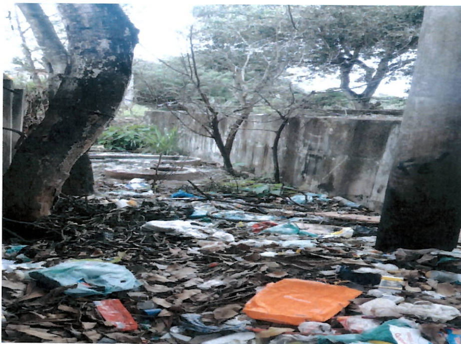
Foto 5 – Vista frontal (interna)
