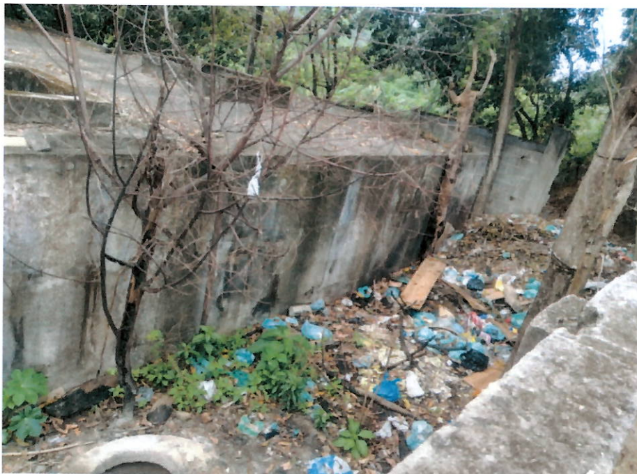
Foto 8 – Vista frontal (interna)
