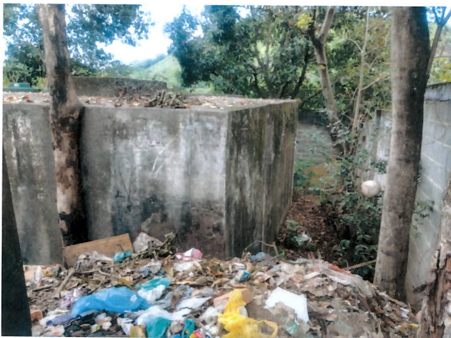
Foto 3 – Vista lateral esquerda (interna)
