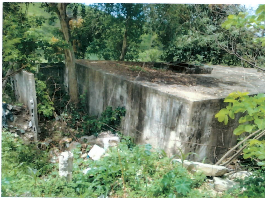
Foto 4 – Vista lateral direita (externa)
