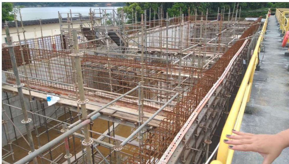
FOTO 36 – Novos floculadores e decantadores
