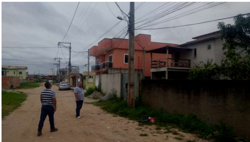
FOTO 11 – Local da futura instalação do Booster Vista Alegre (Ref.: alínea “b”)
