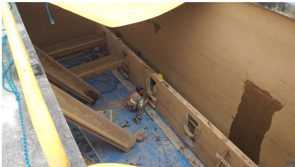
FOTO 30 – Elevação das calhas dos filtros existentes para o novo sistema de lavagem
