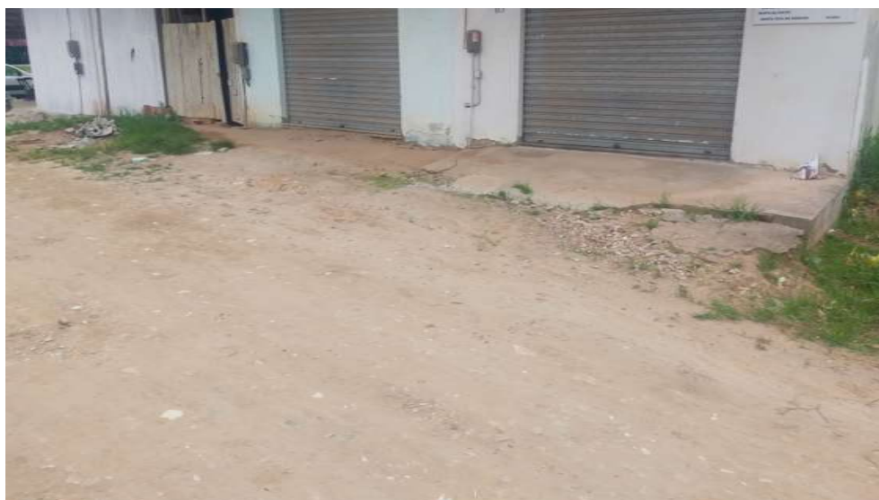
FOTO 12 - O Booster provavelmente será instalado aqui
