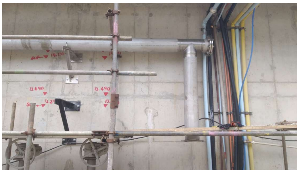
FOTO 23 – Nova tubulação 250 mm, de aço inox, para limpeza por ar dos filtros existentes
