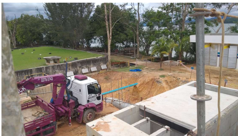
FOTO 41 – Interligação dos novos filtros ao reservatório de água tratada
