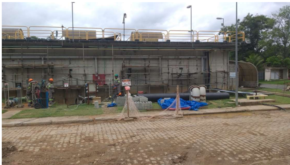
FOTO 18 - Retrofit sistema de lavagem filtros existentes (1/5)
