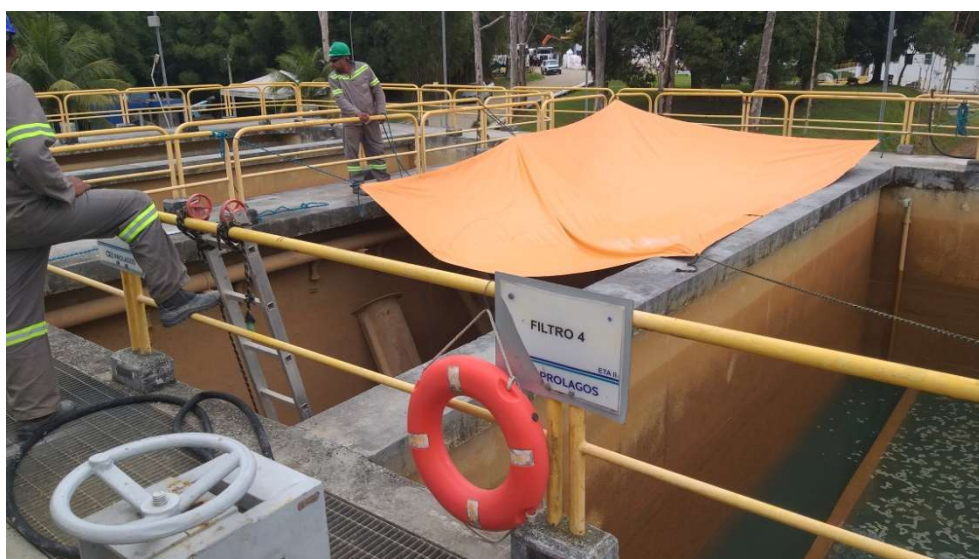
FOTO 33 – Elevação das calhas do Filtro 3
