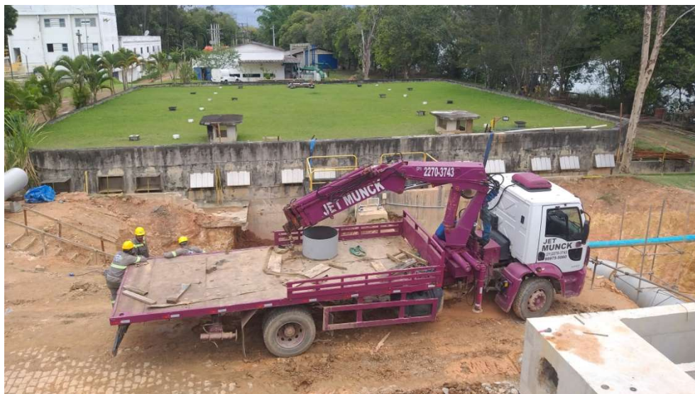
FOTO 44 – Reservatório de água tratada ao fundo
