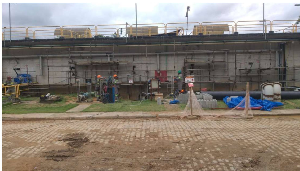
FOTO 19 - Retrofit sistema de lavagem filtros existentes (2/5)
