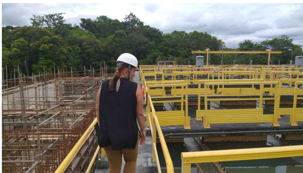
FOTO 35 – Estrutura existente à direita e nova estrutura à esquerda
