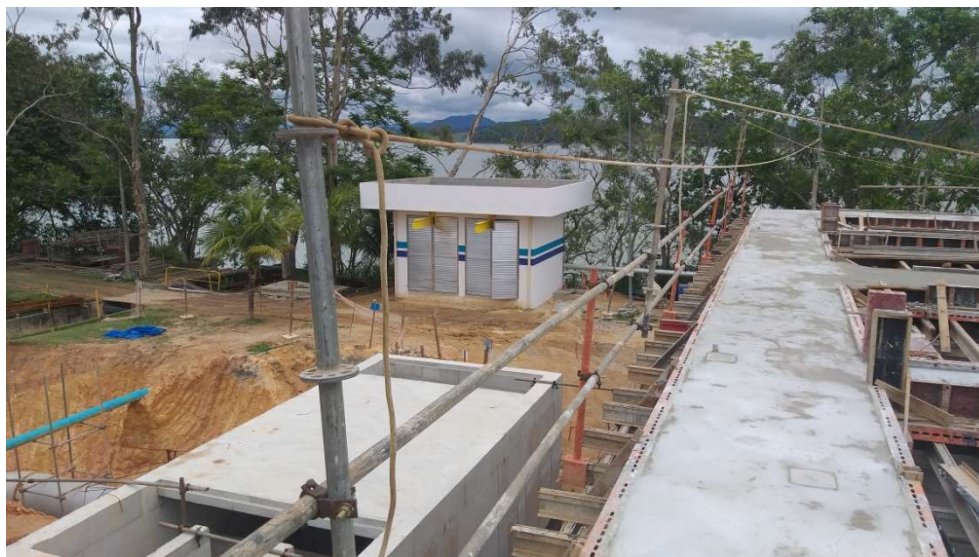
FOTO 43 – Casa dos sopradores ao fundo da imagem
