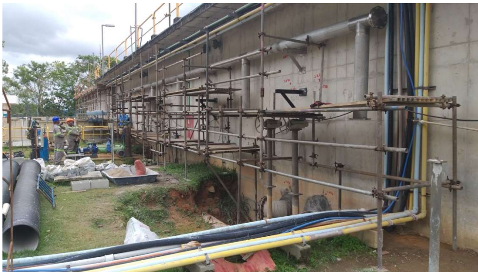
FOTO 28 – Operários trabalhando no novo sistema de limpeza de filtro existente
