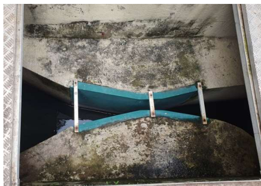
Calha Parshall de entrada com medição manual e de saída com medidor eletrônico.
