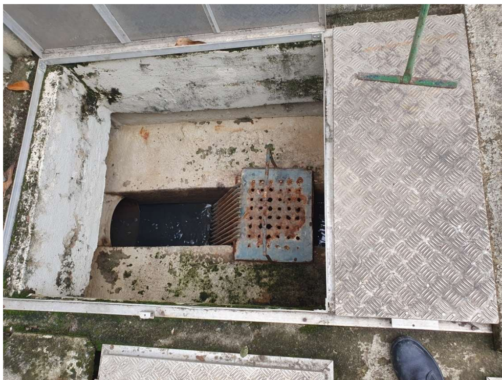
Gradeamento da ETE encontra-se em bom estado de conservação.
