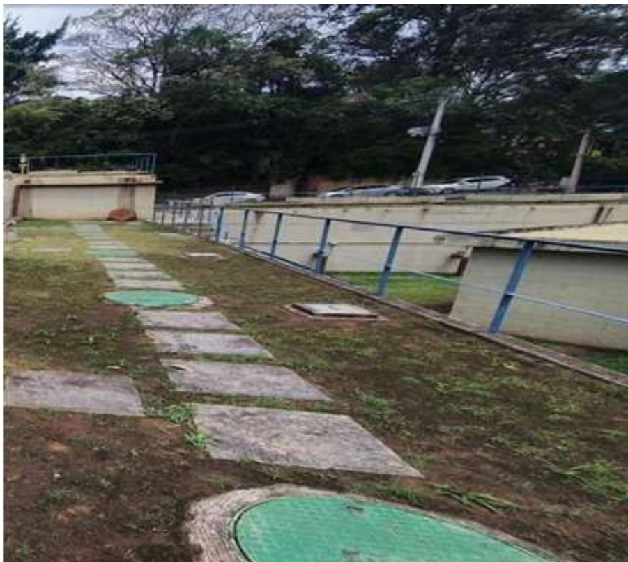
Guarda-corpos de segurança da ETE estão em bom estado de conservação
