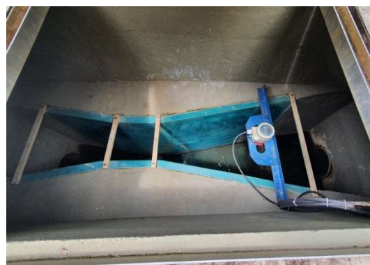
Calha Parshall de entrada com medição manual e de saída com medidor eletrônico.
