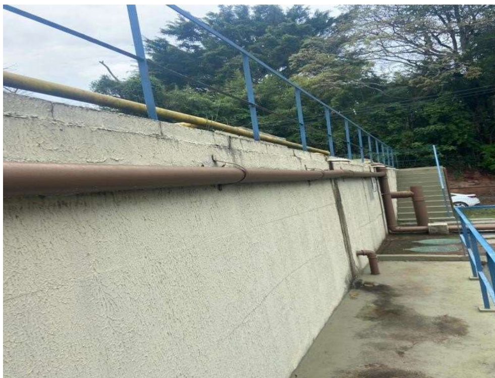
Escada de acesso a parte superior do reator UASB
