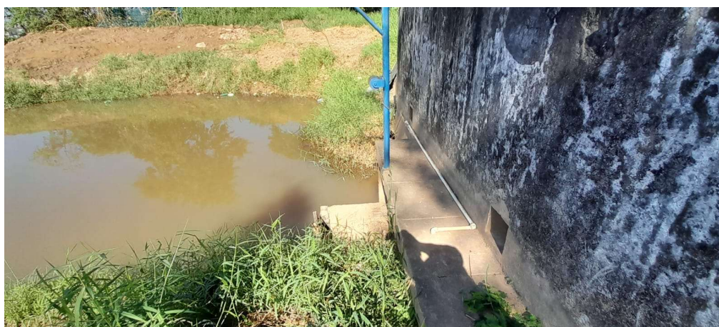
Entrada da Captação
