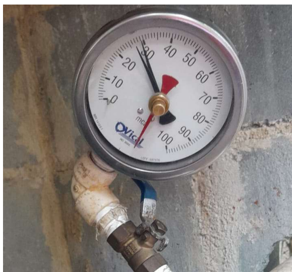
Pressão de Coluna D'água
