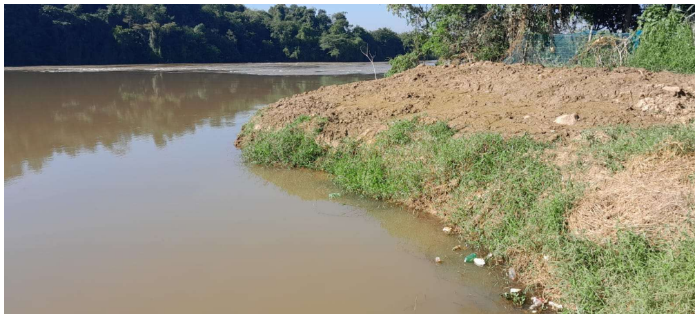
Margem Direita da Captação
