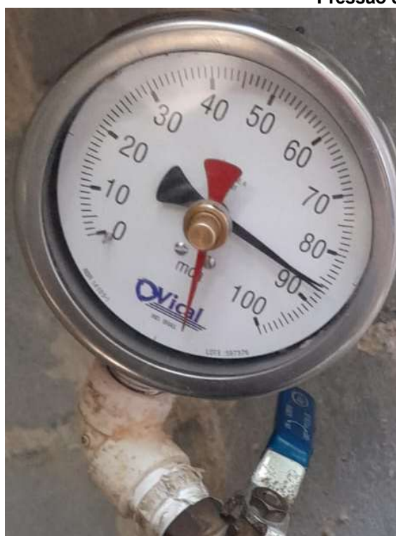
Pressão de Recalque
