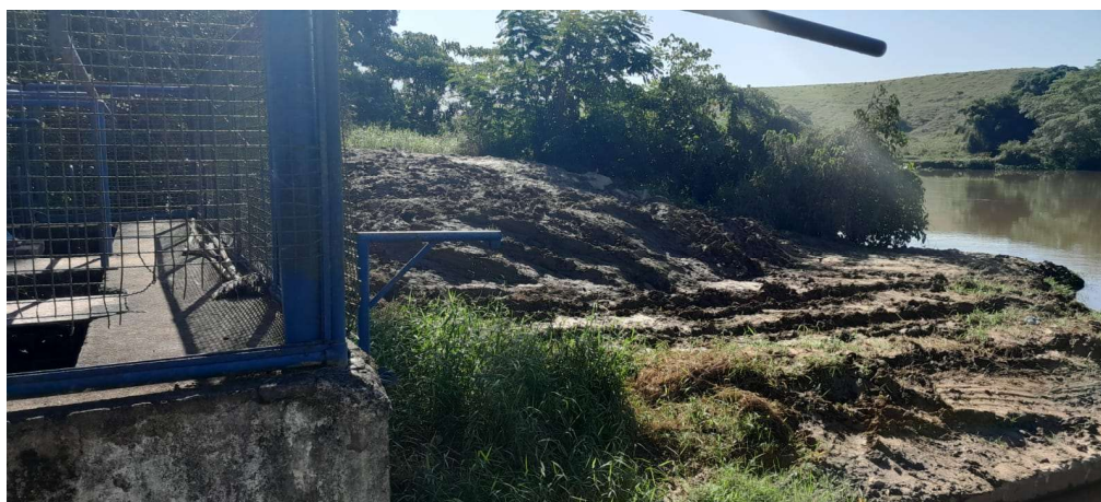
Margem Esquerda da Captação
