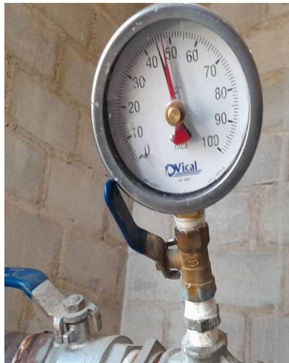
Pressão de coluna d'água
