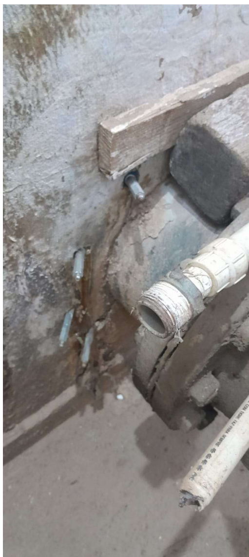
Reparo com Inserção de Resina
