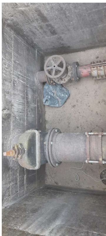
Duto Extravasador, câmara de válvulas
