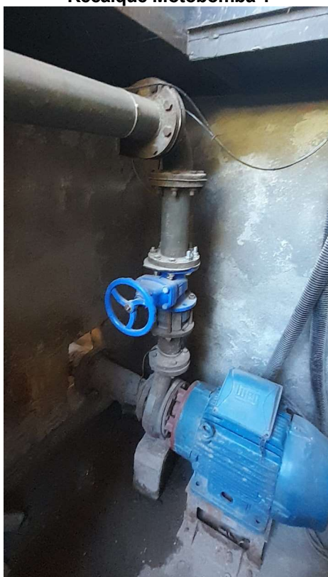
Recalque Motobomba 2
