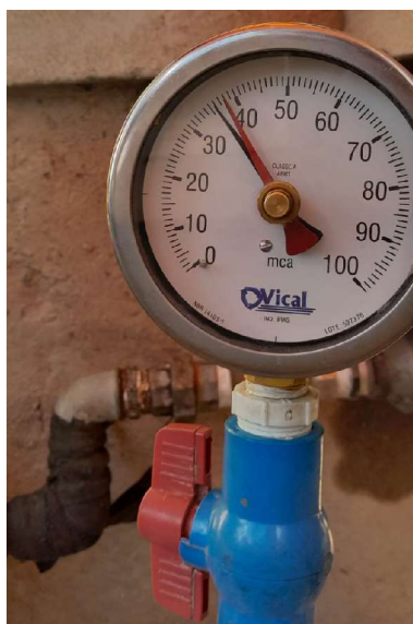
Pressão de Recalque
