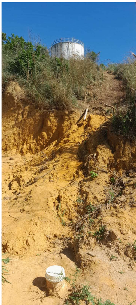
Acesso Reservatório Jardim Real
