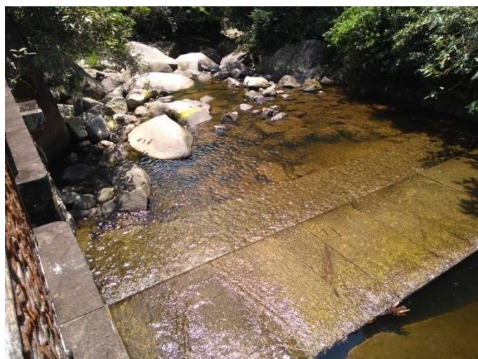
Foto 06 – Barragem da UT São Pedro
