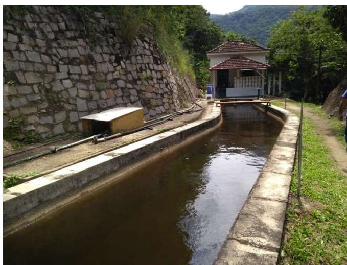
Foto 19 – Canal da Saída dos Decantadores
