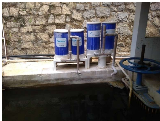
Foto 21 – Bombonas de Mistura do Hipoclorito de Cálcio (Segunda Opção)
