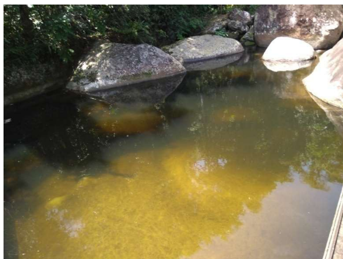
Foto 07 – Barragem da UT São Pedro
