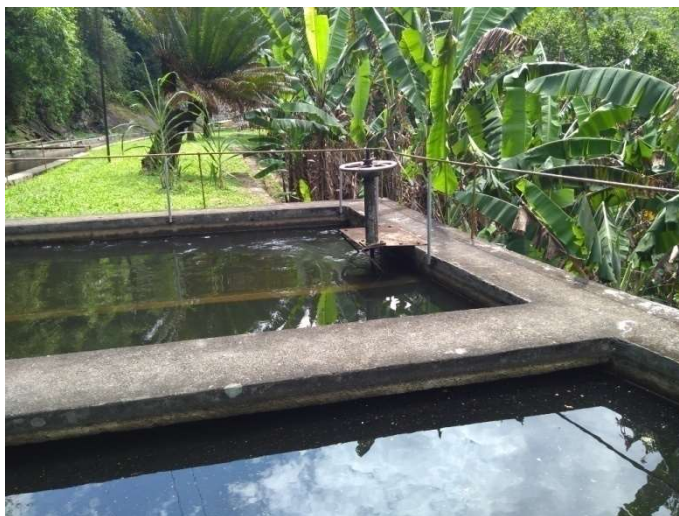
Foto 16 – Registro Extravasor dos 12 Decantadores
