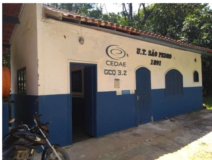
Foto 03 – Instalações da UT São Pedro
