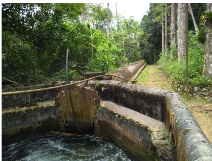
Foto 08 – Descida da Água dos Mananciais para o Reservatório
