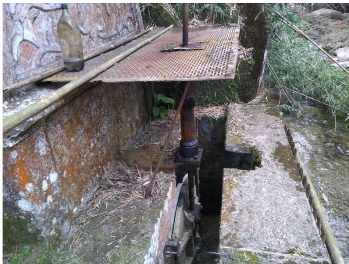
Foto 06 – Registro da Comporta da Entrada de Água Bruta do Rio D'Ouro
