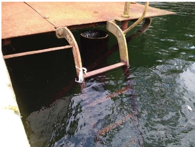
Foto 21 – Reservatórios da UT Rio D'Ouro, Local de Entrada da Água Clarificada
