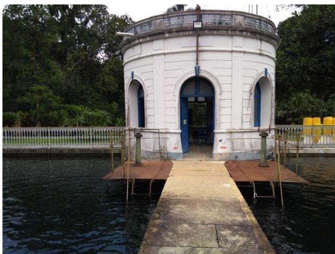
Foto 20 – Reservatórios da UT Rio D'Ouro, Local de Manobra e Aplicação de Fluor
