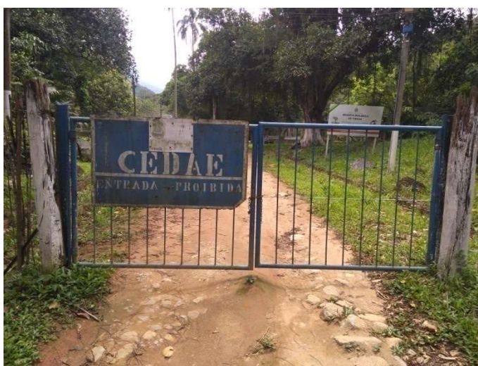
Foto 02 – Entrada da Unidade de Tratamento de Água Rio D'Ouro
