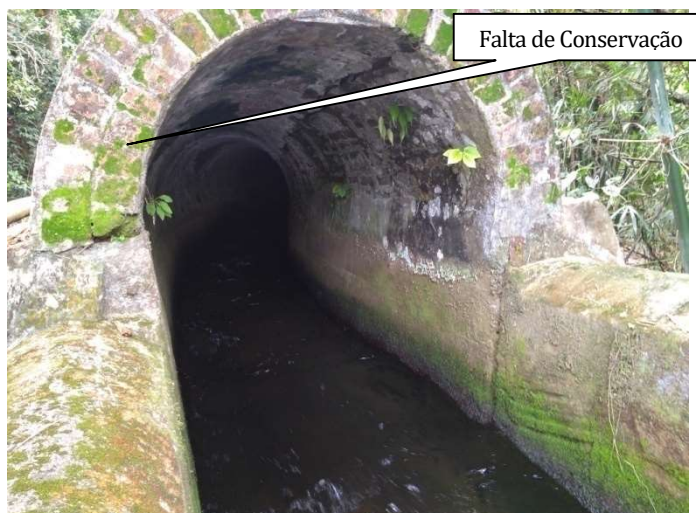
Foto 13 – Túnel Canal Advindos dos Mananciais
