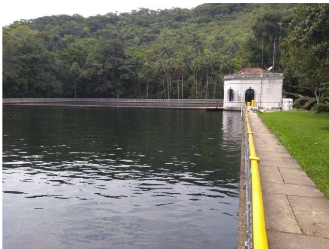
Foto 18 – Reservatórios da UT Rio D'Ouro
