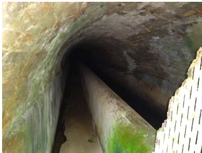
Foto 09 – Túnel Canal Santo Antonio
