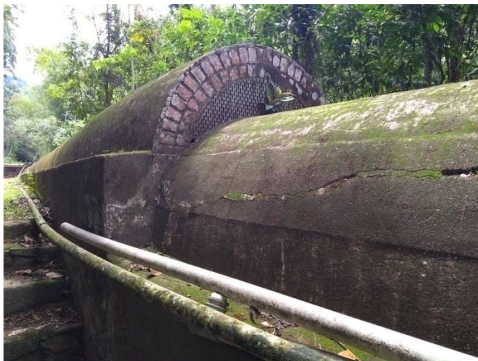
Foto 12 – Túnel/Canal Advindos dos Mananciais
