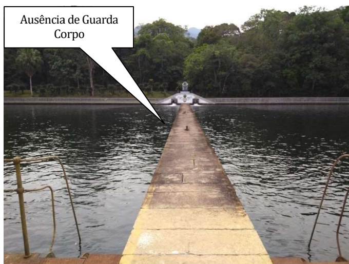
Foto 19 – Reservatórios da UT Rio D'Ouro
