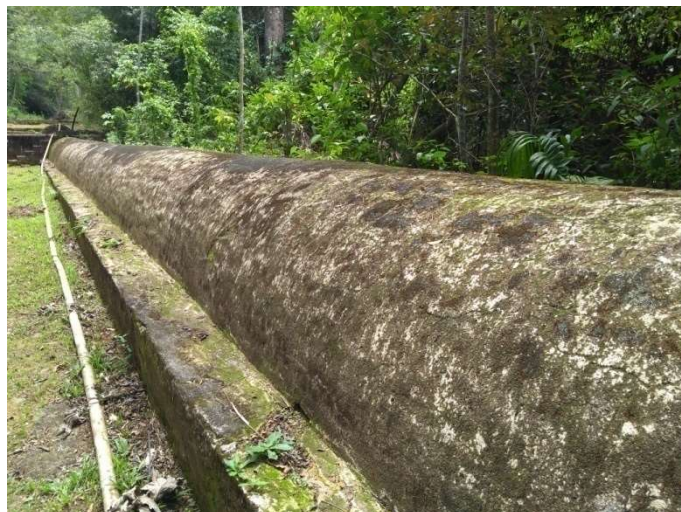
Foto 10 – Túnel/Canal Advindos dos Mananciais
