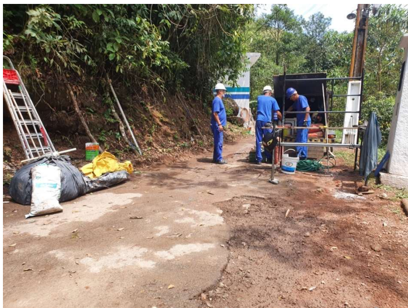
Funcionários da Águas do Rio realizando reforma/manutenção na UT
