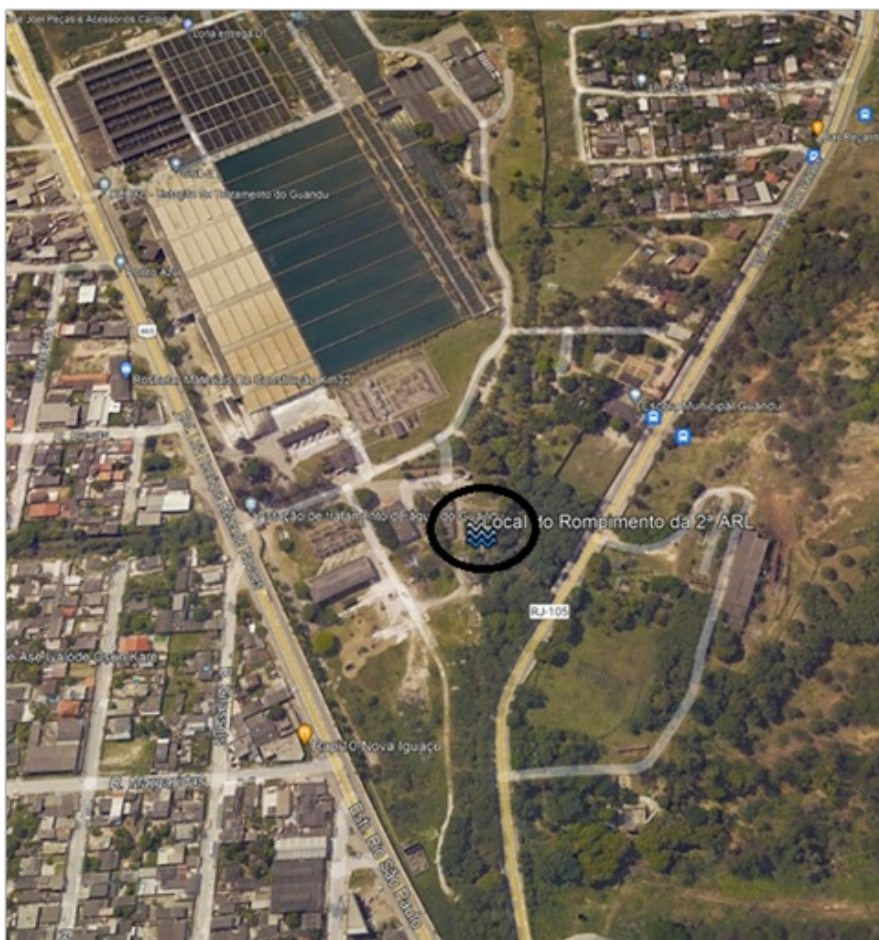
Local do rompimento Foto: Google Earth.
