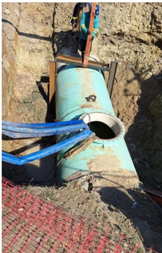
Foto 1- Chegada ao local do rompimento (drenagem da tubulação)
