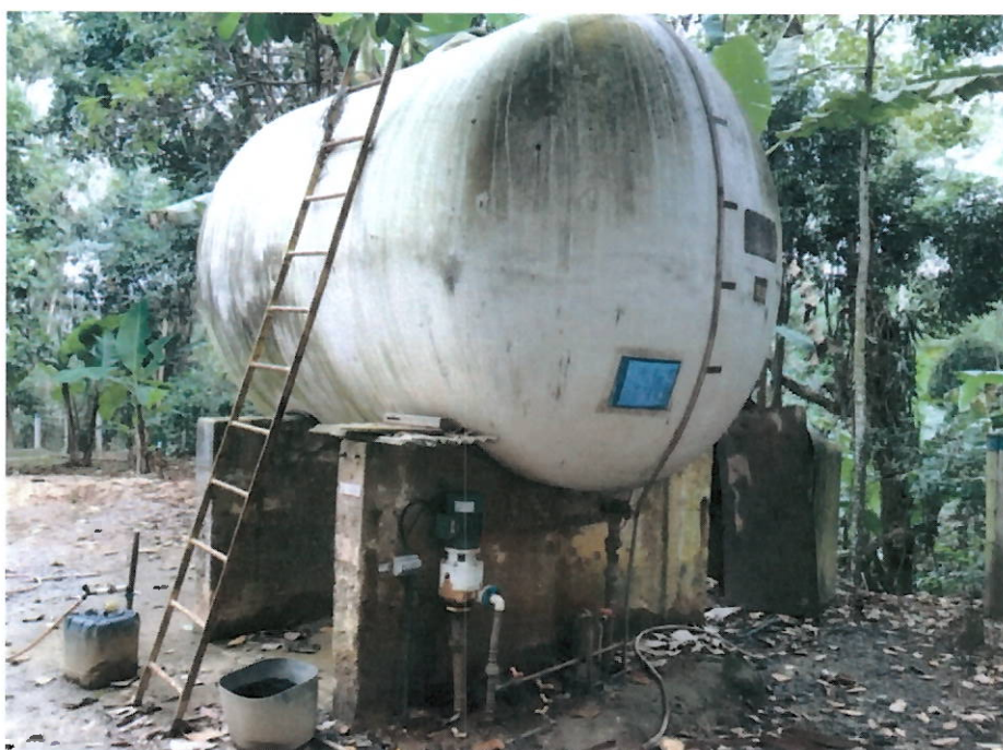
Falta de bacia de contenção, Dique de Contenção
