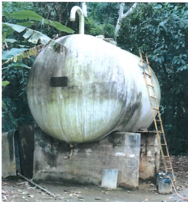
Falta de bacia de contenção, Dique de Contenção
