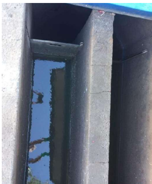
Figura 4 – Tratamento preliminar: trincas e fissuras nas paredes laterais dos desarenadores.
