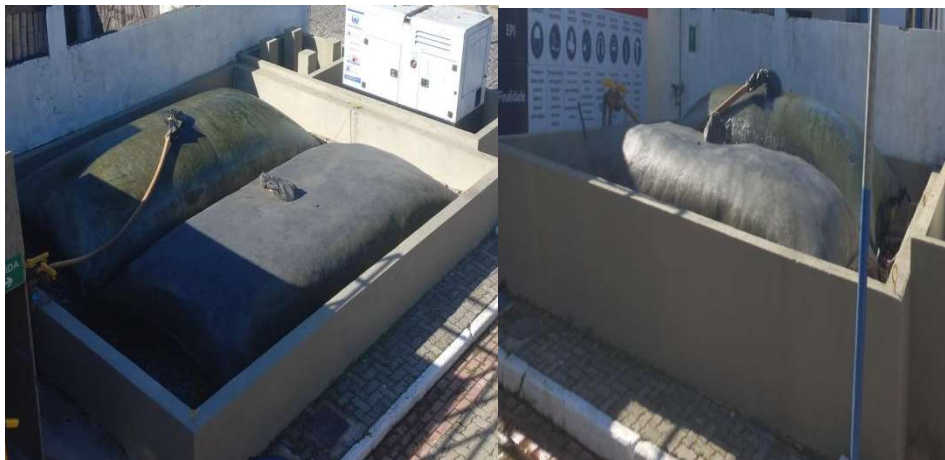
Figura 10 – Tratamento do lodo: tubos geotêxteis (um saturado e outro enchendo), para realizar desidratação (secagem), auxiliada pela aplicação de polímeros oriundos do tanque de mistura.
