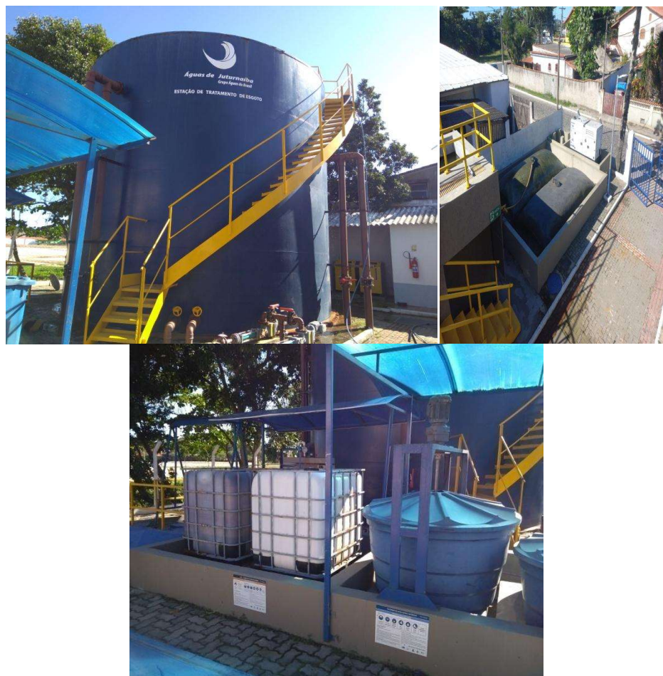
Figura 1 – Vistas do perímetro da ETE Saquarema: alambrado e estruturas do tratamento
