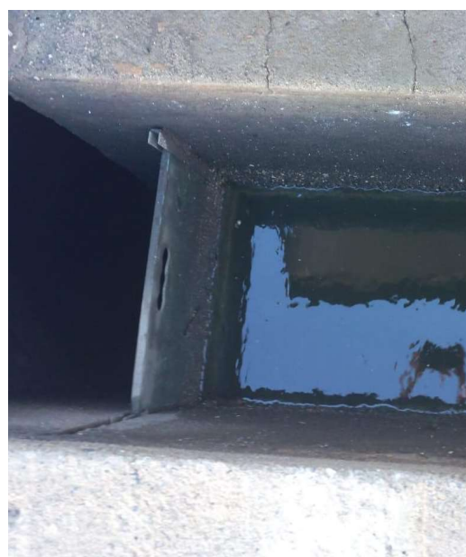
Figura 4 – Tratamento preliminar: trincas e fissuras nas paredes laterais dos desarenadores.
