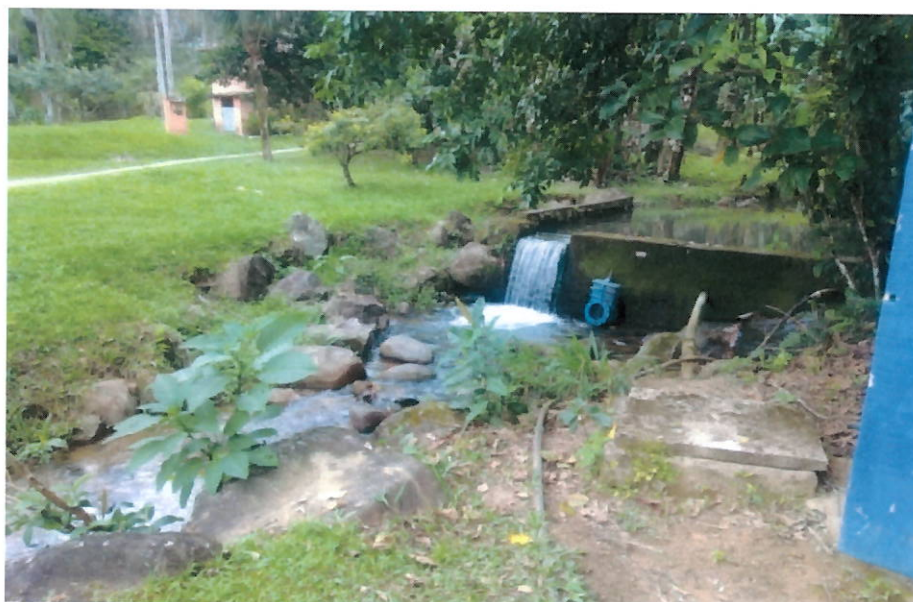
Foto 05 – Barragem do rio Lavras
