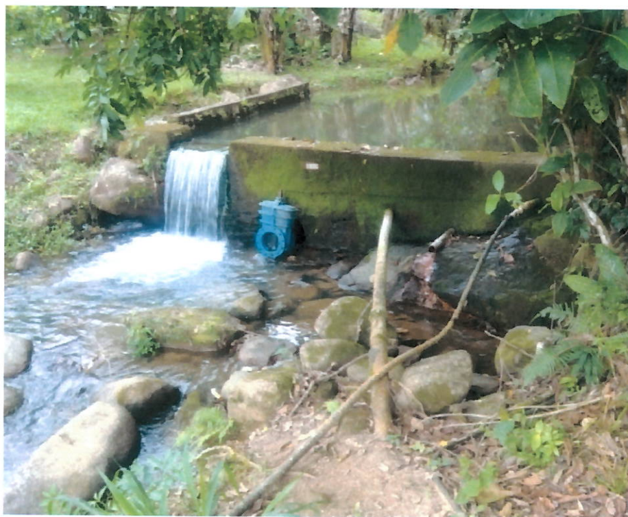
Foto 04 – Barragem do rio Lavras
