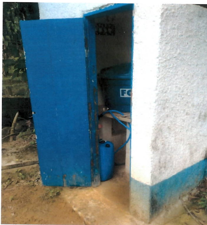
Foto 08 – Casa de Química
