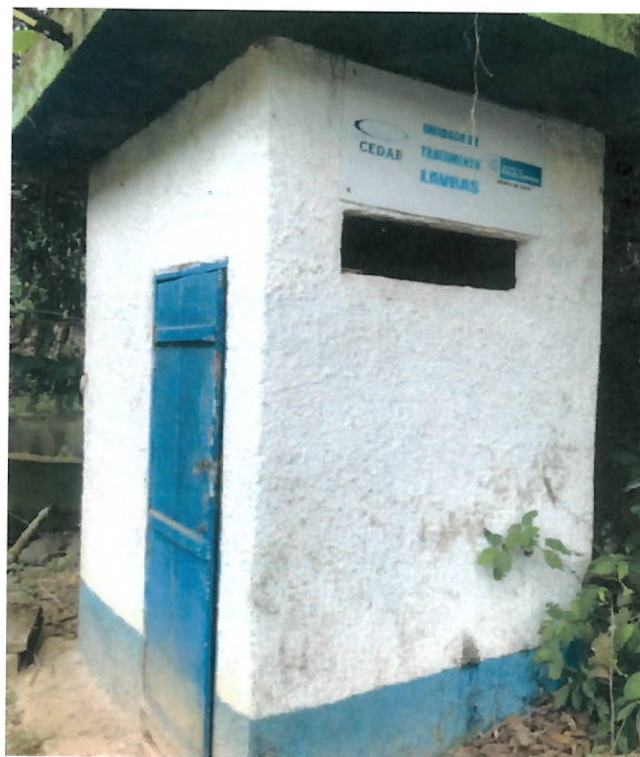
Foto 09 – Casa de química
