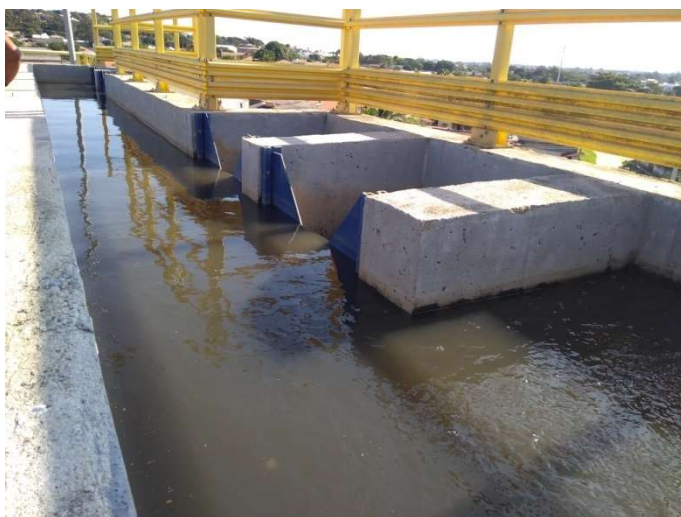
Foto 11 – Entrada do Esgoto Pré-tratado Para os Tanques de Aeração
