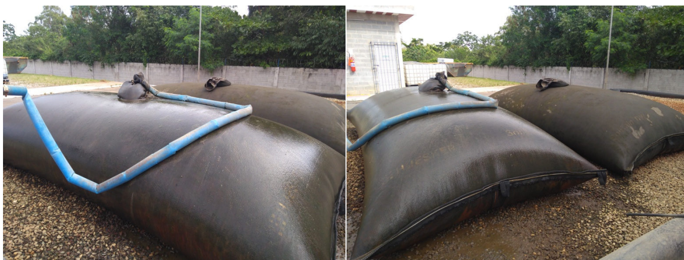
Foto 13 – (geobags) para realizar sua desidratação do lodo
