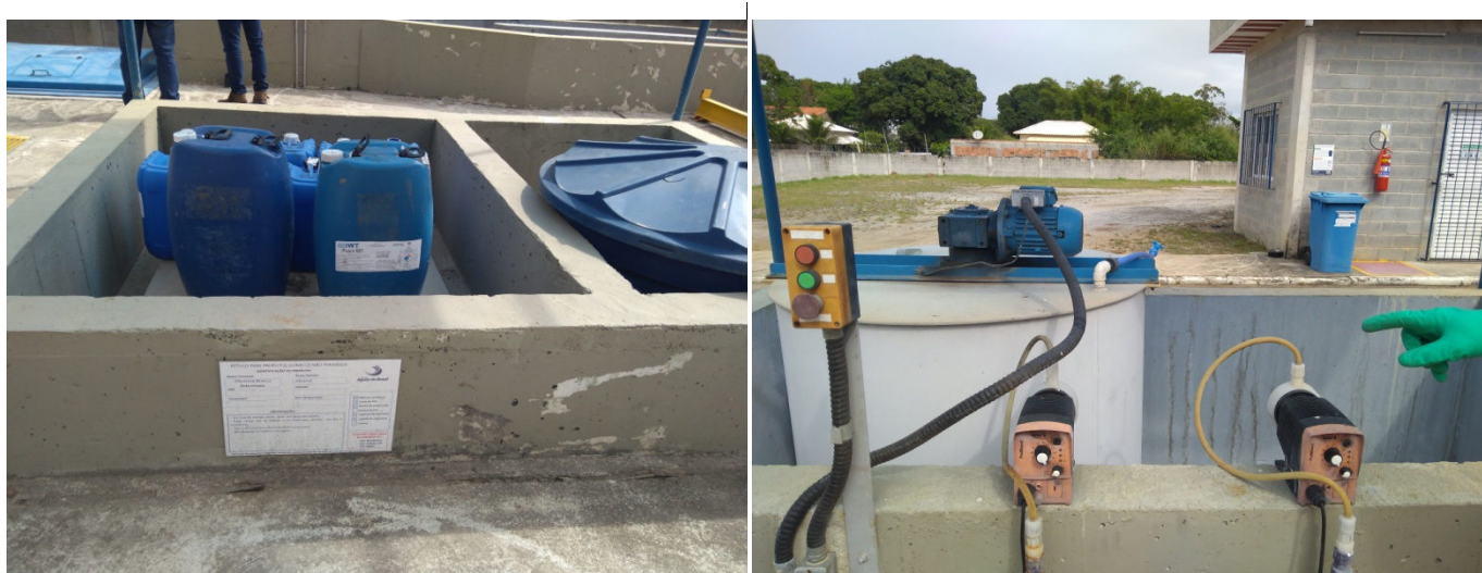
Foto 11 – Tanques de produtos químicos: antiespumante (imagem da esquerda) e mistura com dosagem de polímeros para secagem do lodo (imagem da direita)
