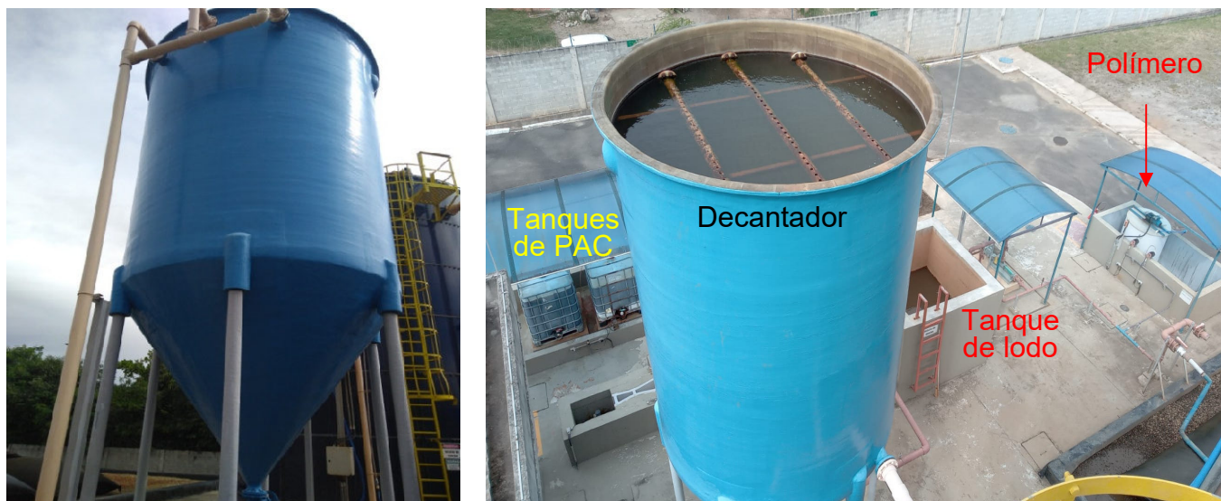
Foto 8 – Decantador secundário tipo lamelar (vistas laterais e superior)
