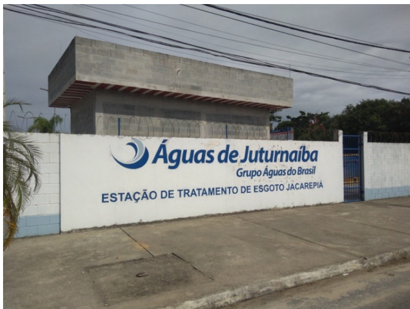
Foto 1 – Fachada da ETE Jacarepiá
