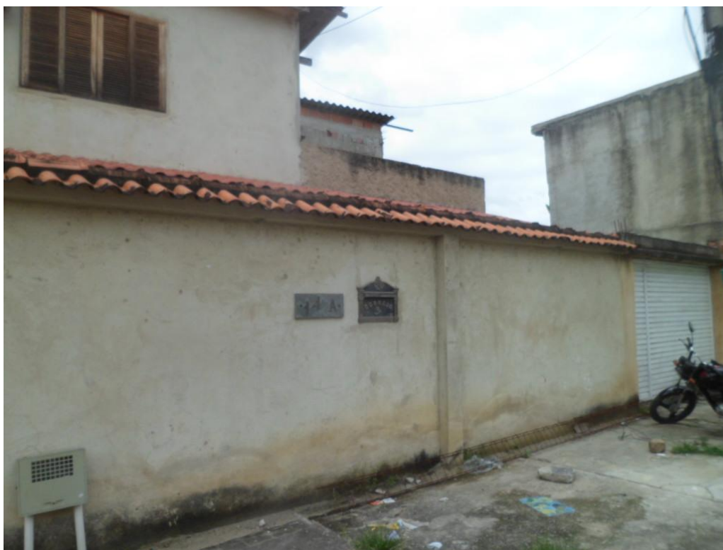
Foto 03 – Fachada da Casa Foco da Denúncia
