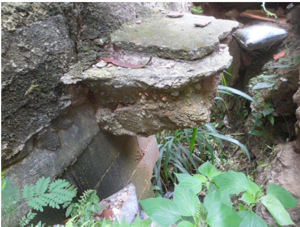
Foto 15 – Sapata do muro flutuando
