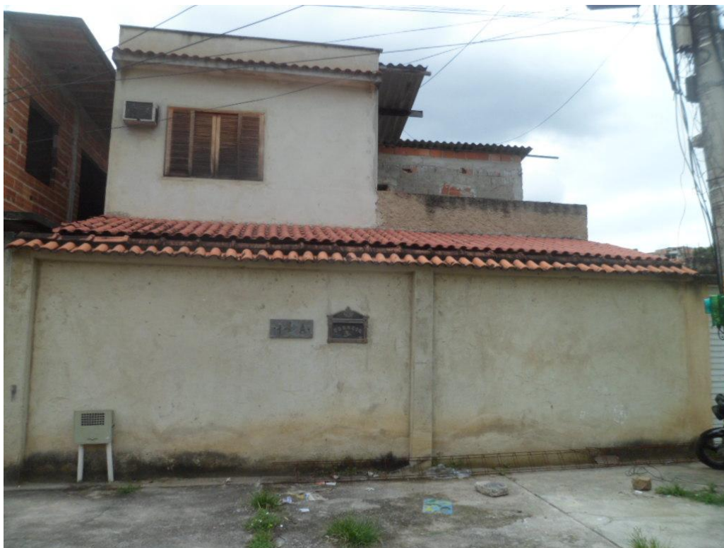
Foto 04 – Fachada da Casa Foco da Denúncia
