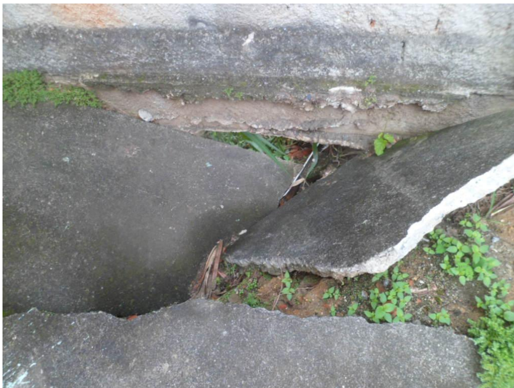
Foto 06 – Viga do Muro flutuante
