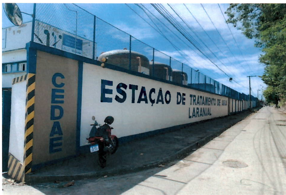
Entrada da ETA - Laranjal
