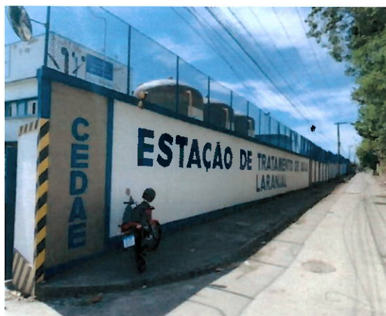
Entrada da Estação de Tratamento de Água de Laranjal
