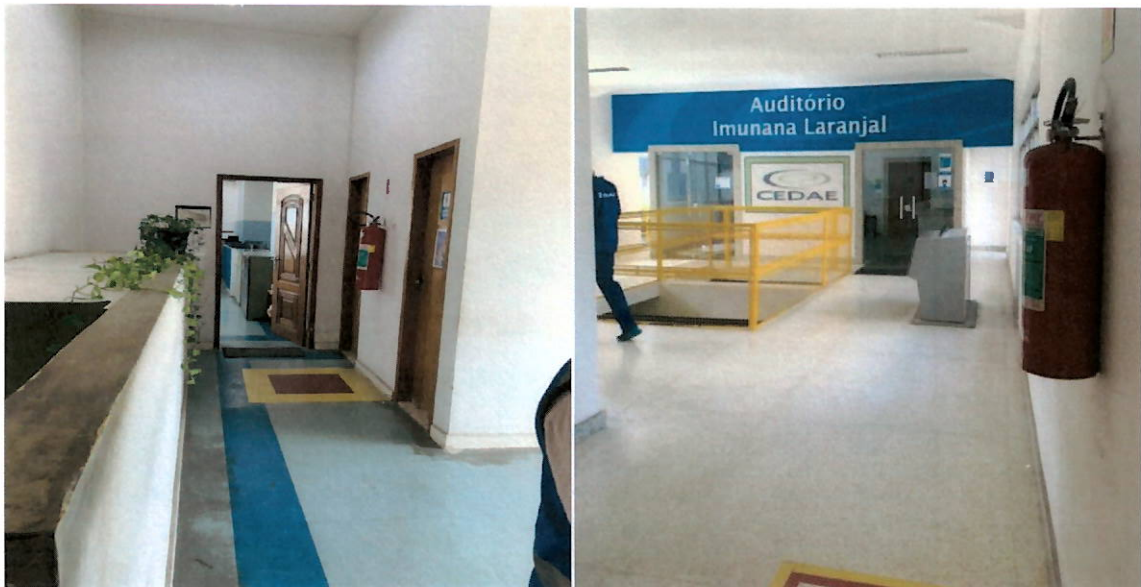
Extintores - Conforme NR 23
