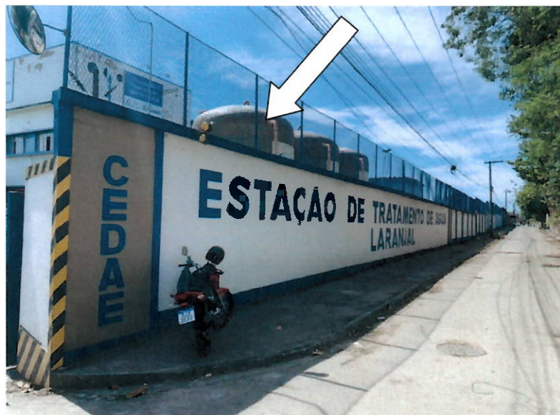
Coagulante – Sulfato de Alumínio
