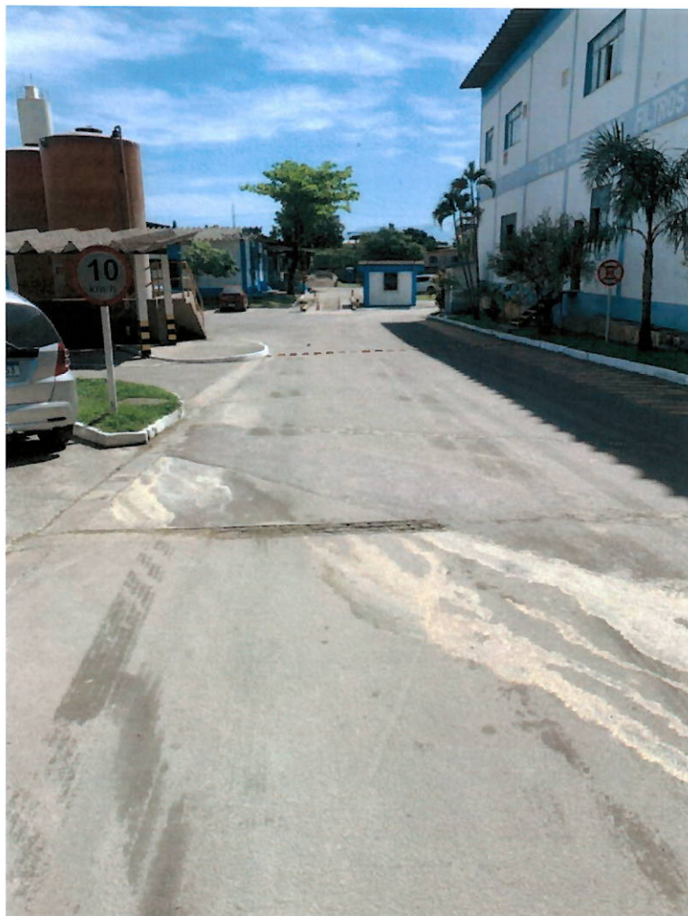
Pavimentação de acesso à ETA
