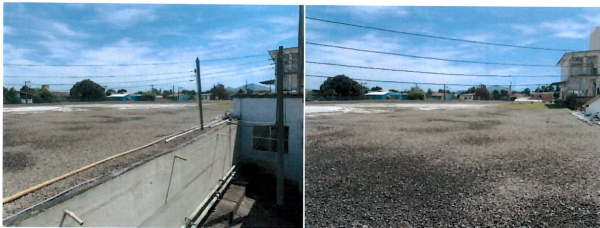
Reservatório (Parte superior)
