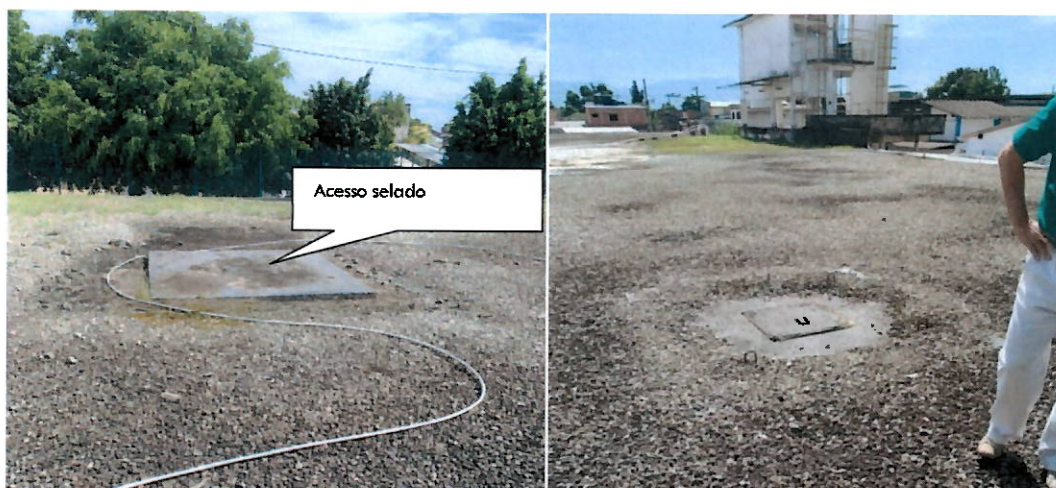
Reservatório (parte superior – vista das visitas)
