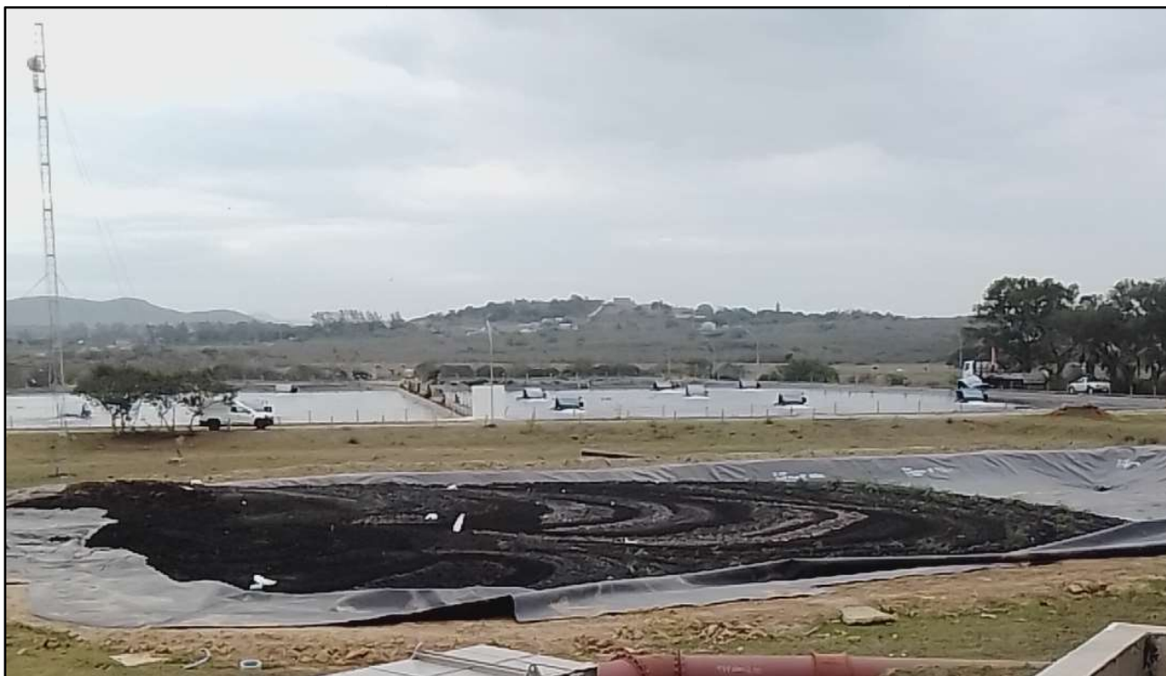
Figura 11 – Depósito de lodo das ETEs da PROLAGOS sobre mantas impermeáveis, objetivando testes para aproveitamento agrícola. Desidratação final do lodo a céu aberto por evaporação. Odor muito forte que pode impactar a vizinhança da ETE Jardim Esperança
