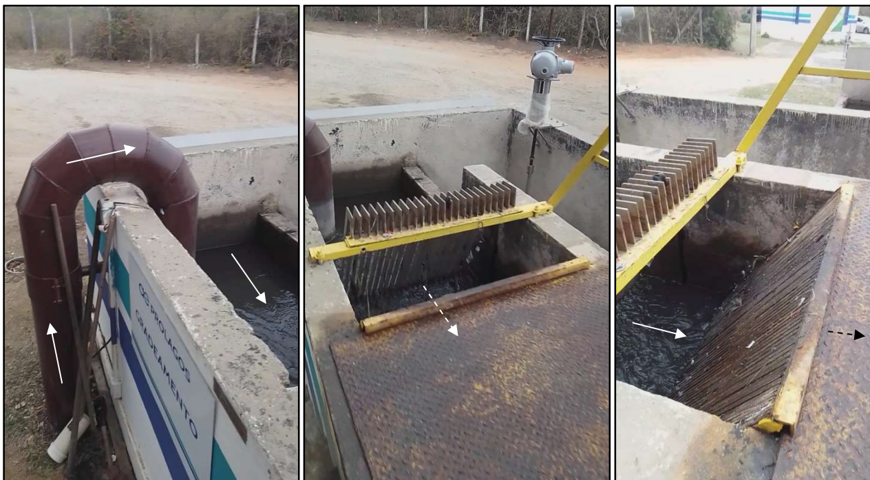
Figura 1 – Tratamento preliminar (trecho inicial): entrada afogada do recalque de esgoto bruto; gradeamento em barras a 45° com espaçamento (abertura) tipo grosso e limpeza manual; gradeamento de barras a 45° com espaçamento tipo fino e limpeza manual ( enferrujadas )
