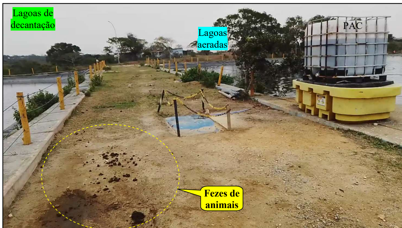
Figura 7 – Aplicação de PAC na transição entre as Lagoas aeradas e as Lagoas de Decantação (e maturação). Presença de animais terrestres na ETE ( fezes )
