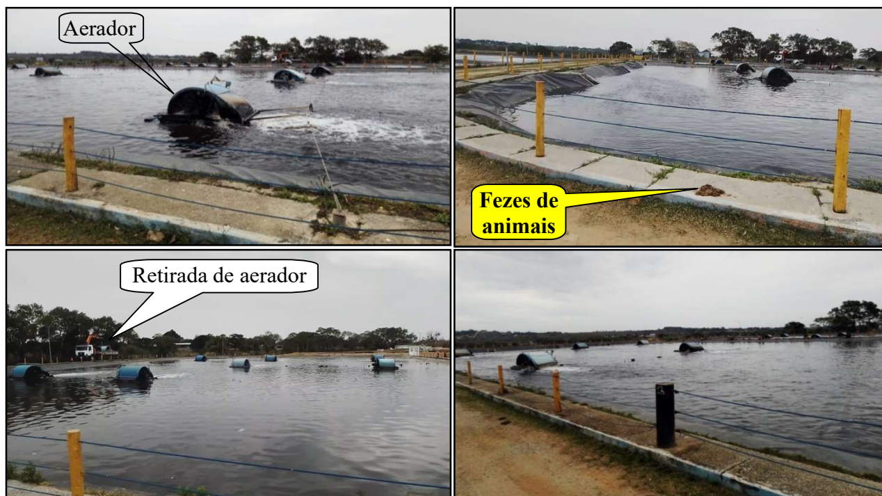
Figura 5 – Duas Lagoas Aeradas com 8 aeradores tipo cachoeira cada (no dia da vistoria, um aerador estava sendo retirado para manutenção). Presença de animais terrestres na ETE (fezes)
