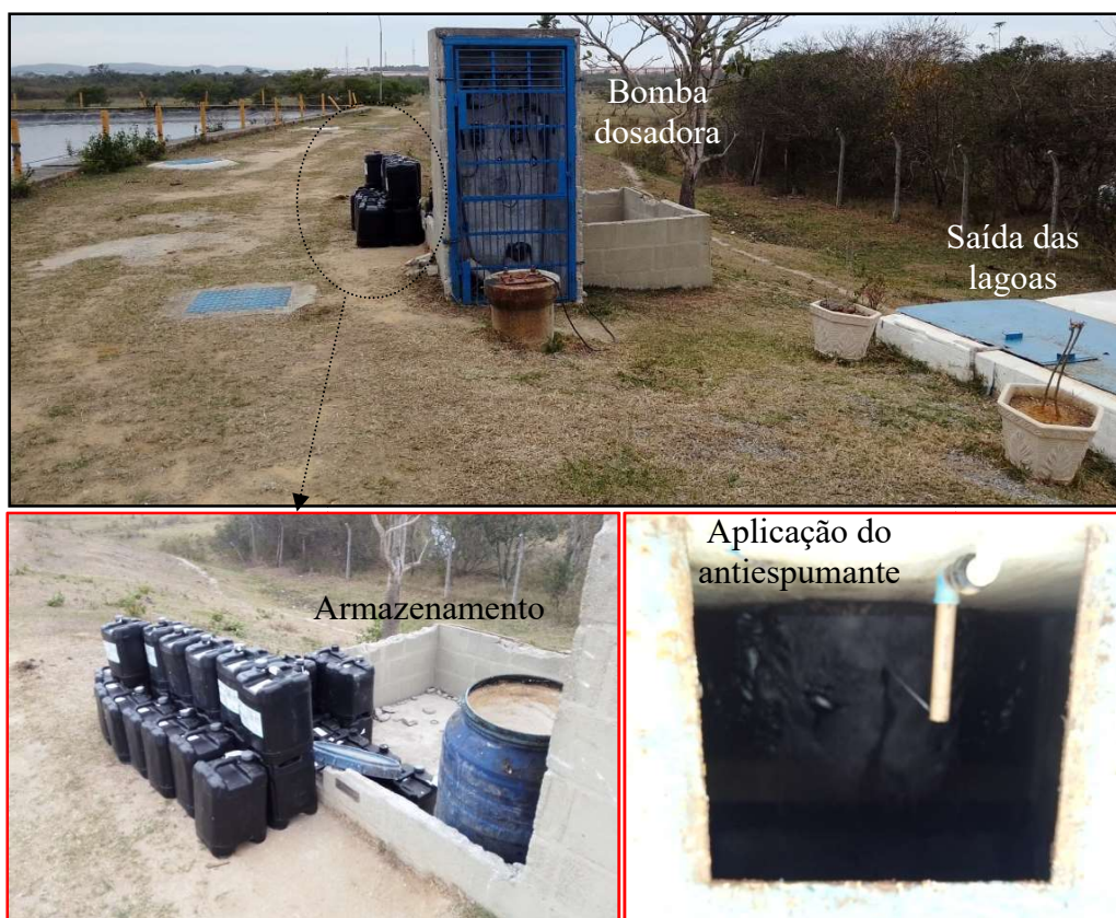
Figura 8 – Armazenamento e dosagem de antiespumante na saída das Lagoas de Maturação
