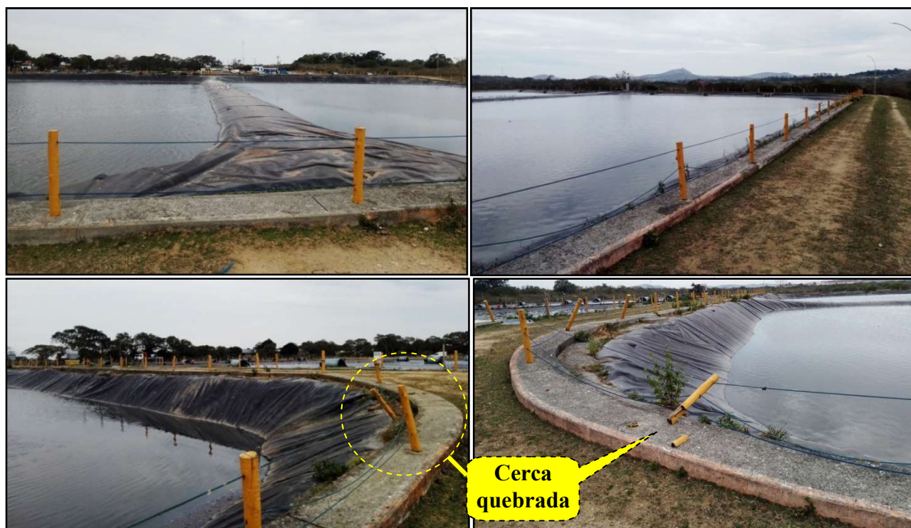
Figura 6 – Duas Lagoas de Decantação com Polimento (Maturação) para remoção de fósforo (coagulação com PAC). Cerca de proteção quebrada em alguns pontos
