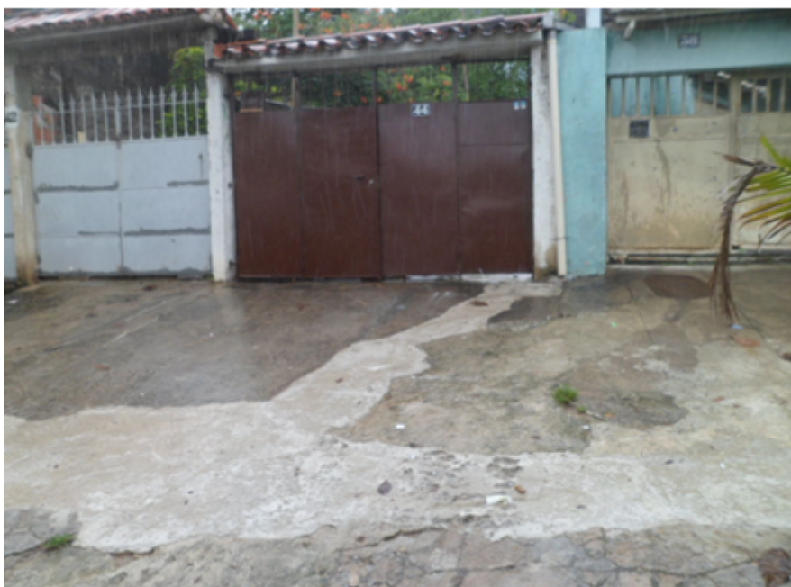
Foto 05 – Rua João de Deus, 38 e 44 – Interligadas pelo remanejamento
