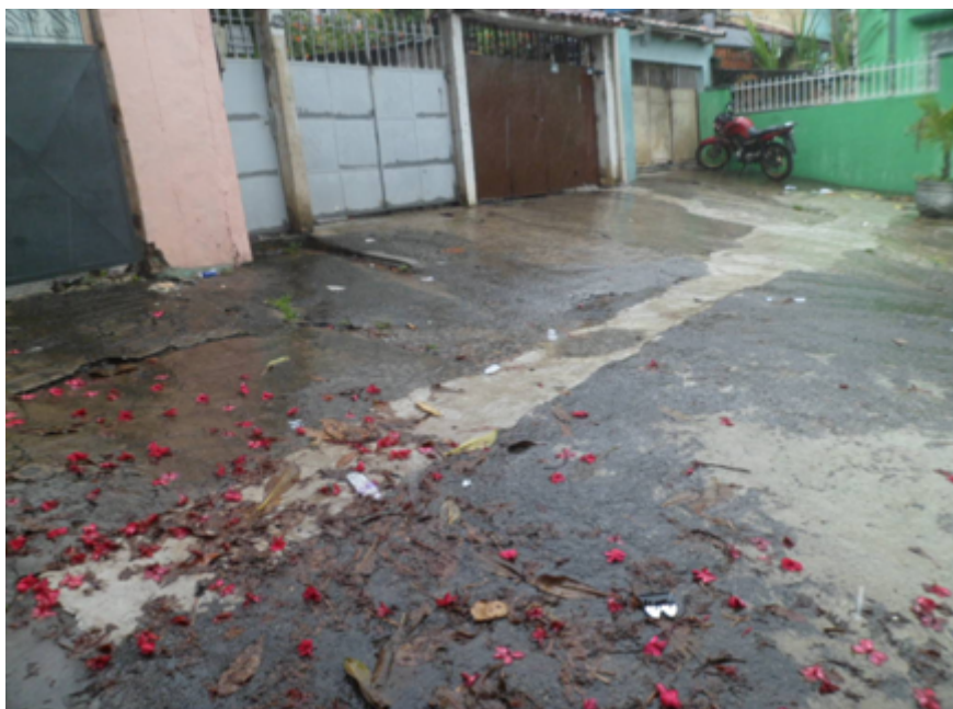
Foto 06 – Obras realizadas pela CEDAE
