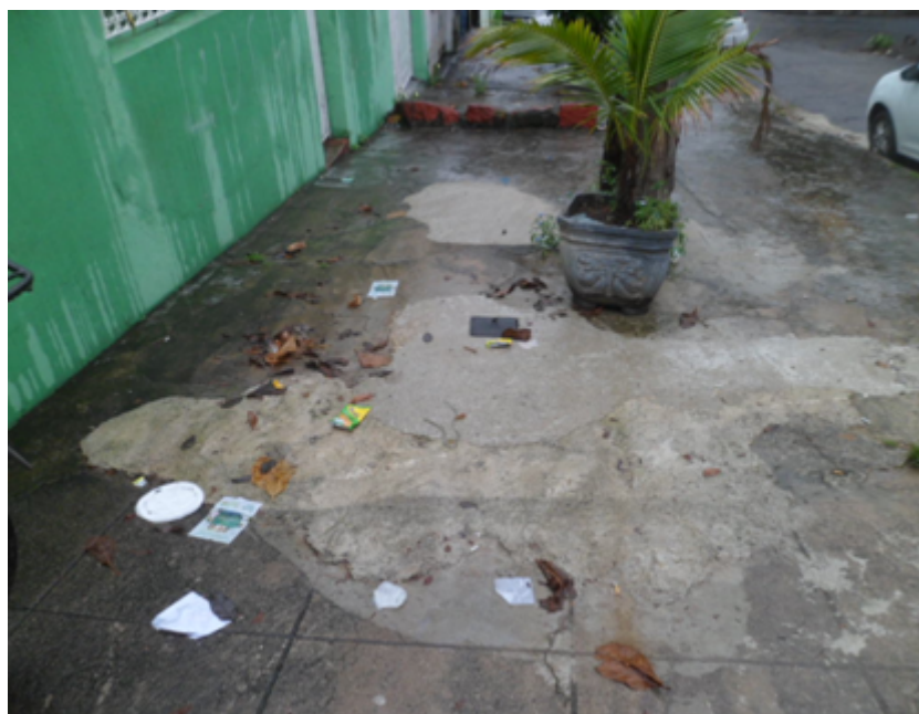
Foto 03 – Rua João de Deus nº 36 - obra realizada a partir deste ponto
