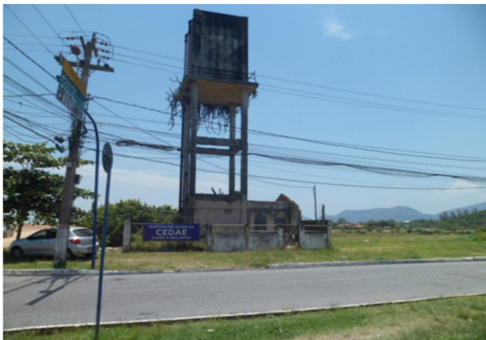
Foto 02 – Reservatório próximo à rua (risco aos pedestres e aos automóveis)
