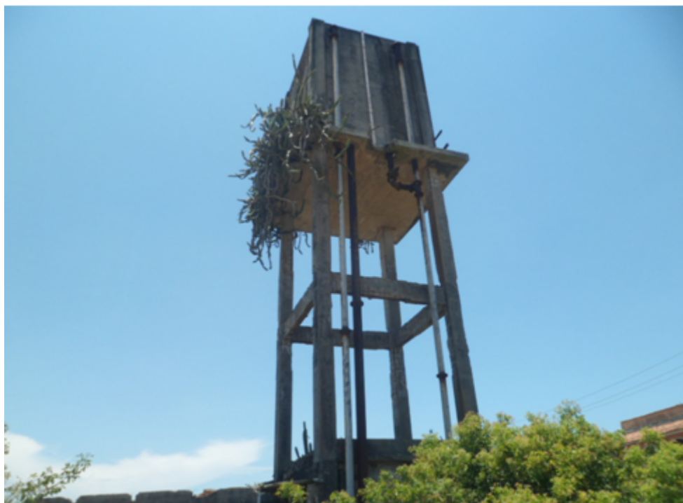
Foto 17 – Vista de todo reservatório
