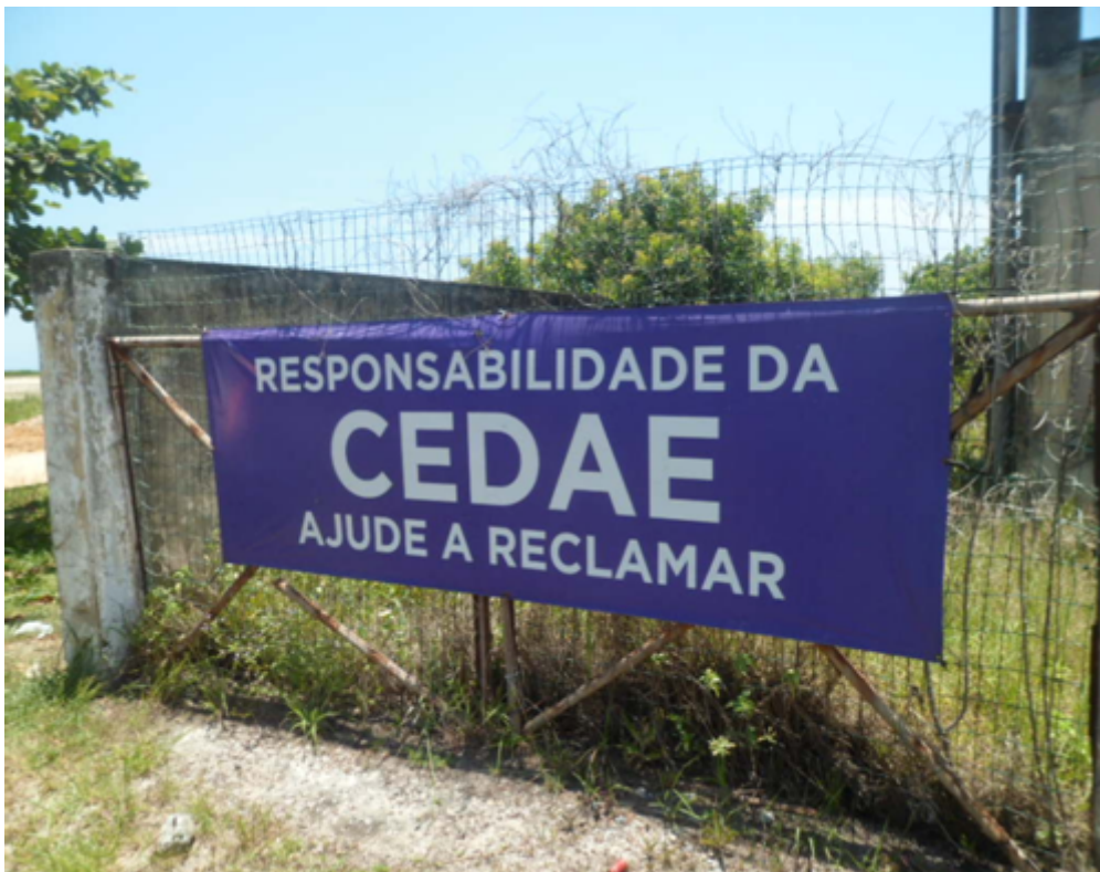
Foto 01 – Entrada do Reservatório
