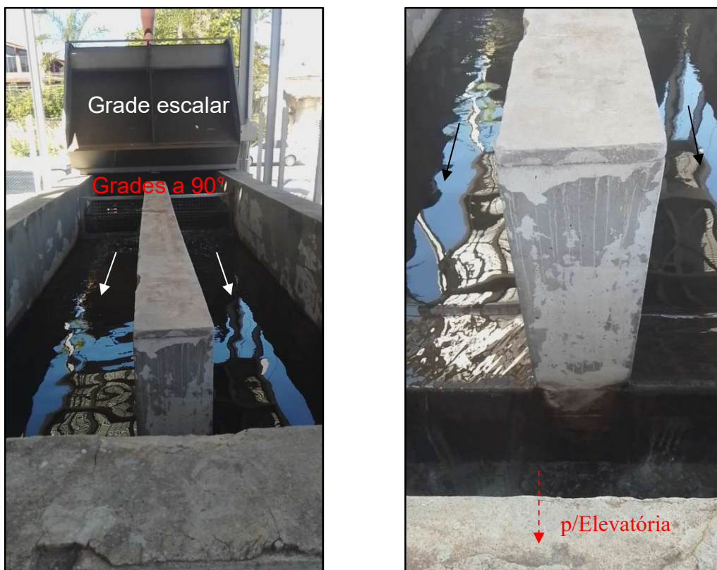
Figura 2 – Tratamento preliminar: desarenadores de limpeza manual (semanalmente). Dois canais em carga sem guias laterais para colocação de stop-logs e sem medidor de vazão de entrada
