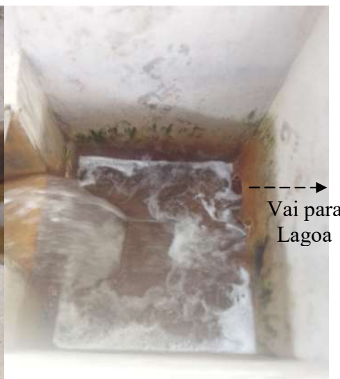
Figura 10 – Caixa de saída do efluente tratado com Medidor de vazão tipo Calha Parshall sem sensor ultrassônico e sem régua com escala de vazão visível . Destaque para a entrada afogada mas insuficiente para evitar a turbulência próximo à calha, a espuma formada e os aerossóis
