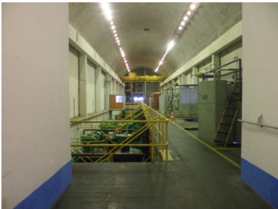
Foto 04 – Galeria de Válvulas e Bombas
