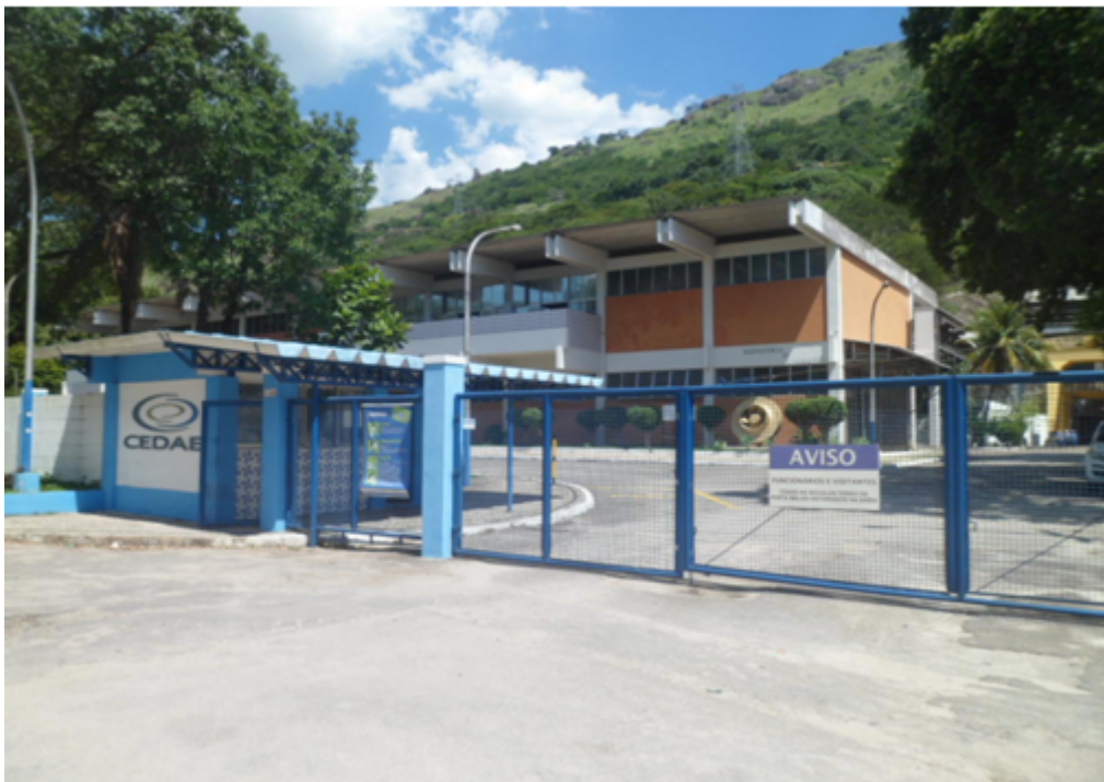
Foto 01 – Entrada da Estação Elevatória de Água do Lameirão
