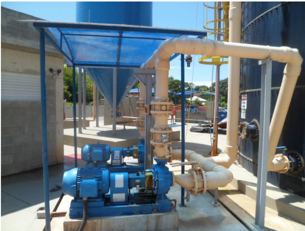
Foto 09 – Motores que Recalam de forma Ascendente para o Reator
