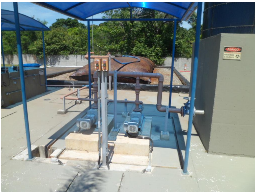
Foto 14 – Motores que bombeiam o Lodo para O Bag
