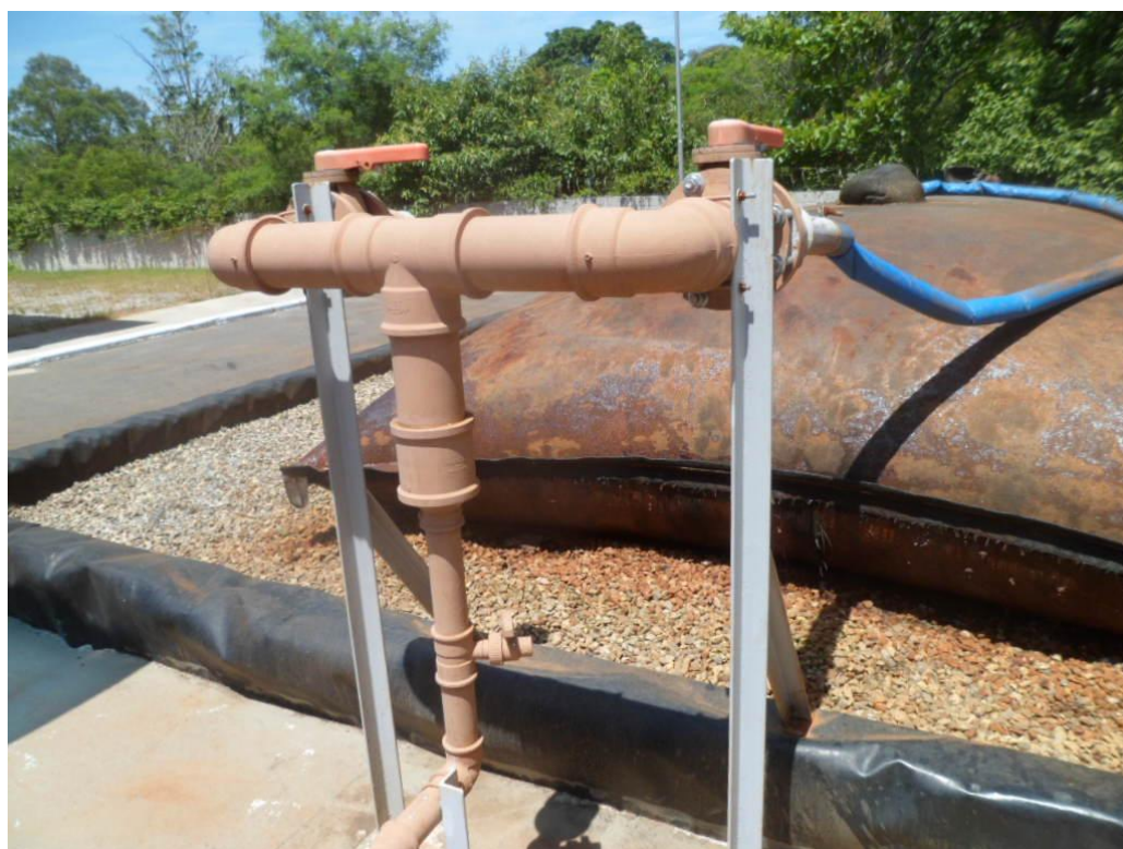
Foto 15 – Mangotes que Abastecem o Bag para Desidratação de Lodo
