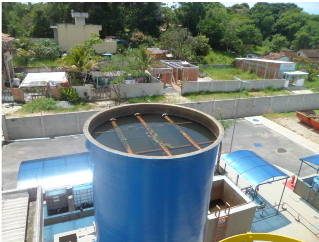
Foto 12 – Tanque de Decantação (Vista Superior)
