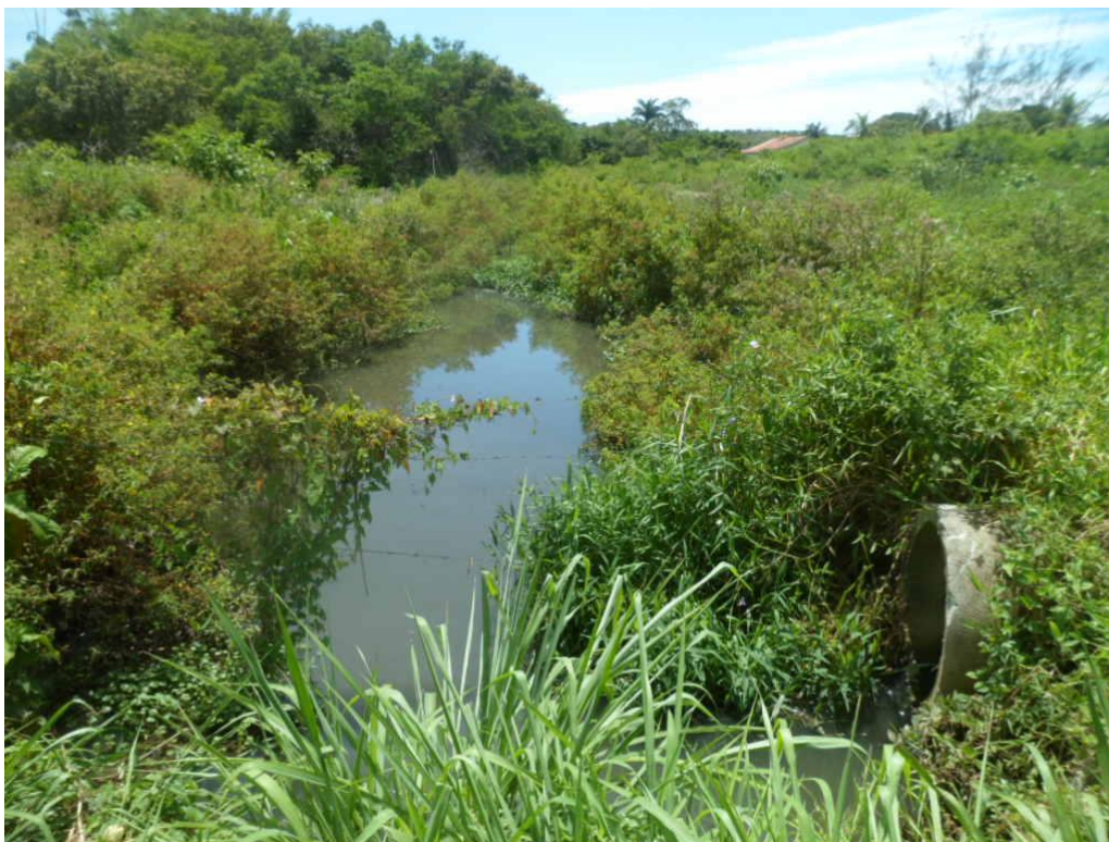
Foto 22 – Saída do Esgoto Tratado no Rio da Arraia
