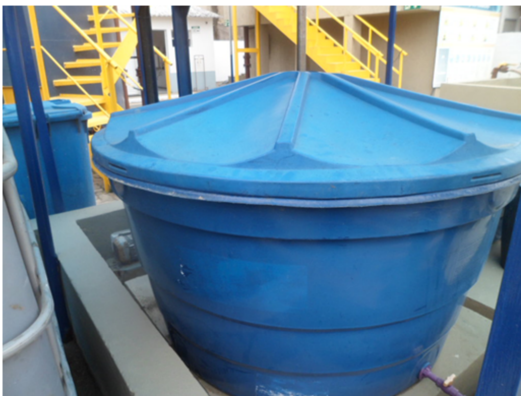
Foto 11 – Tanque Antiespumante
