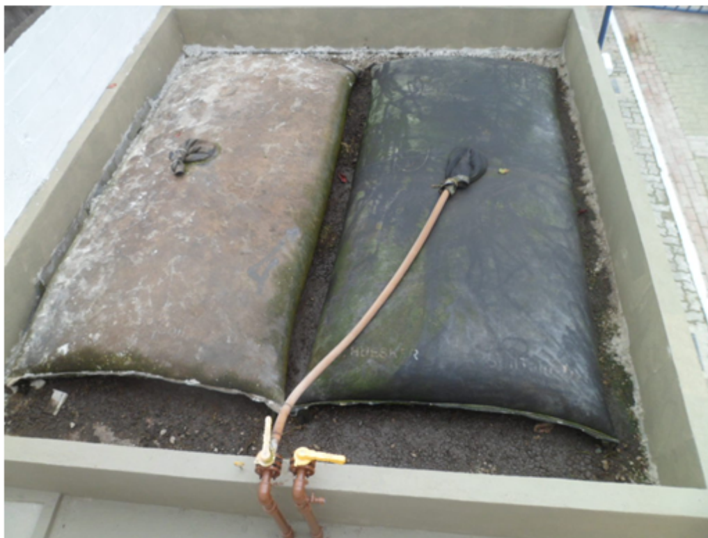
Foto 22 – Mangotes que Abastecem os Bags para Desidratação de Lodo (Vista Superior)
