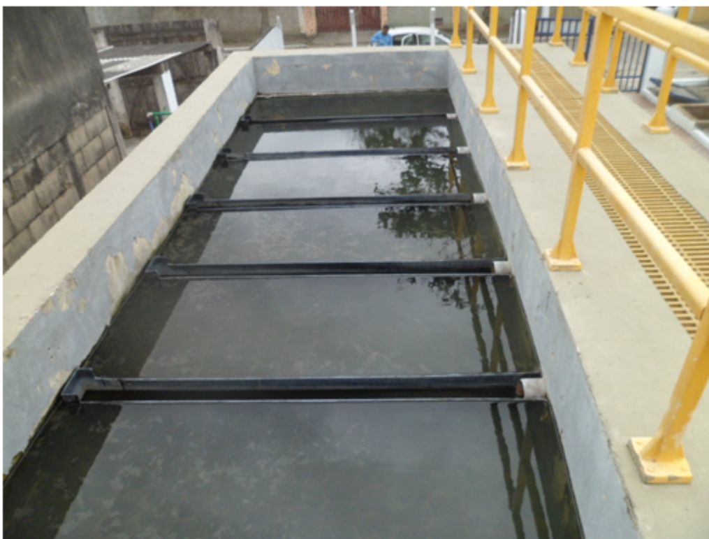
Foto 17 – Tanque de Decantação
