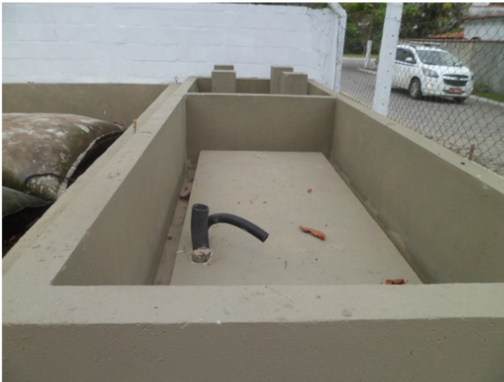
Foto 24 – Espaço Reservado para Instalação de Gerador e Tanque de Diesel
