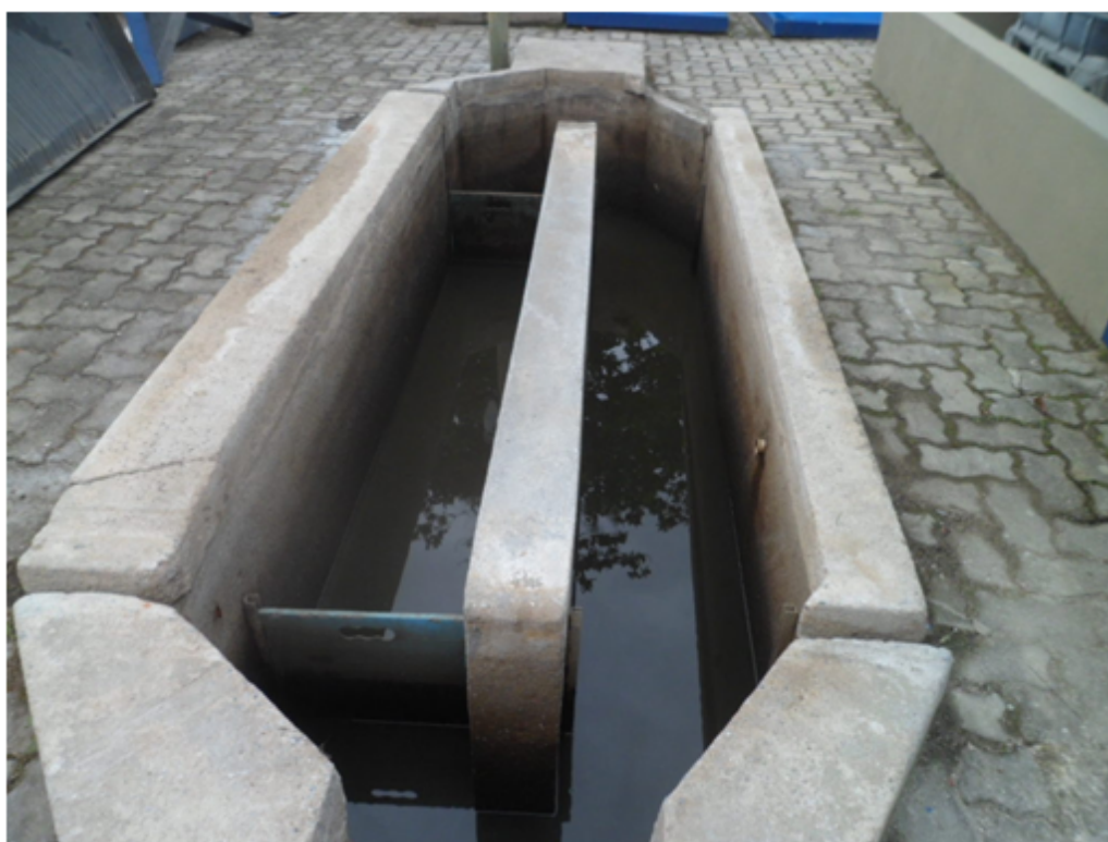
Foto 05 – Caixas de Areia
