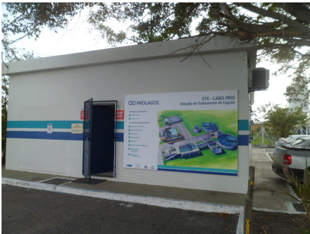
Foto 19 – Escritório da Estação de Tratamento
