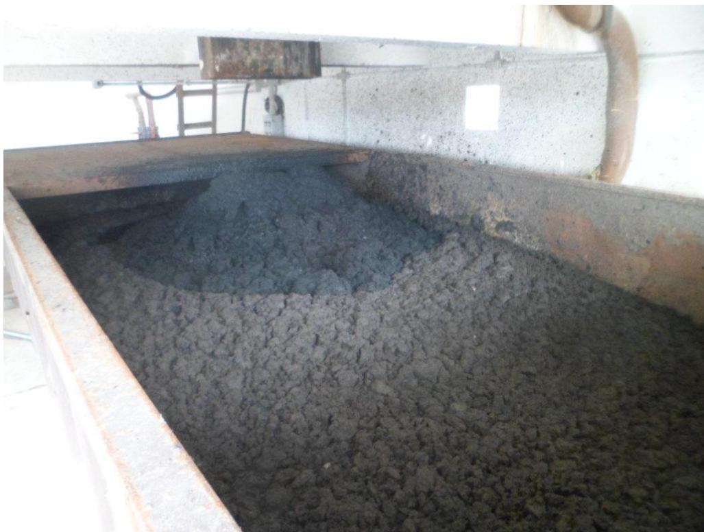
Foto 17 – Armazenamento de Lodo na Caçamba
