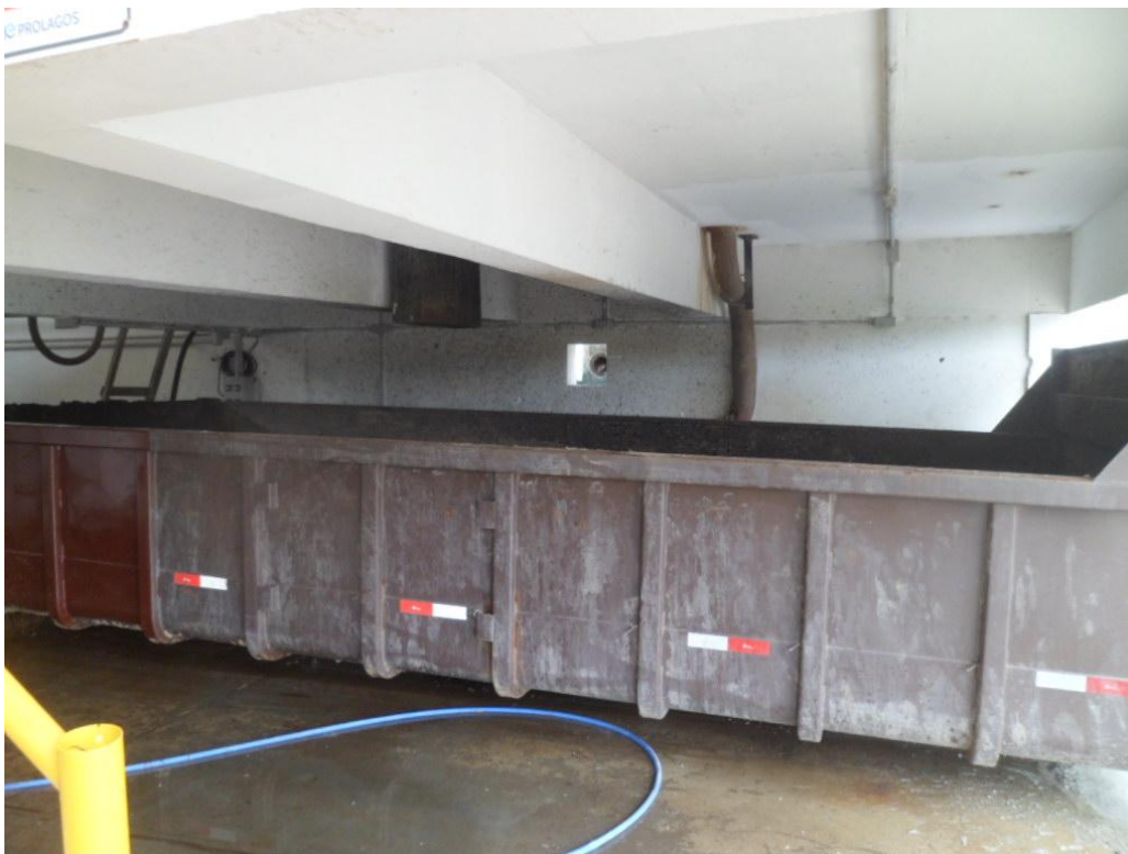
Foto 16 – Caçamba de Retirada do Lodo (7m 3 a cada dois dias)
