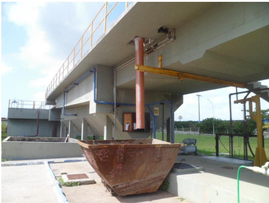
Foto 06 – Caçamba de Armazenamento dos Resíduos Sólidos das Pás Mecânicas
