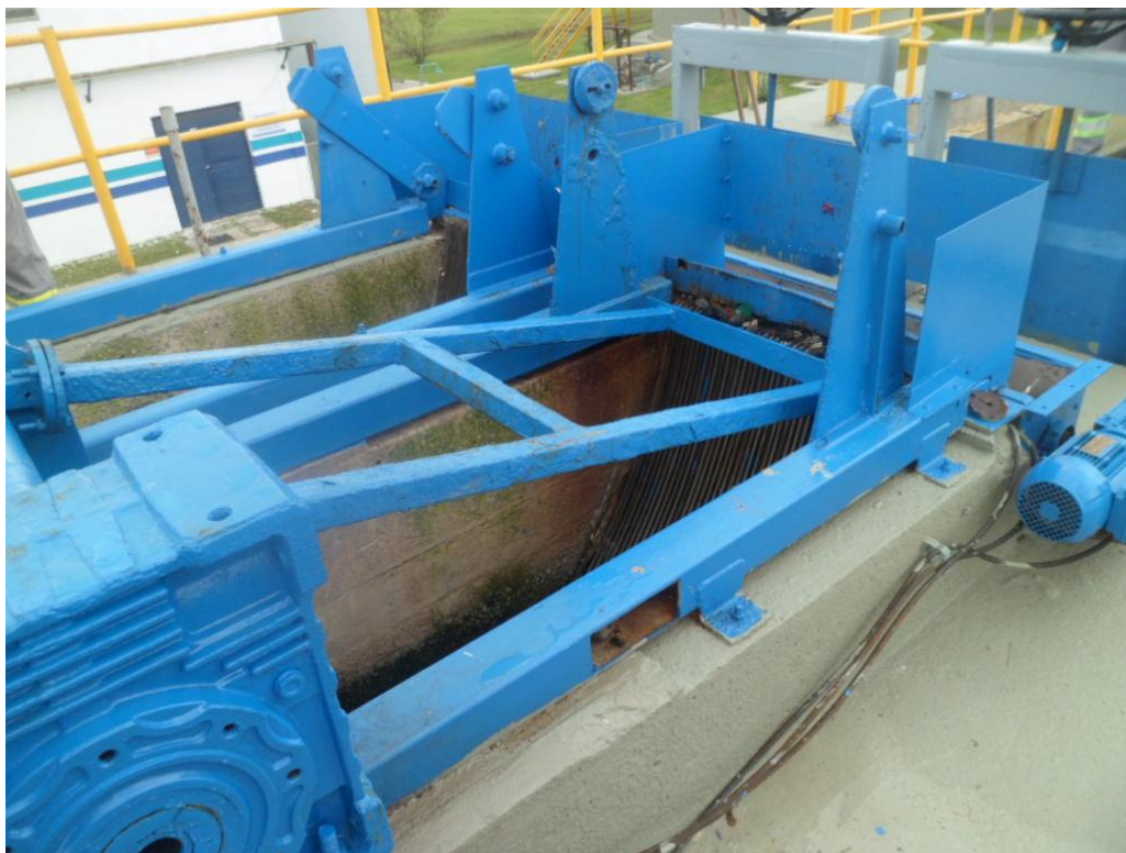
Foto 04 – Gradeamento Mecanizado
