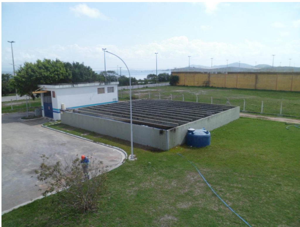
Foto 22– Câmara de Contato de Desinfecção (Vista Diagonal Superior)
