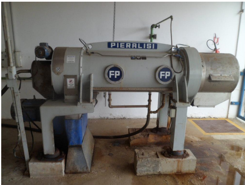
Foto 15 – Centrífuga (Desidratação de Lodo)
