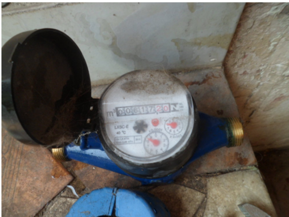
Foto 03 – Hidrômetro já retirado
