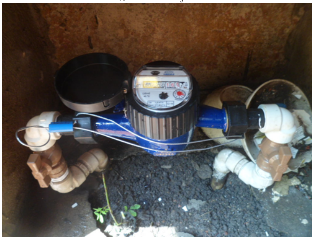
Foto 04 – Hidrômetro novo instalado
