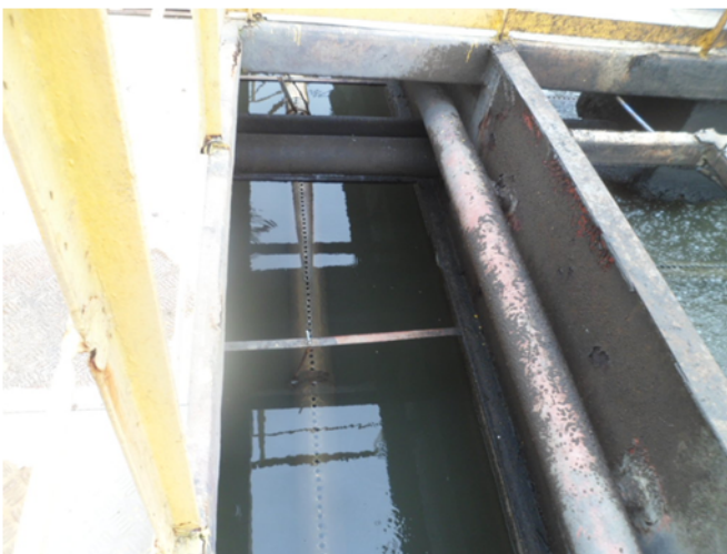
Foto 19 – Tanque de Decantação
