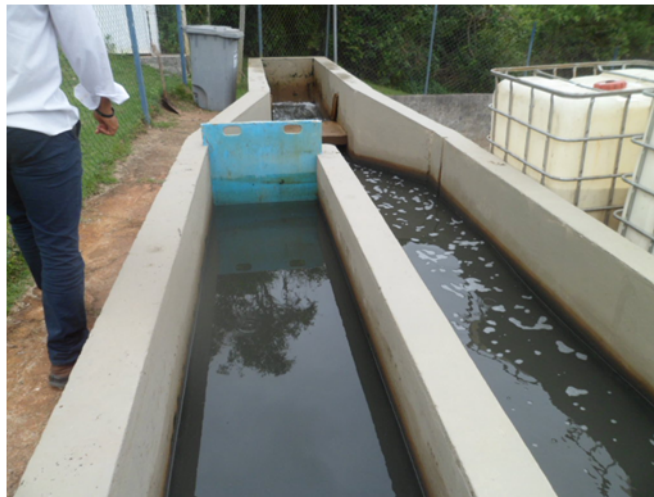
Foto 09 – Caixas de Areia
