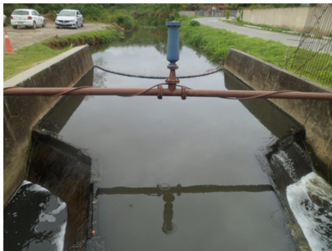
Foto 04 – Interceptor no Rio Bacaxá (Extravasando por Conta das Chuvas) a Montante
