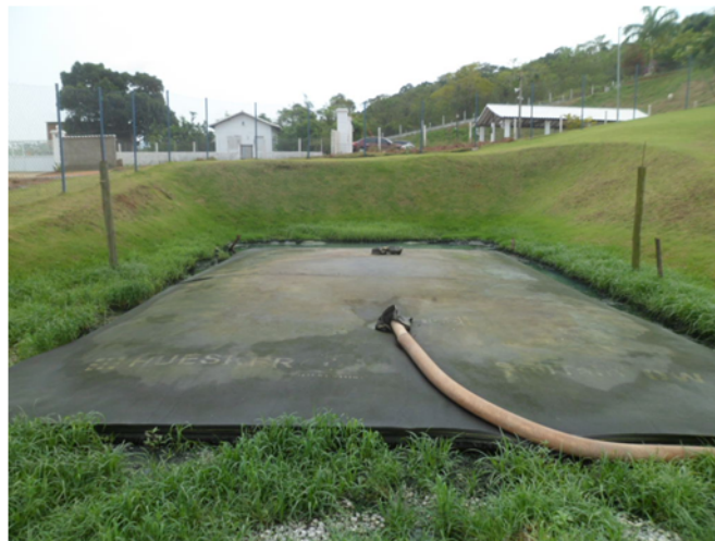
Foto 22 – Bag para Desidratação de Lodo
