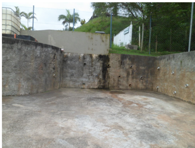
Foto 07 – Parada de Caminhão Hidrovácuo na Entrada do Esgoto Bruto
