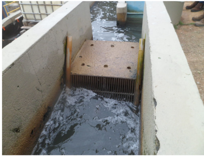
Foto 08 – Gradeamento Fino para Retenção de Resíduos Sólidos
