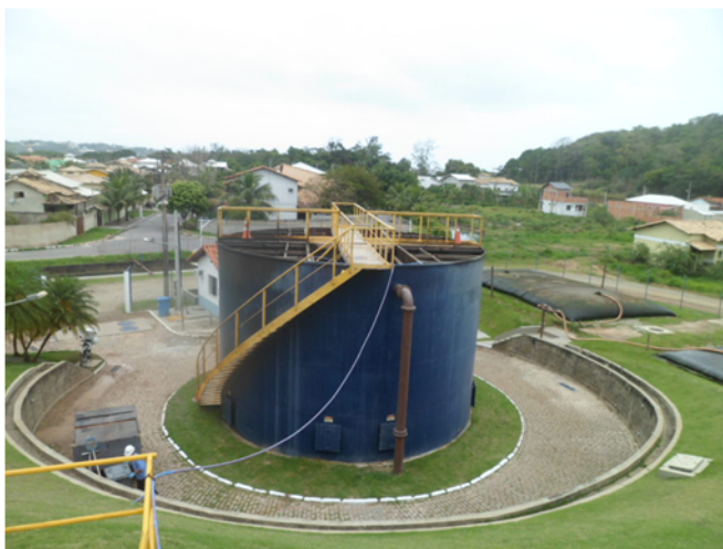
Foto 16 – Tanque de Aeração e Decantação Vista Lateral
