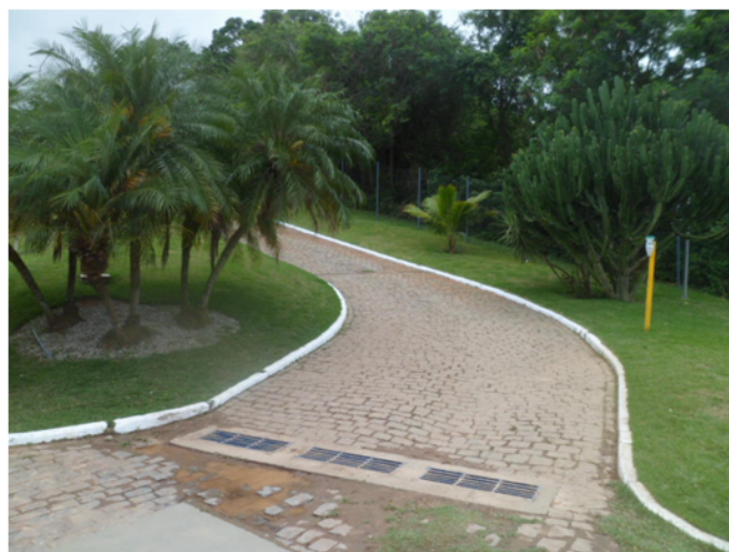
Foto 06 – Rampa de Acesso a Parte Preliminar do Processo de Tratamento
