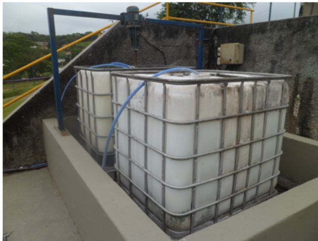
Foto 12 – Tanques de Antiespumante
