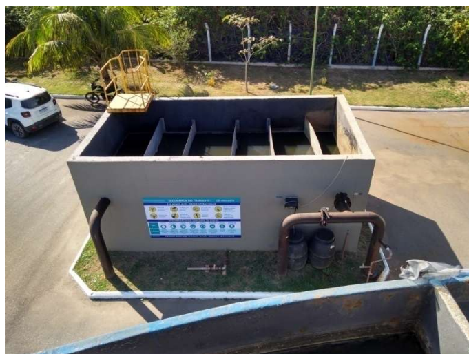
Foto 12 – Tanque de Contato (vista superior)
