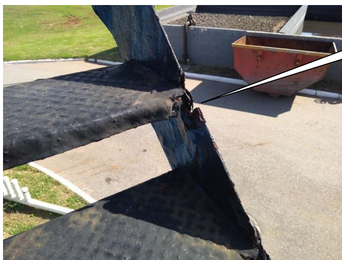
Foto 23 – Escada de Acesso ao Reator com degraus deteriorado
