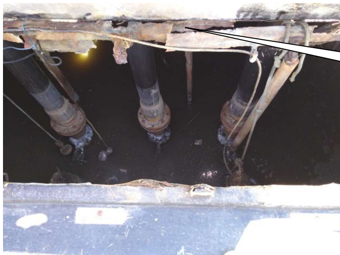
Foto 25 – Ferragens da Elevatória Deteriorada com Ferrugens
