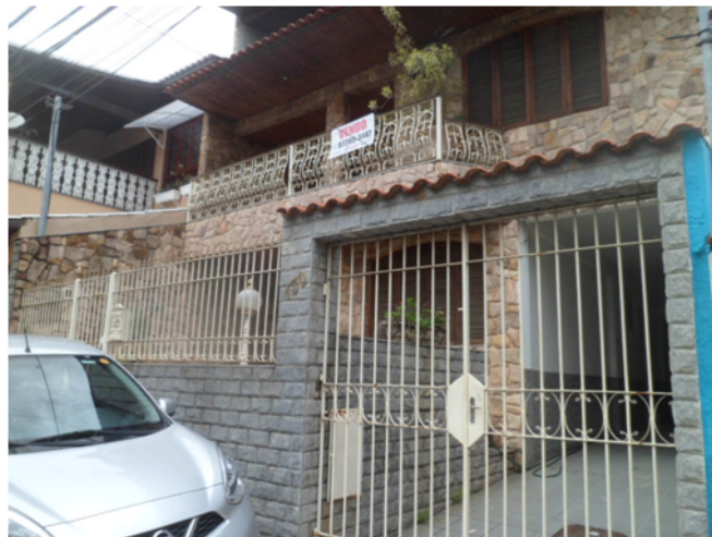
Foto 01 – Rua Modesto de Souza, 130 – Bangu, Facha da Casa Foco da Denúncia
