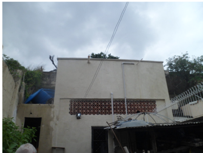
Foto 07 – Reservatório do Condomínio em funcionamento que atende a Rua Modesto de Souza
