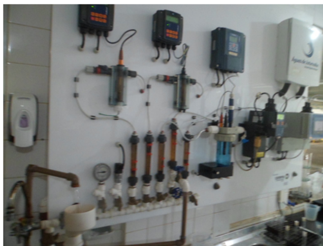
Foto 05 – Local de Monitoramento da ETA Medidores (Vazão, Fluor, Turbidez, PH)
