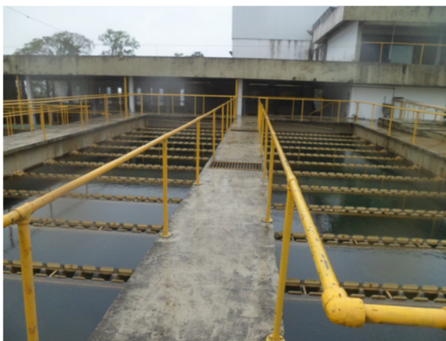
Foto 17 – Tanques Decantadores
