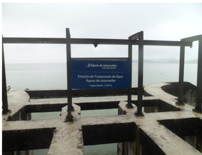
Foto 11 – Entrada da Água Bruta (Ponto de Captação da Lagoa)
