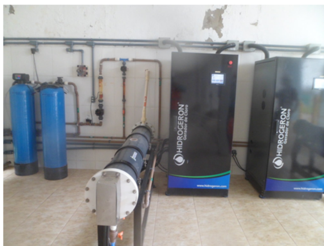
Foto 19 – Equipamento Hidrogeron Produção de (Hipoclorito de Sódio)
