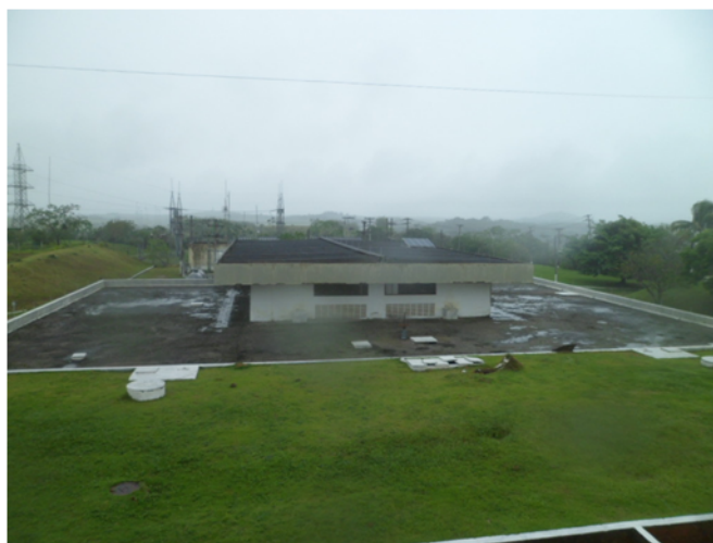
Foto 21 – Reservatório de Água Tratada
