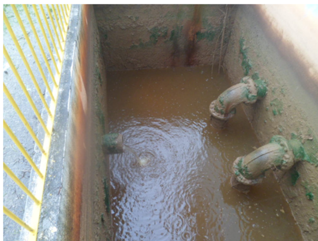
Foto 25 – Água dos Bags Recalcadas para o Início do Processo de Tratamento
