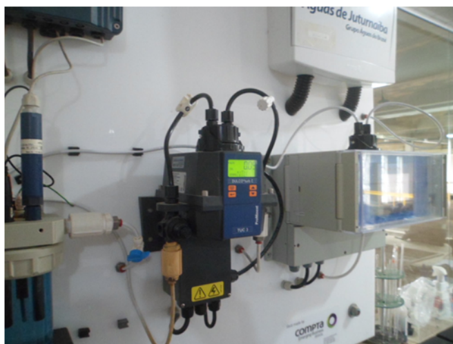
Foto 06 – Local de Monitoramento da ETA Medidores (Vazão, Fluor, Turbidez, PH)
