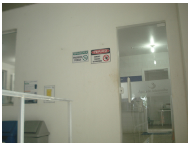
Foto 03 – Entrada do Local de Monitoramento da ETA
