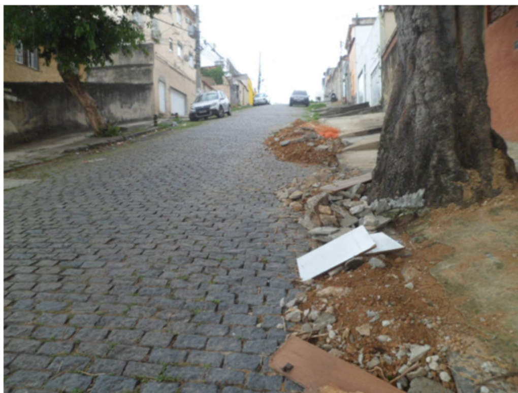
Foto 04 – Substituição de Tubulação 75mm na Rua Joaquim Martins a partir do nº 72
