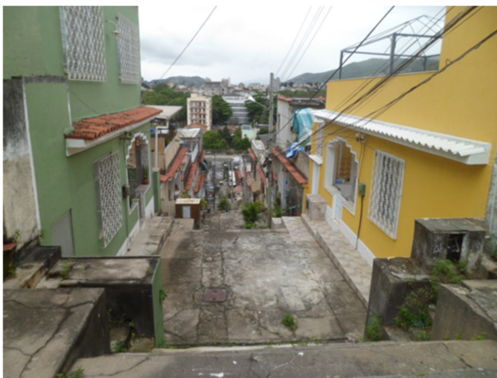
Foto 10 – Área Interna da Vila, Rua Pompilho de Albuquerque, 232, (Outra Vista)
