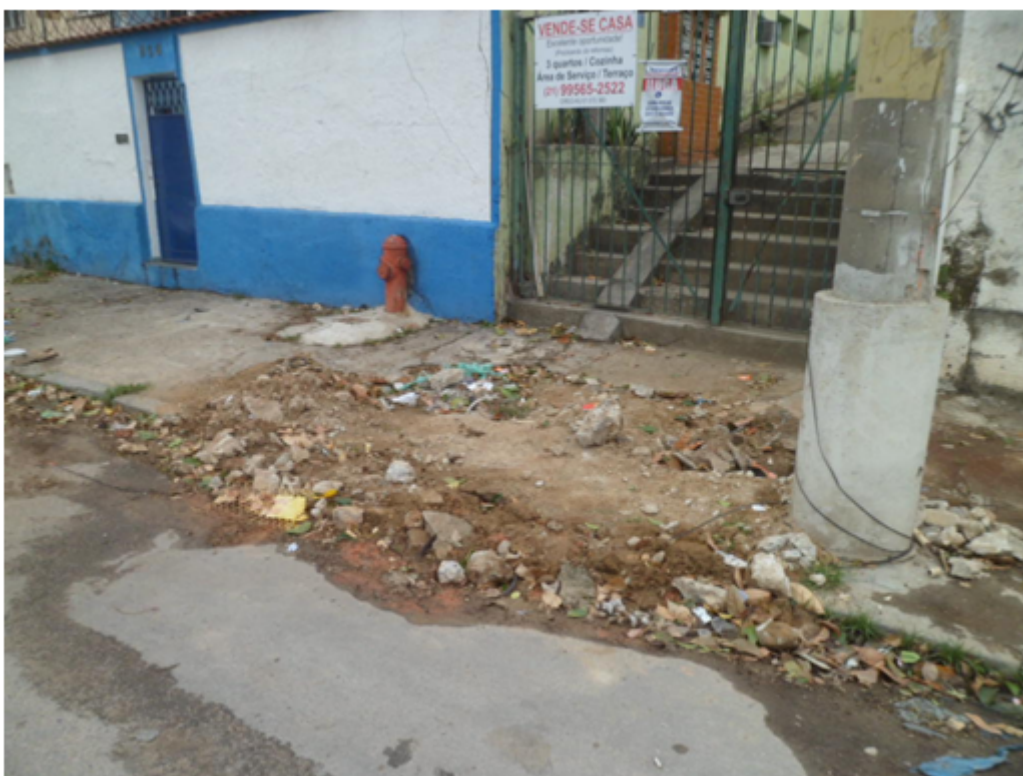
Foto 02 – Substituição de Ramal na Entrada da Vila
