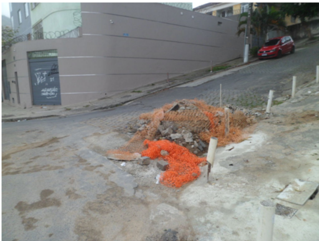
Foto 03 – Substituição de Tubulação na Rua Joaquim Martins com Pompilho de Albuquerque
