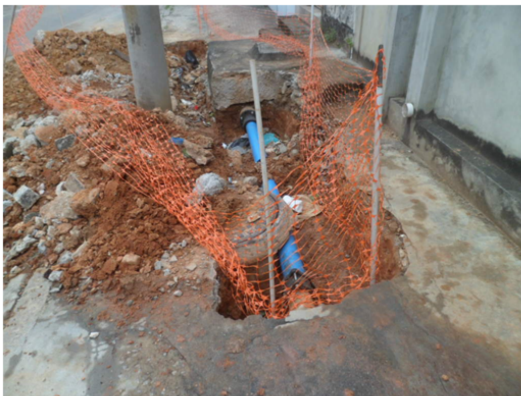
Foto 06 – Substituição de Registro em frente ao nº 202 da Rua Pompilho de Albuquerque
