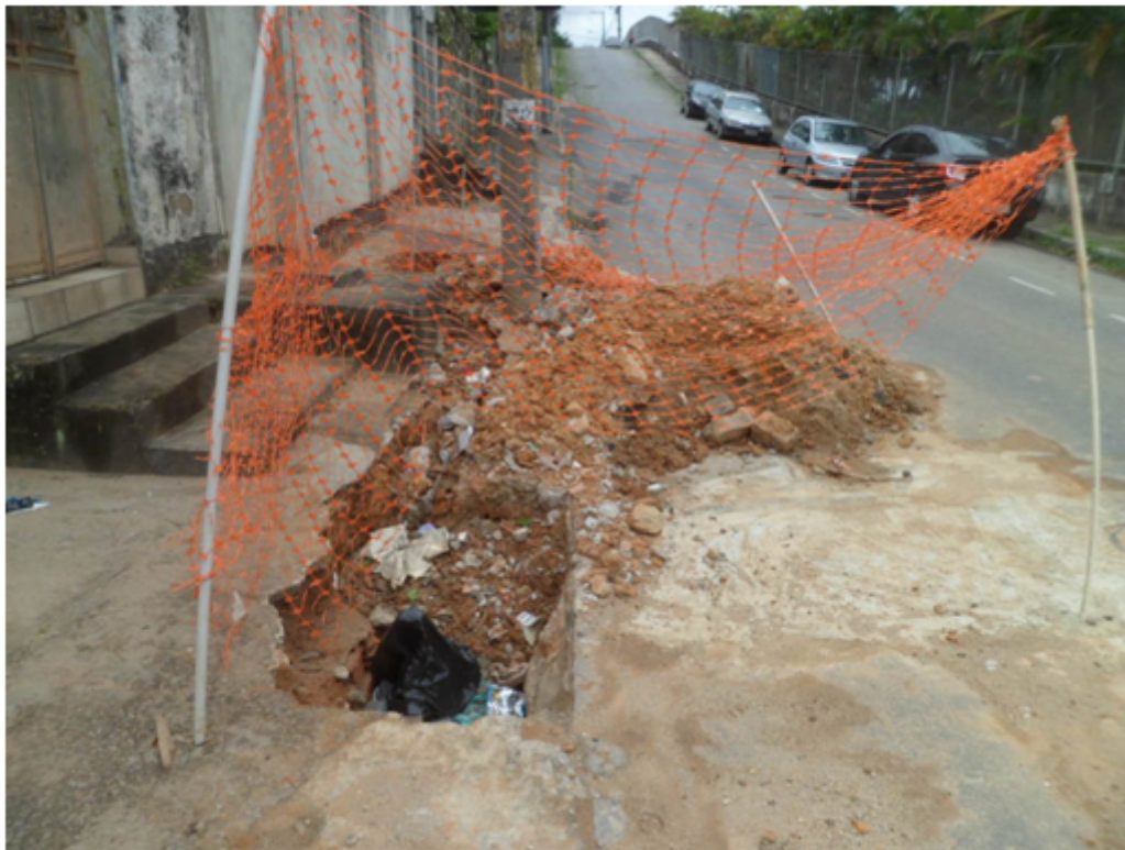
Foto 07 – Substituição de Registro em frente ao nº 202 da Rua Pompilho de Albuquerque
