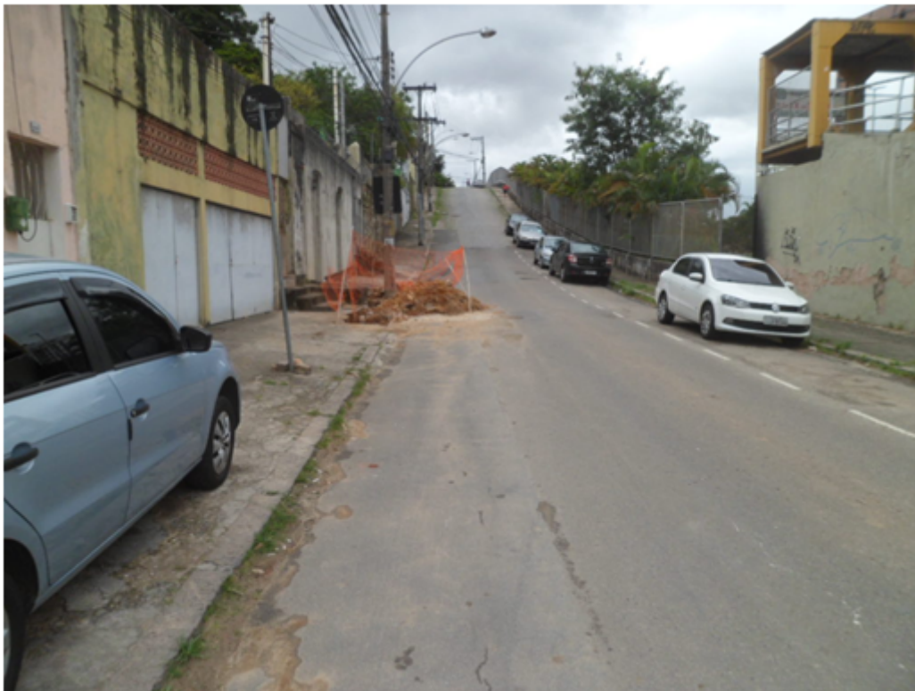
Foto 05 – Substituição de Registro em frente ao nº 202 da Rua Pompilho de Albuquerque
