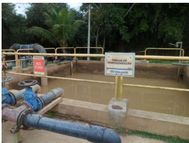
Foto 19 – Tanque de Homogeneizado de Lodo 9000 litros
