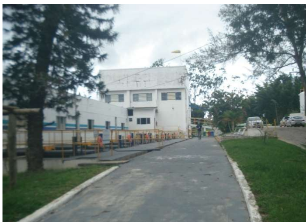
Foto 02 – Alameda Principal da ETA
