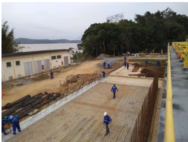
Foto 35 – Obras de Ampliação da ETA
