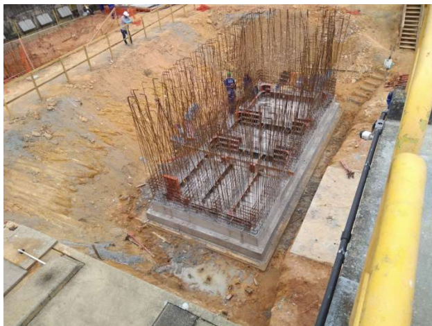
Foto 36 – Obras de Ampliação da ETA
