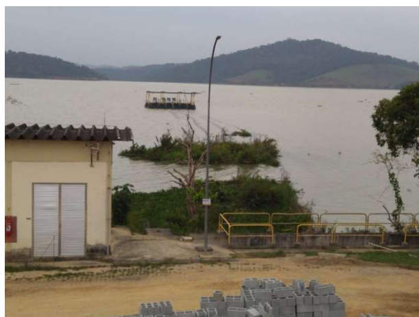
Foto 04 – Balsa de Captação à 210 metros da ETA
