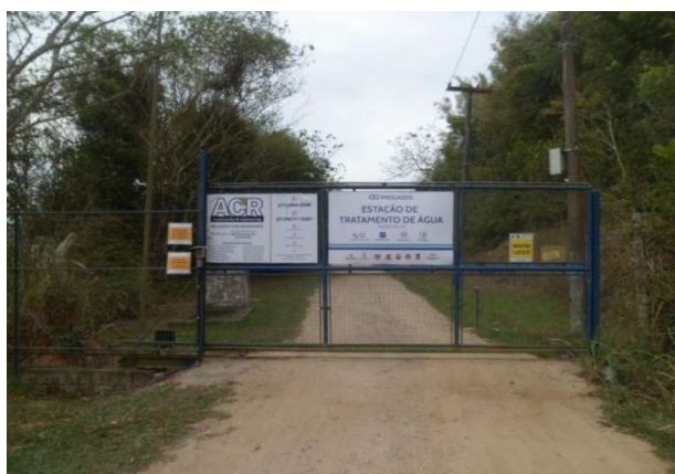
Foto 01 – Entrada da Estação de Tratamento de Água
