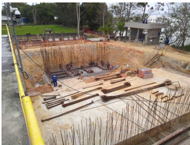
Foto 34 – Obras de Ampliação da ETA
