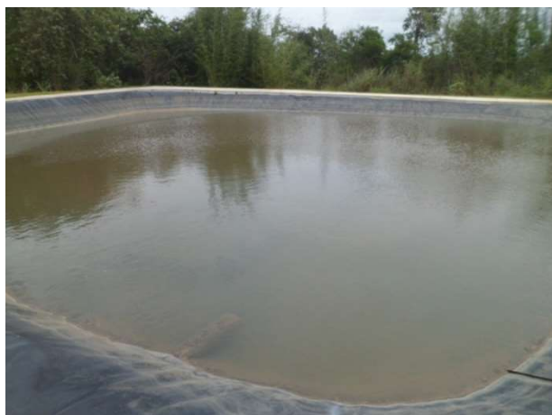
Foto 23 – Lagoa de Água de Lavagem dos Filtros 60.000 litros
