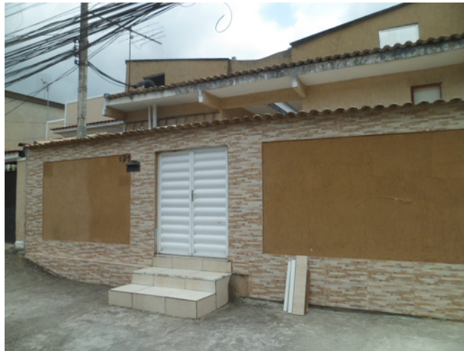
Foto 01 – Fachada da residência do reclamante – Rua Caroá, 127 – Curicica - Jacarepaguá
