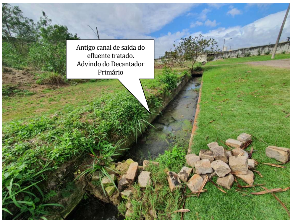
Foto 34 – antiga saída do decantador primário
