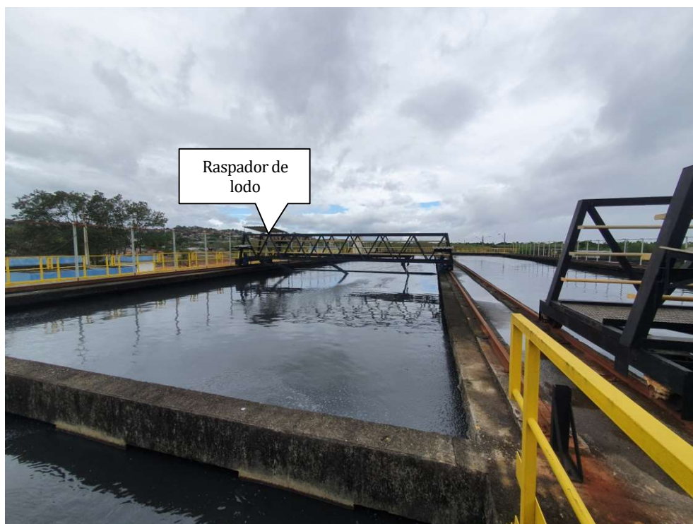
Foto 12 – Decantador primário
