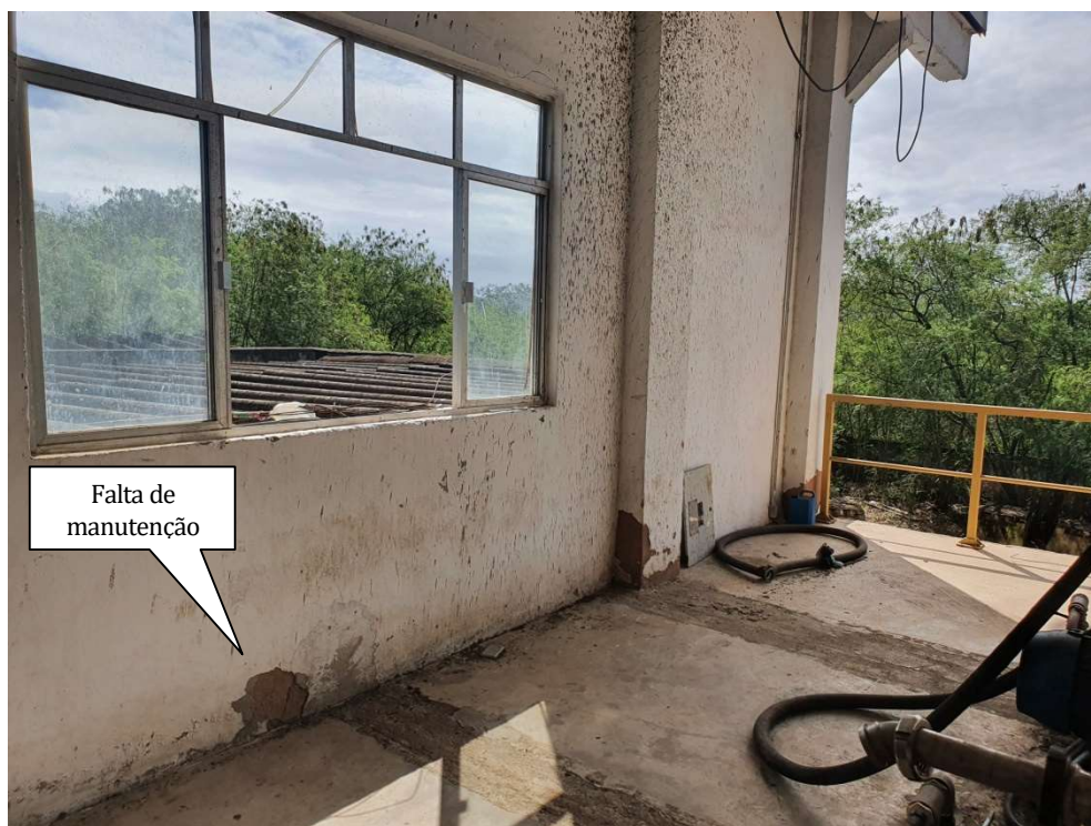
Foto 30 – Casa de bombas das centrífugas
