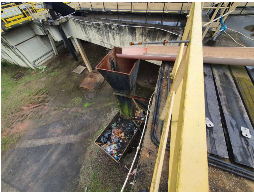
Foto 06 – Caçamba para sólidos retidos no gradeamento fino
