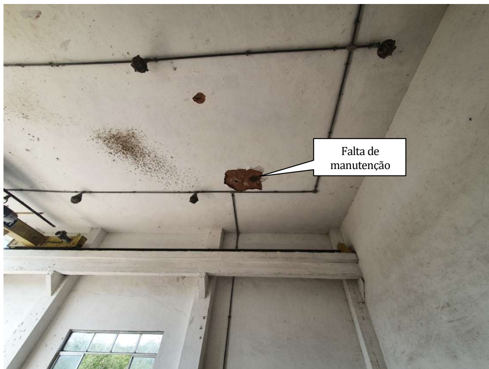
Foto 31 – Casa de bombas das centrífugas
