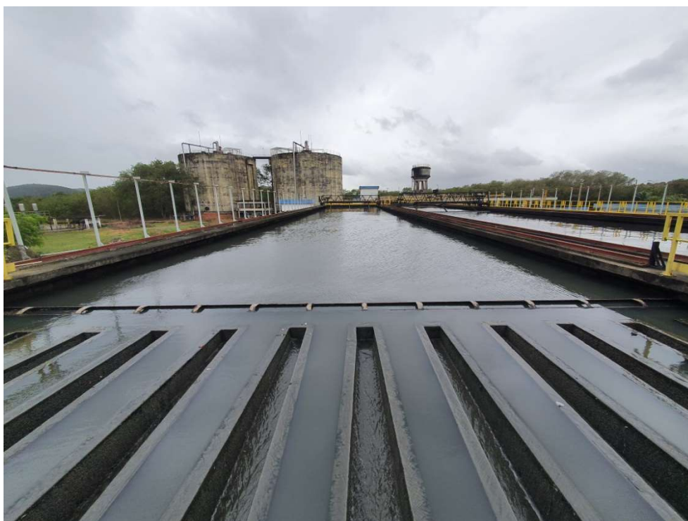
Foto 14 – Decantador primário
