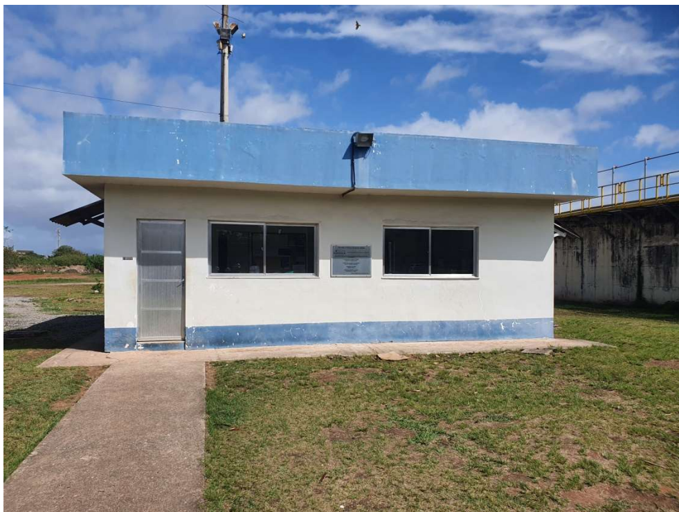
Foto 35 – Sala do operador
