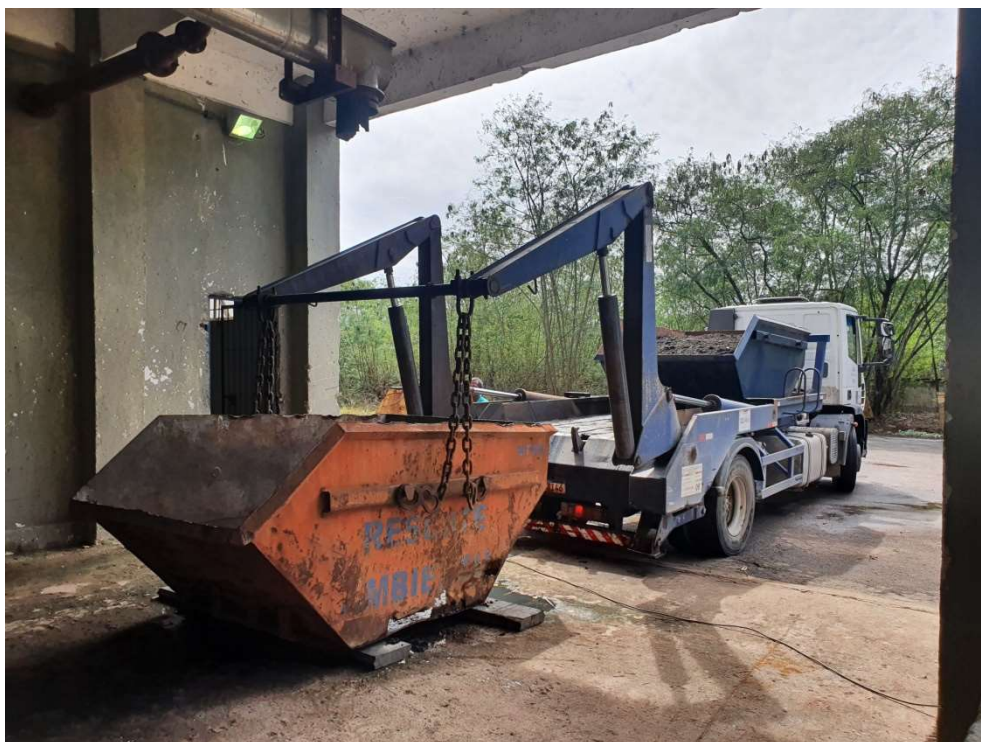
Foto 32 – Caçamba para remoção do lodo seco
