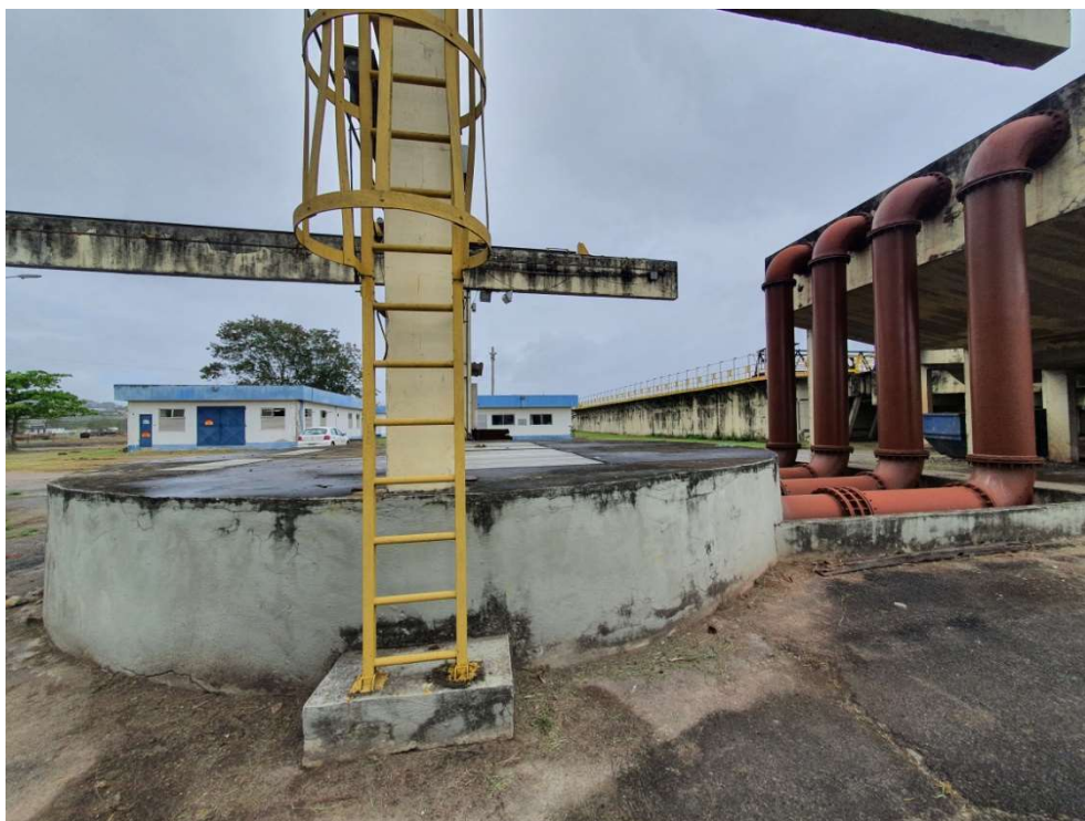
Foto 04 – Casa de bombas da elevatória
