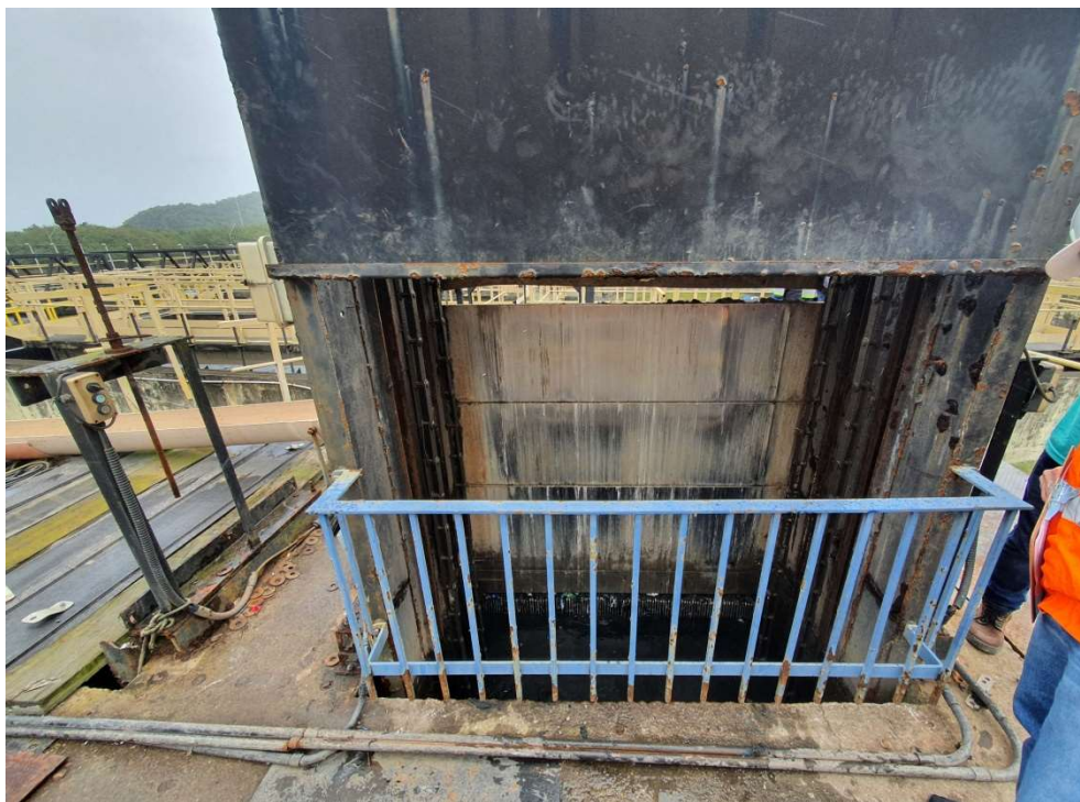
Foto 05 – Gradeamento fino mecanizada
