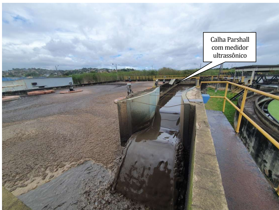
Foto 24 – Recirculação do lodo
