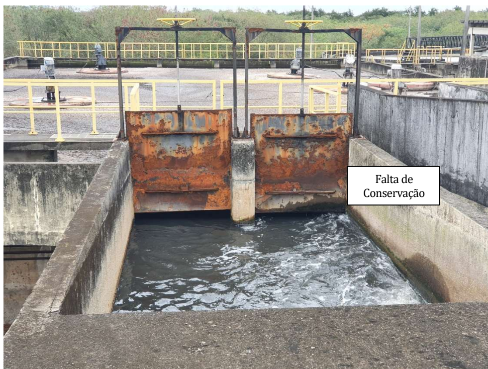
Foto 16 – Comporta para o tanque de aeração
