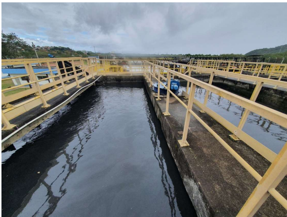
Foto 08 – Desarenador operando
