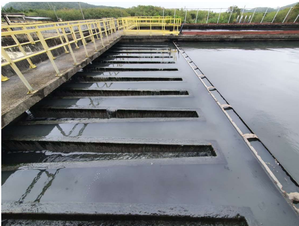
Foto 13 – Decantador Primário
