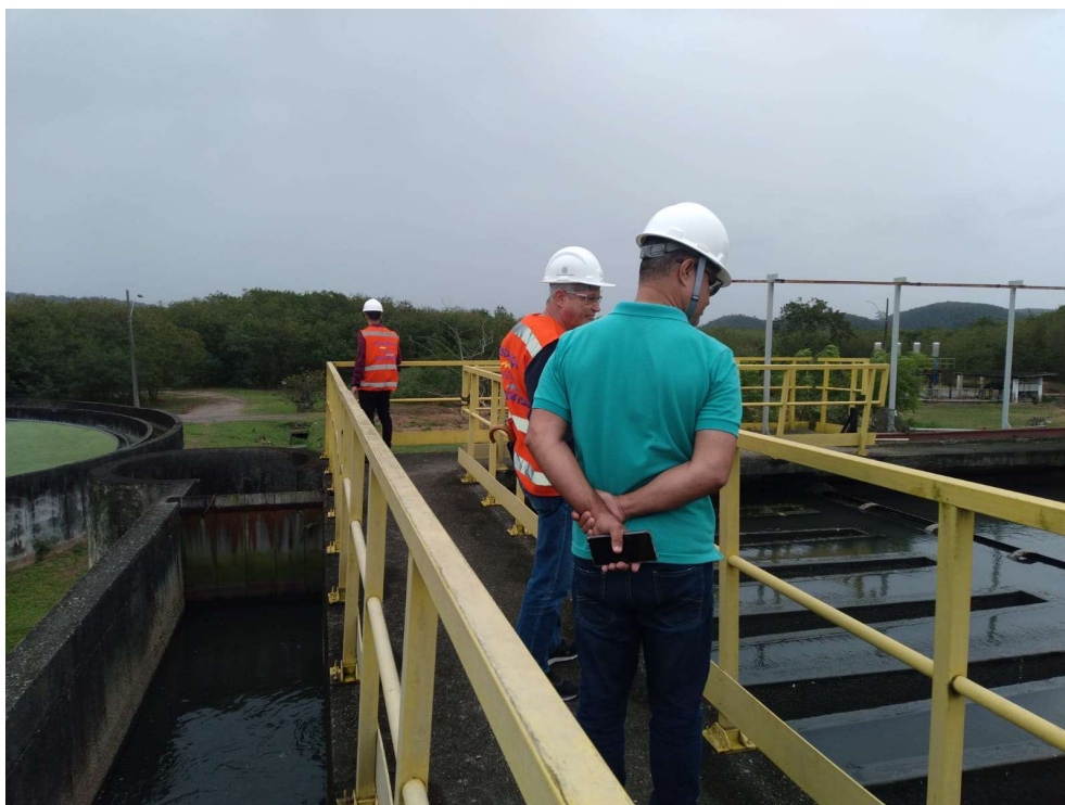
Foto 15 – Decantador primário
