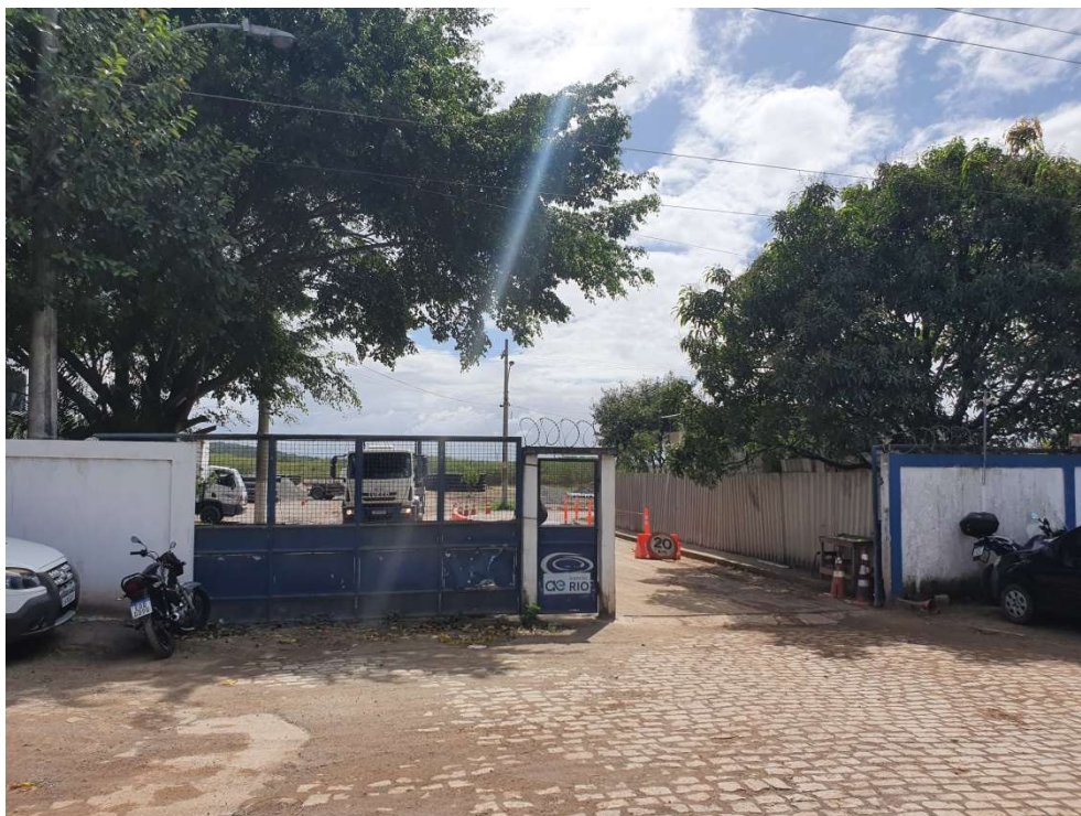
Foto 01 – Entrada da Estação de Tratamento de Esgoto
