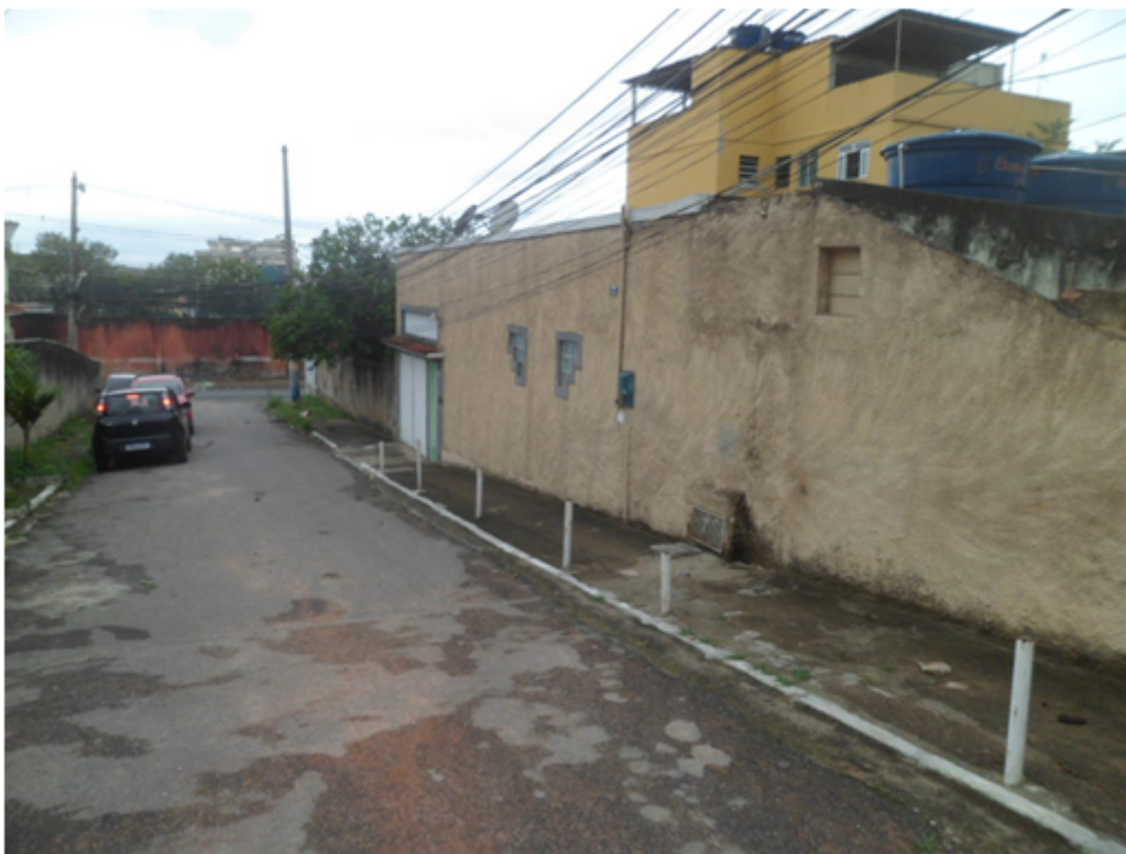
Foto 03 – Fachada da Casa Travessa Raul Rodrigues, 35 - Mesquita
