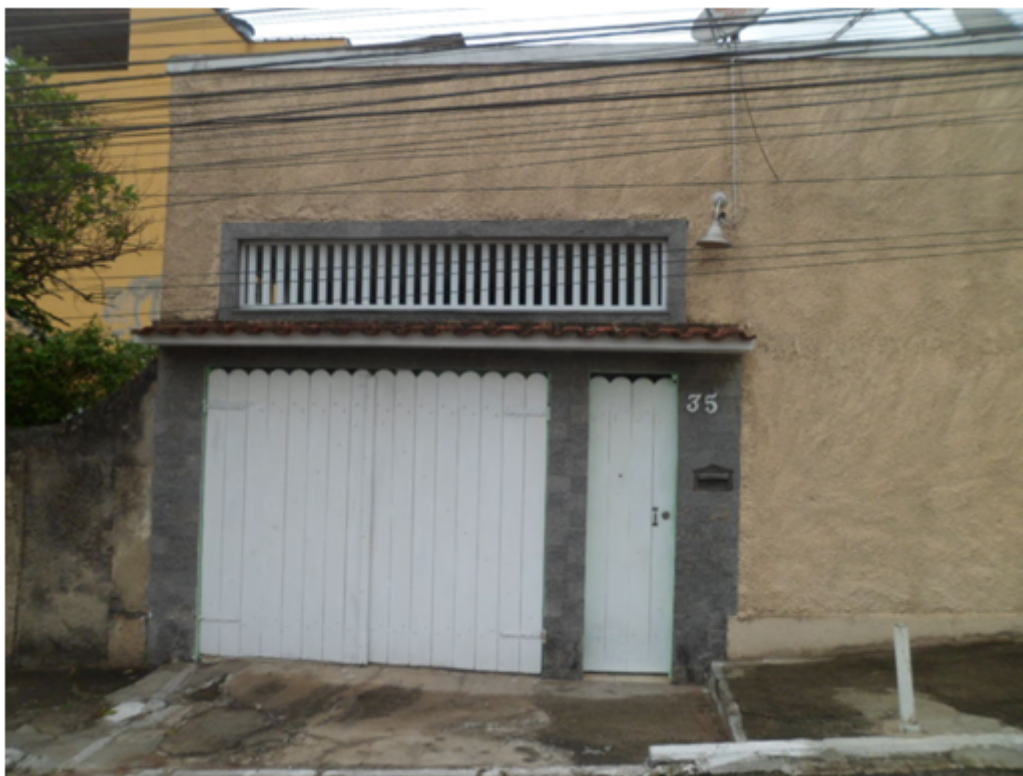
Foto 01 – Fachada da Casa Travessa Raul Rodrigues, 35 - Mesquita
