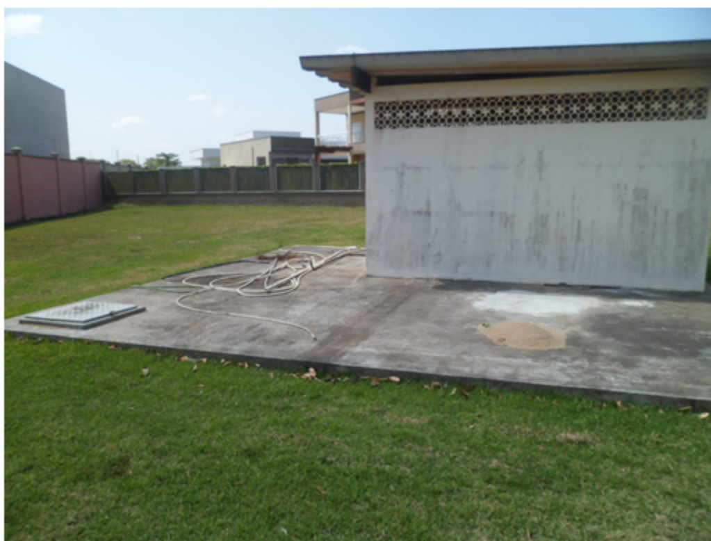
Foto 06 – Reservatório (cisterna) do Condomínio Alphaville 3, com capacidade de 138.000 Lt.
