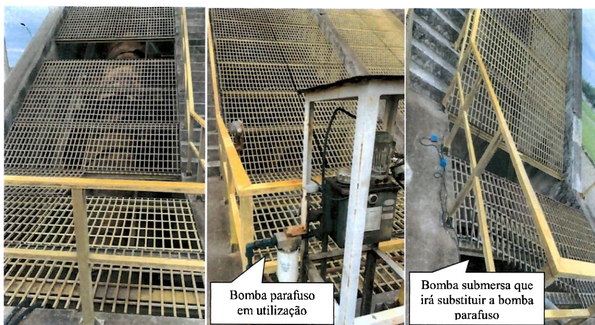
Conjunto de bombas parafuso
