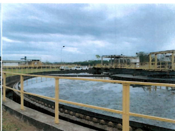
Decantador primário sem funcionamento
