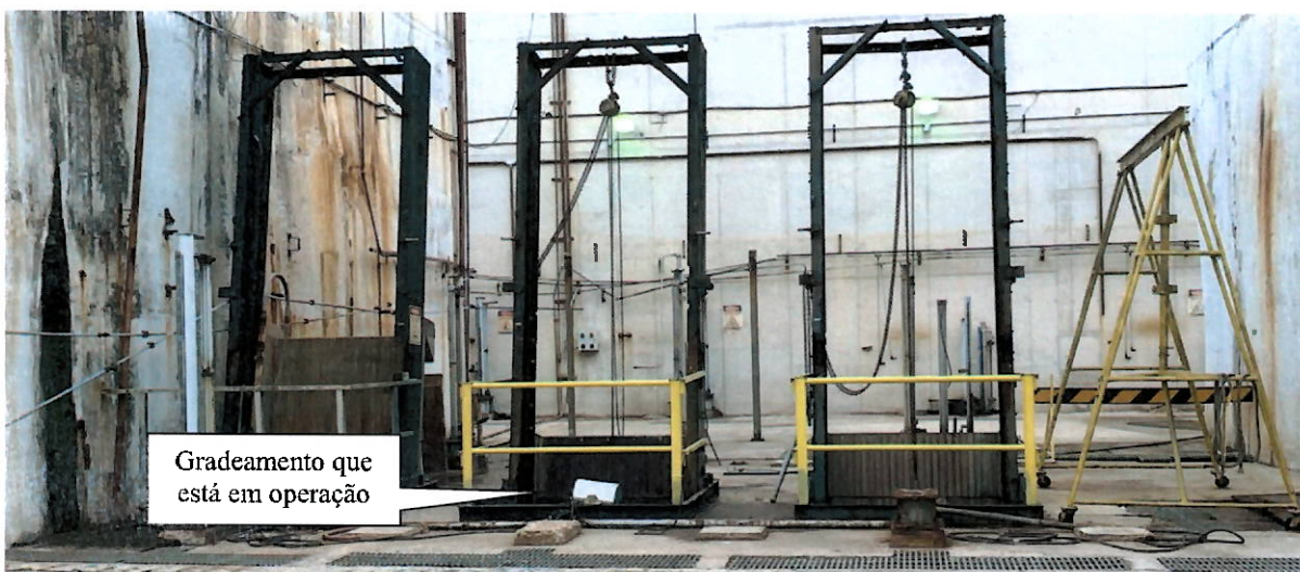
Conjunto de grades para retenção dos sólidos grosseiros
