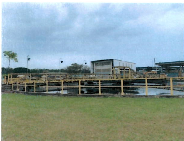
Decantador primário sem funcionamento
