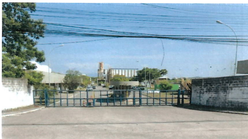
Entrada da ETE - Pavuna
