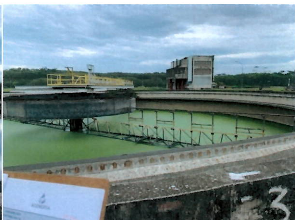
Decantador secundário reserva após manutenção
