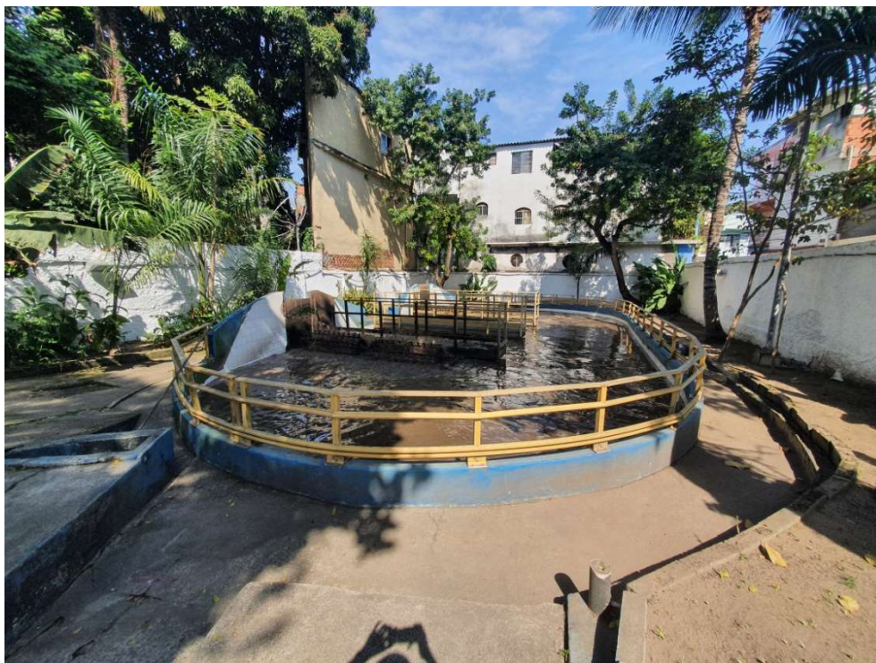
Foto 06 – Valo de oxidação
