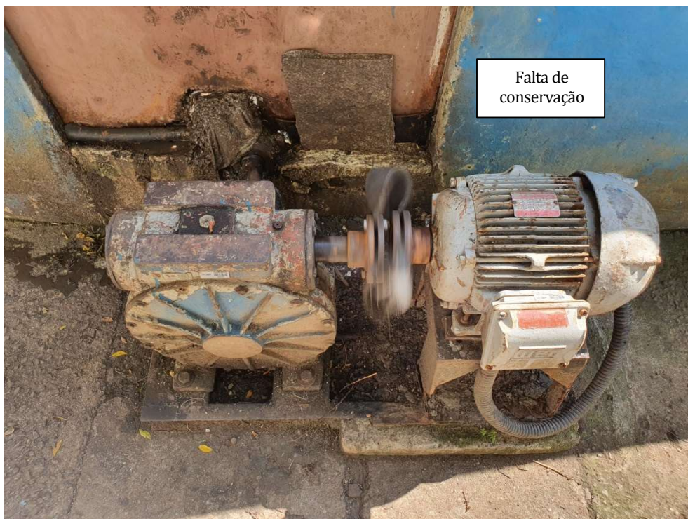
Foto 12 – Motor do Rotor
