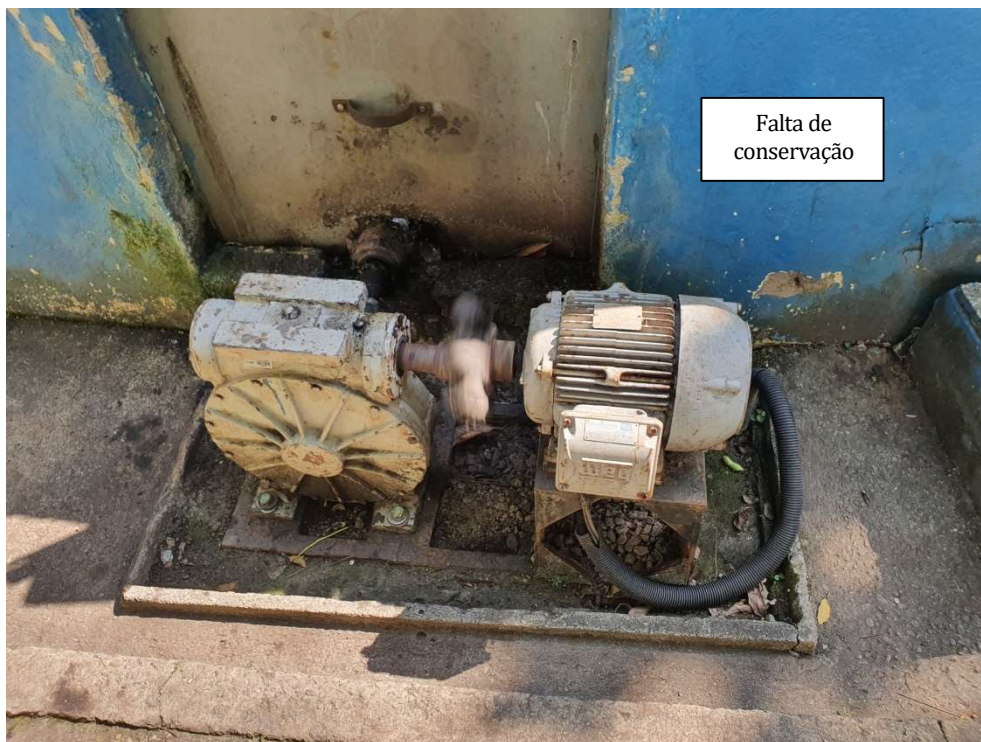
Foto 11 – Motor do rotor
