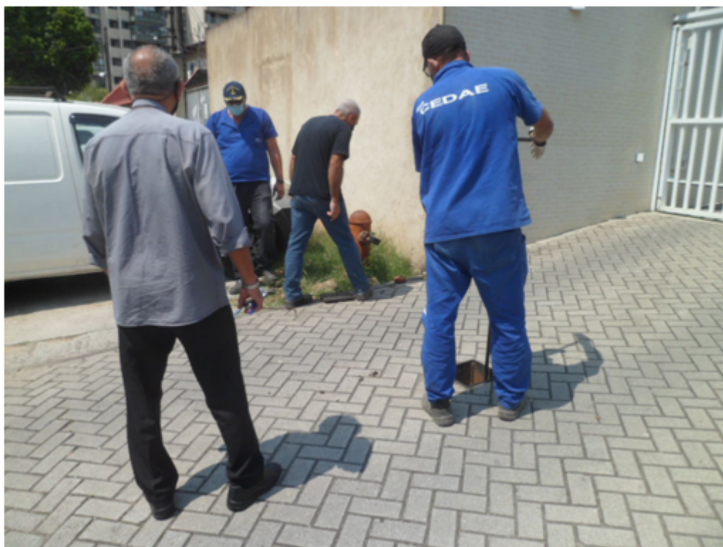
Foto 04 – Equipe da CEDAE Preparando para instalação de Manômetro Próximo ao nº 270
