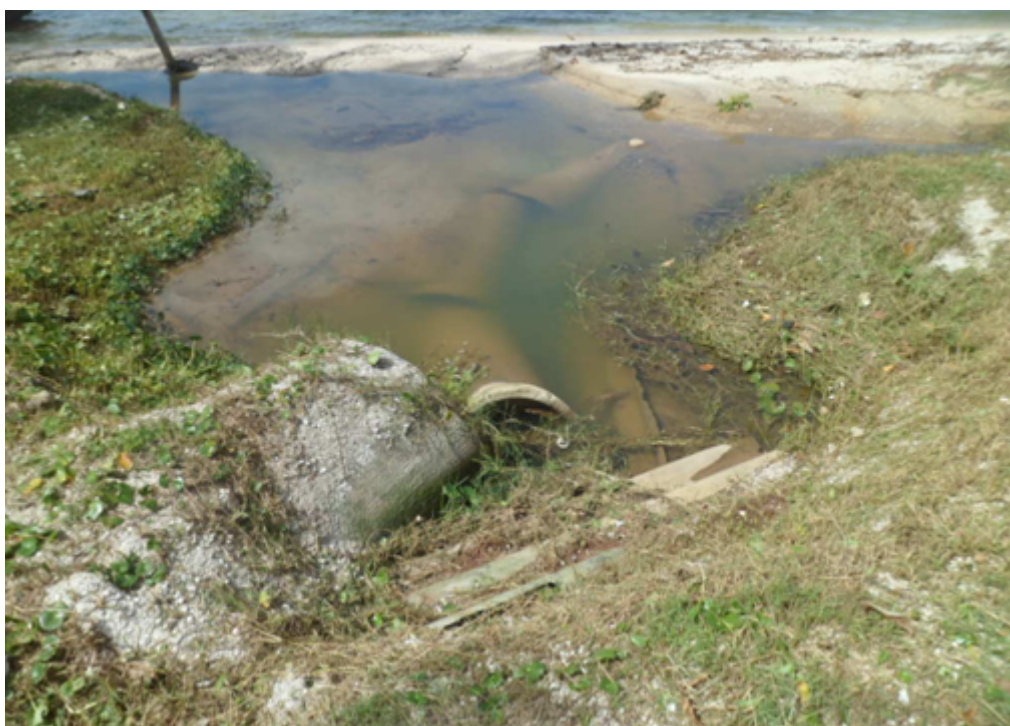
Foto 11 – Saída dos efluentes para a Lagoa (sem fluxo d'água)
