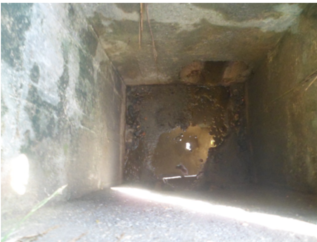
Foto 07 – Caixa de areia restaurada pela Prolagos
