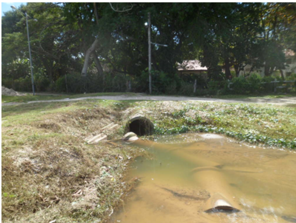
Foto 12 – Saída dos efluentes para a Lagoa (sem fluxo d'água)
