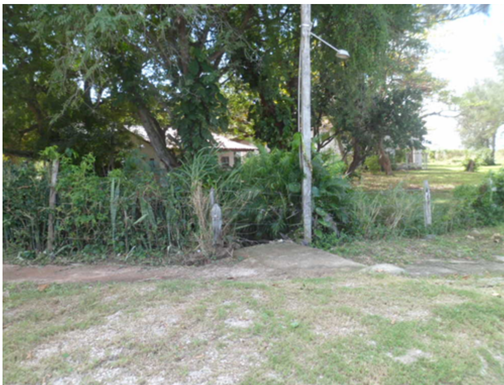
Foto 10 – Calha que trazos efluentes pluviais para a Lagoa
