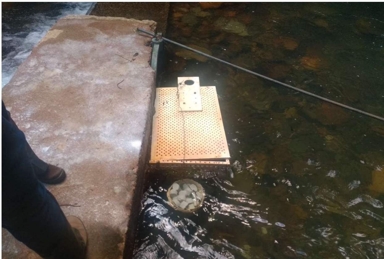
Local na barragem Mendanha onde é realizada a mistura da água com o hipoclorito de cálcio
