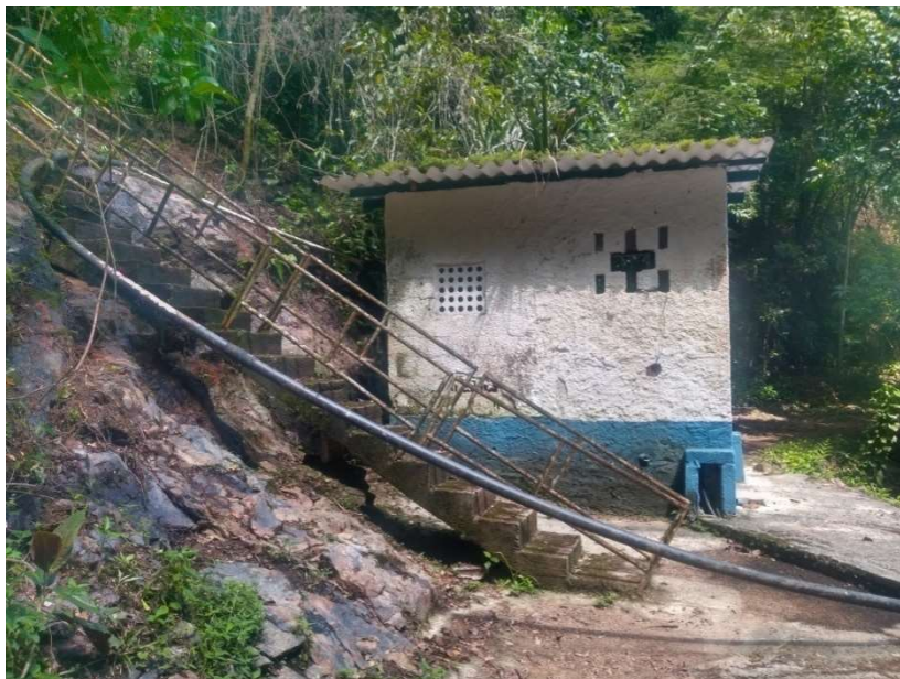
Casa de química situada na captação Mendanha
