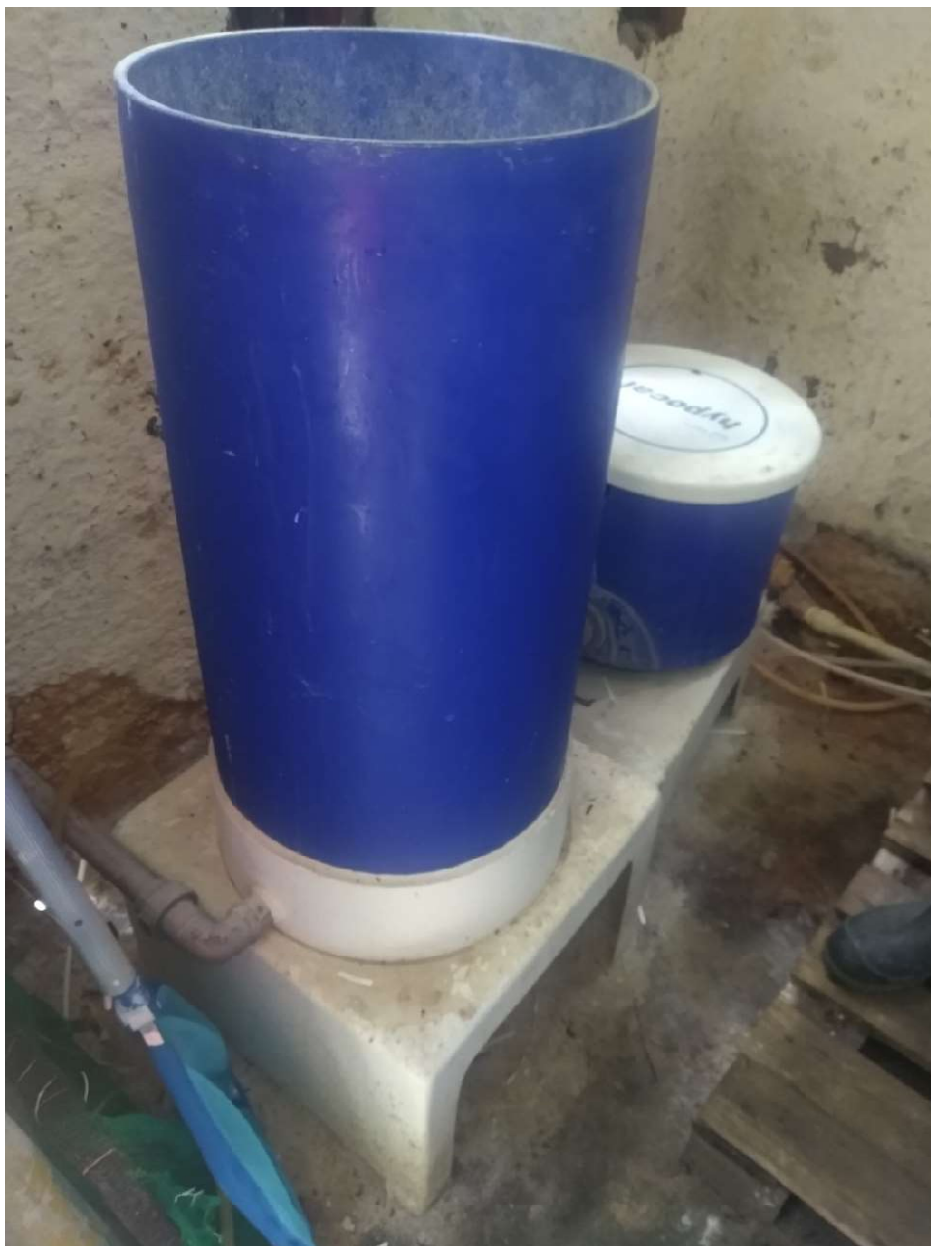
Compartimento (maior) onde eram depositadas as pastilhas de hipoclorito de cálcio Compartimento (menor) onde era feita a mistura
