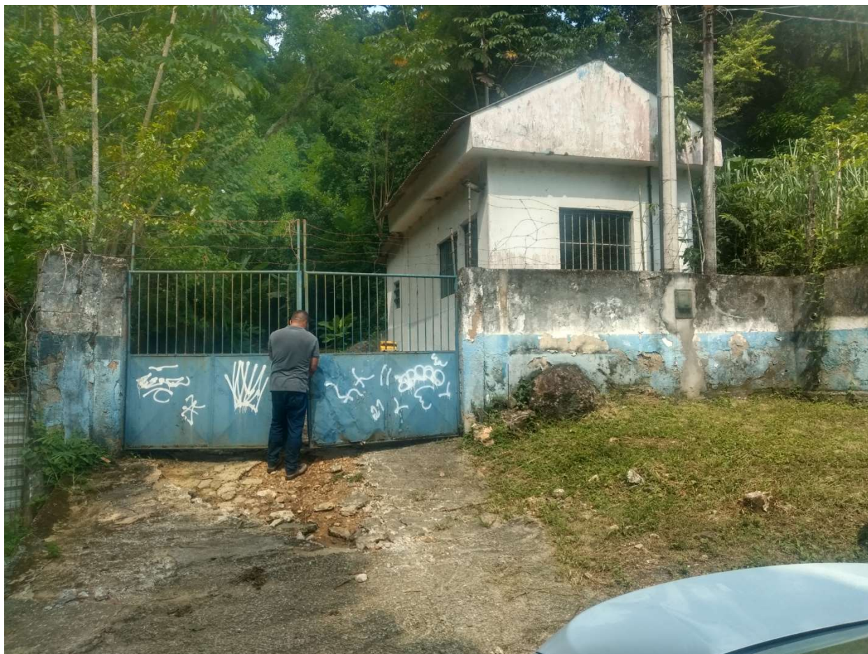
Entrada da Unidade de Tratamento (UT) Mendanha
