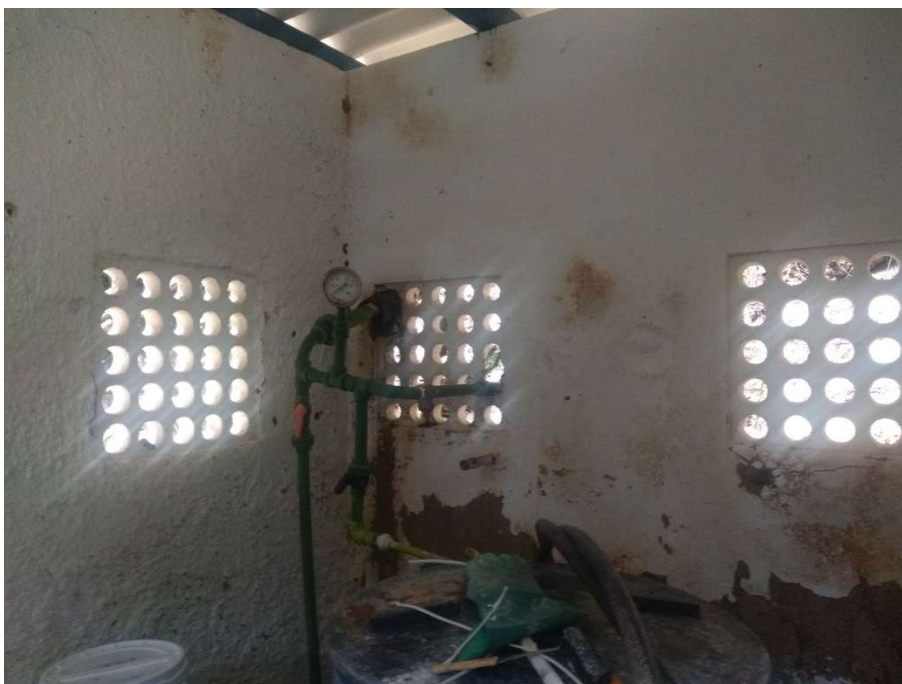
Interior da casa de química situada na captação Mendanha
