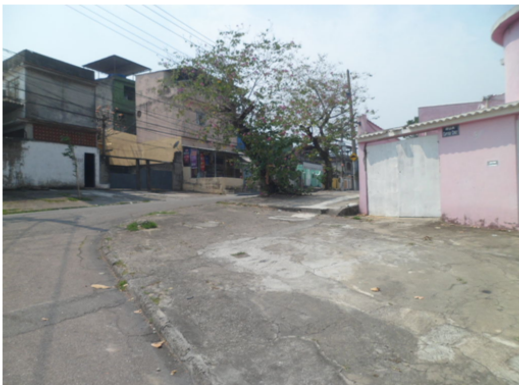
Foto 04 – Rua Capitão Cruz – Obras realizadas no início da rua
