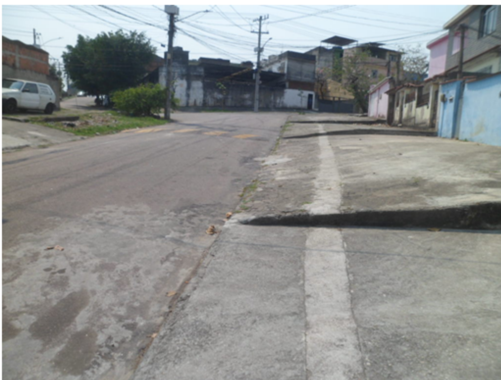
Foto 06 – Rua Capitão Cruz – Marcas das obras de substituição de rede
