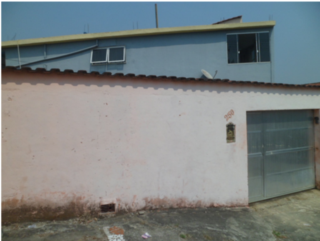
Foto 01 – Rua Balduino Aguiar, 250 – Frente da casa
