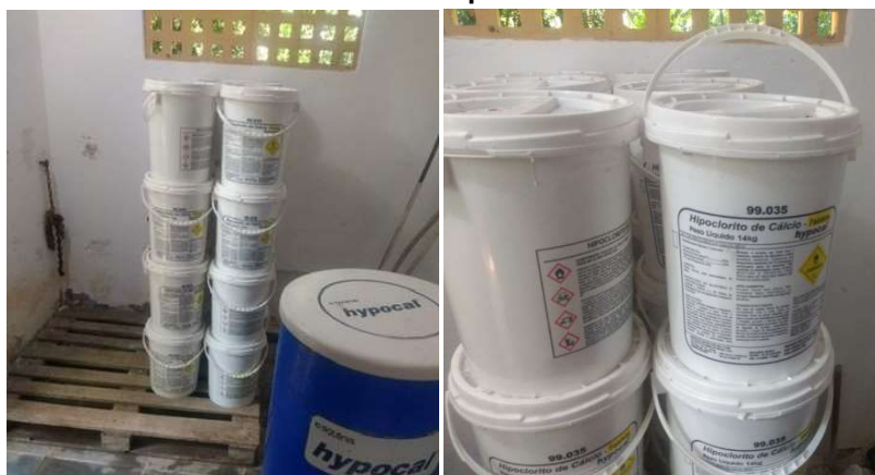
Armazenamento do Hipoclorito de Cálcio utilizado na desinfecção da água bruta
