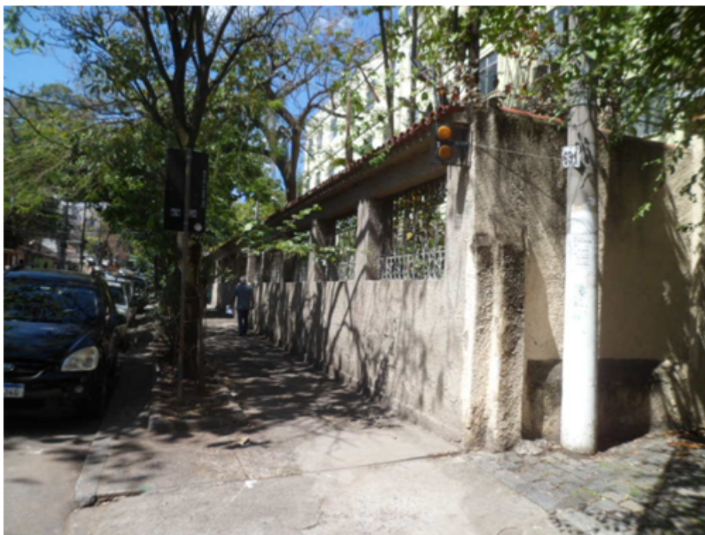
Foto 08 – Rua Barão, Altura nº 961 – Jacarepaguá
