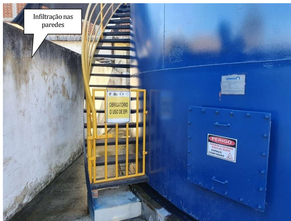
Foto 12 – Escada para parte superior do Reator UASB
