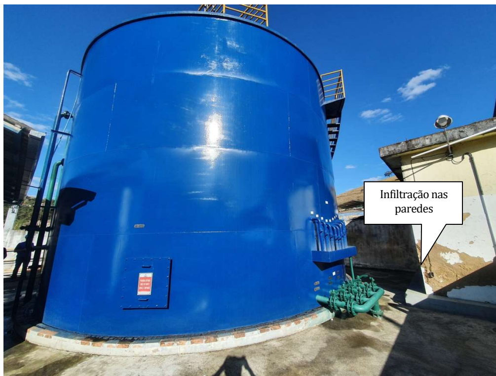
Foto 11 – Reator UASB
