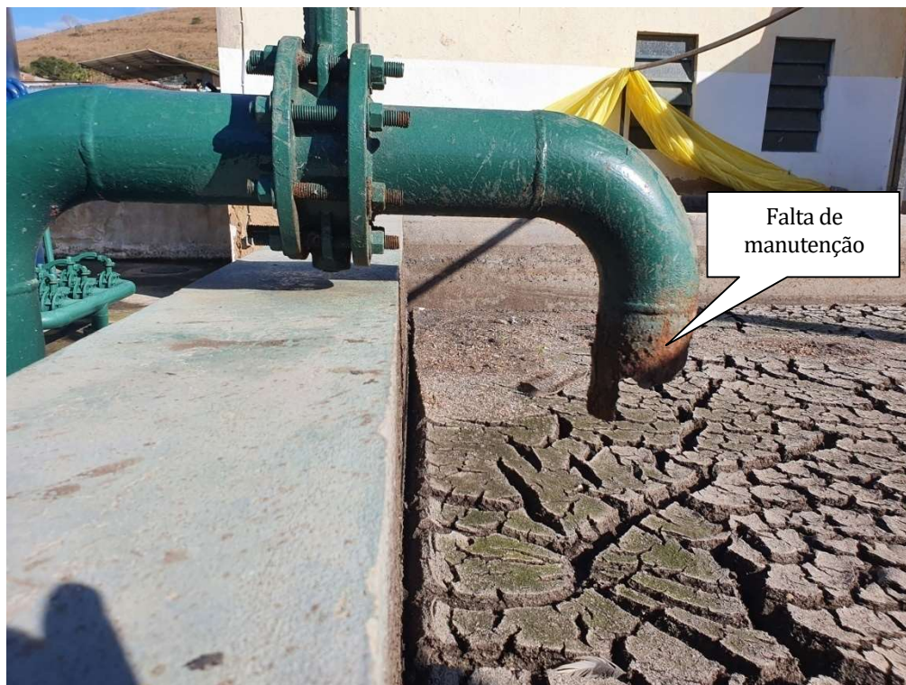
Foto 23 – Descarga do lodo
