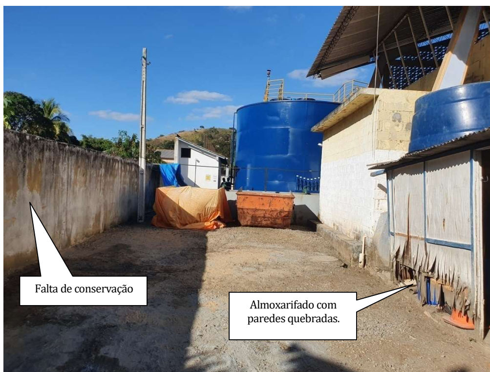
Foto 02 – Entrada da ETA
