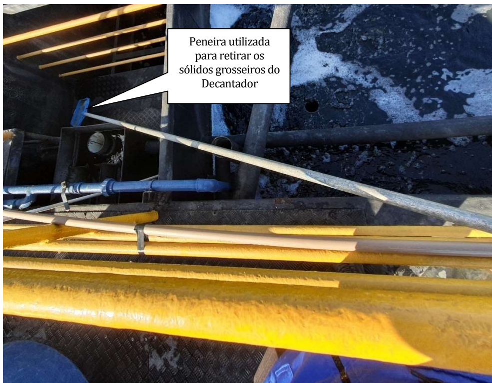
Foto 17 – Peneira utilizada para retirada dos sólidos grosseiros
