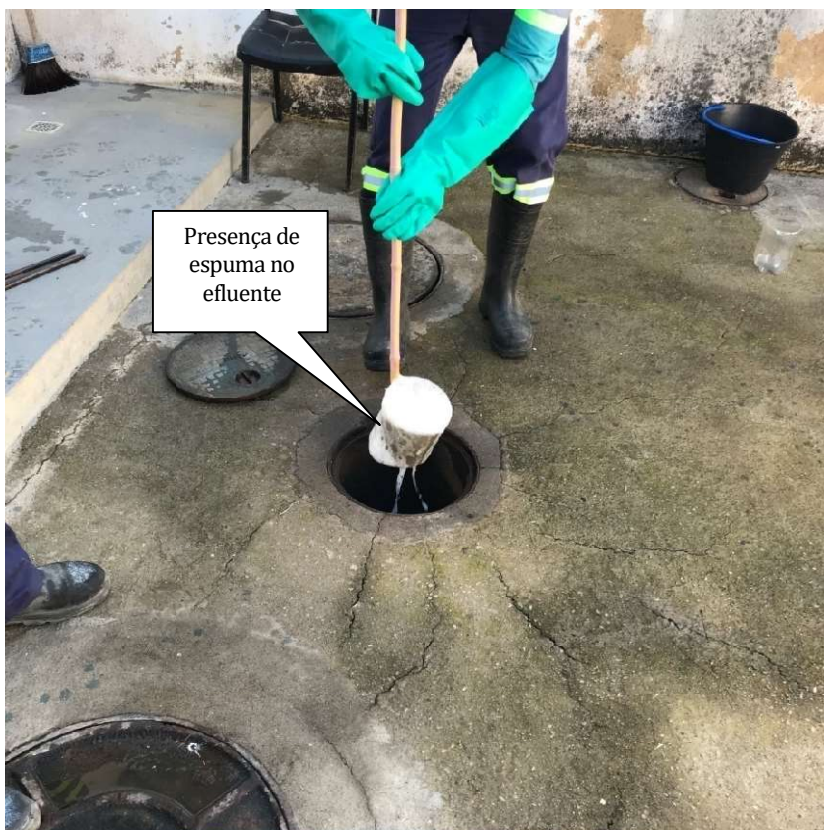
Foto 27 – Efluente da ETE
