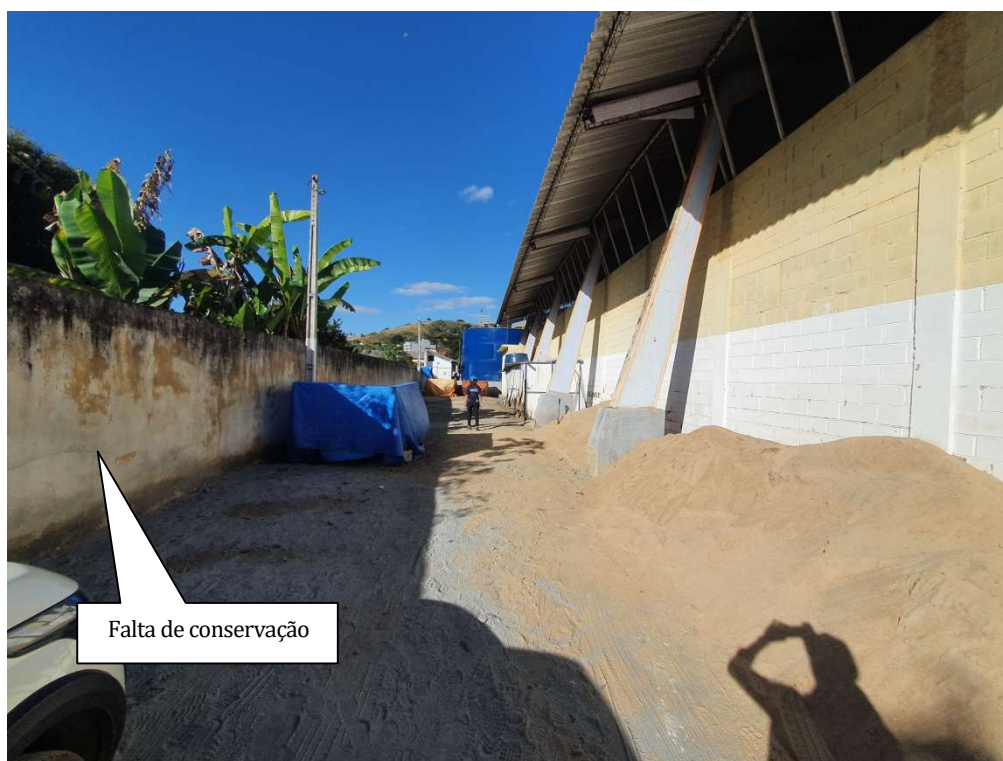
Foto 01 – Entrada da ETA
