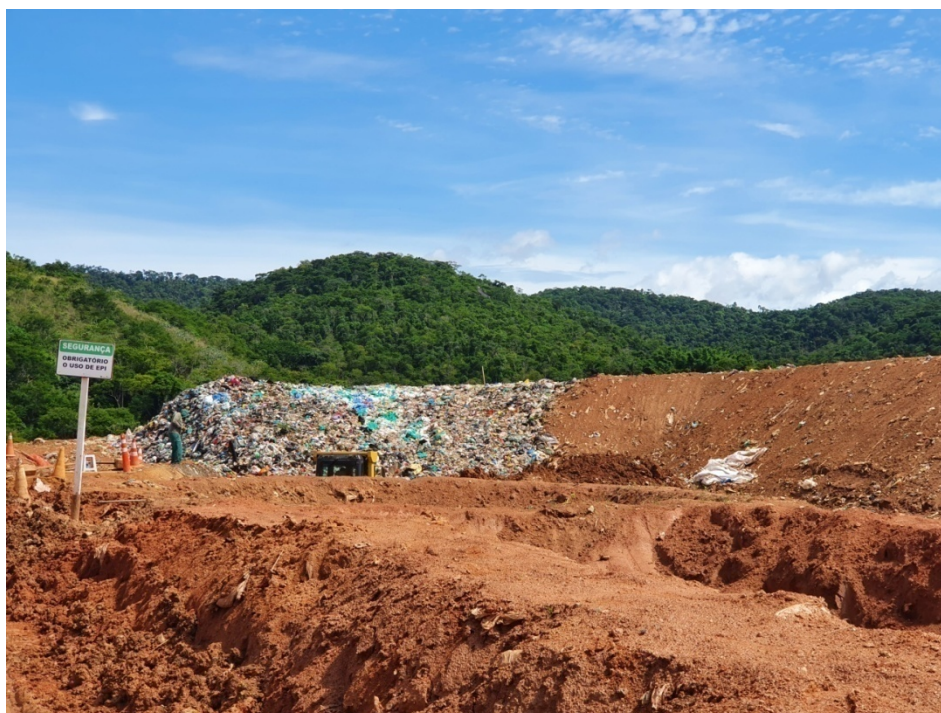
Figura 7: Vista da frente de trabalho.
