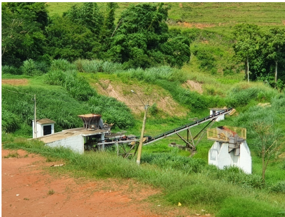
Figura 17: Britador de resíduos da construção civil inoperante.
