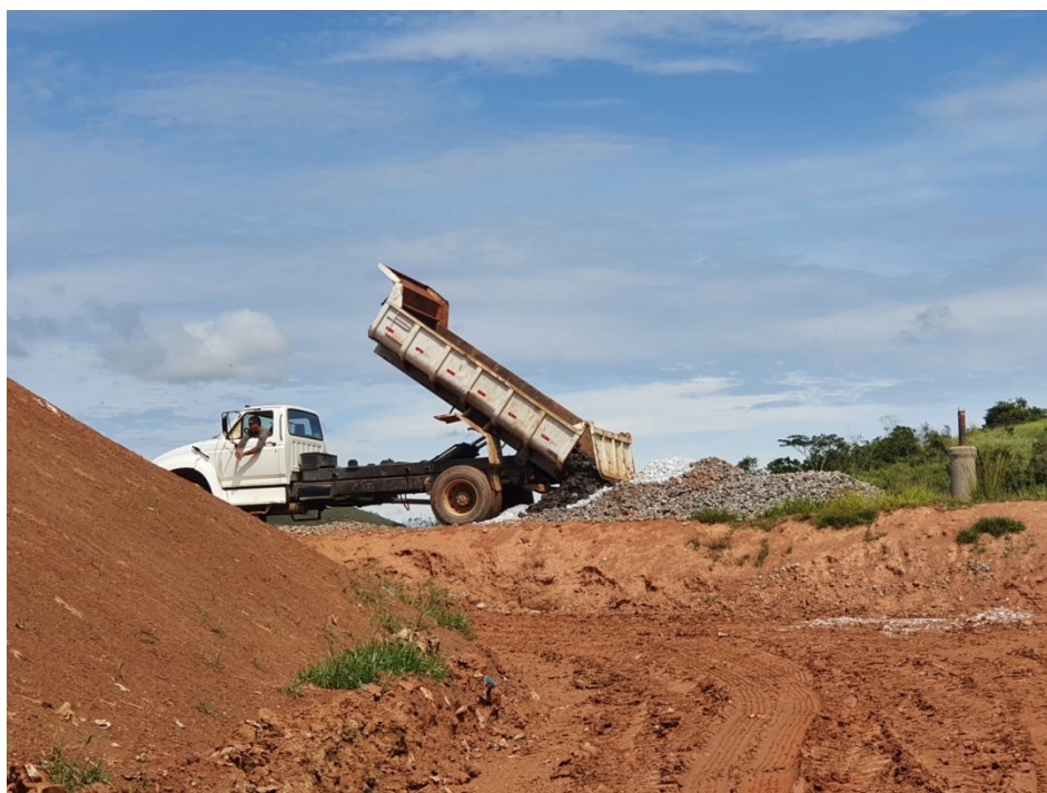
Figura 10: Caminhão descarregando as pedras a serem utilizadas na drenagem.
