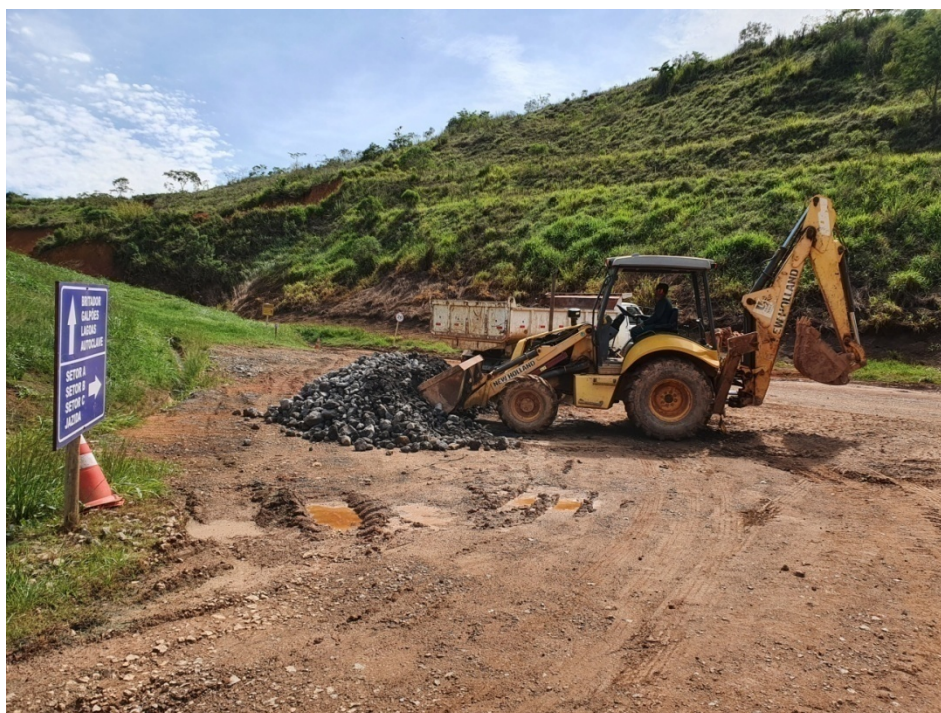
Figura 9: Pedras a serem utilizadas o colchão reno.
