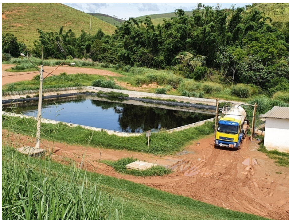
Figura 15: Lagoa de armazenamento de chorume.
