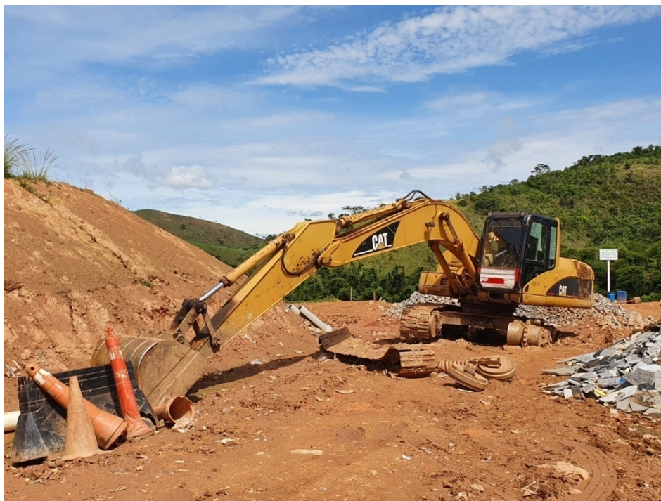
Figura 6: Escavadeira fora de operação decorrente de problema mecânico.
