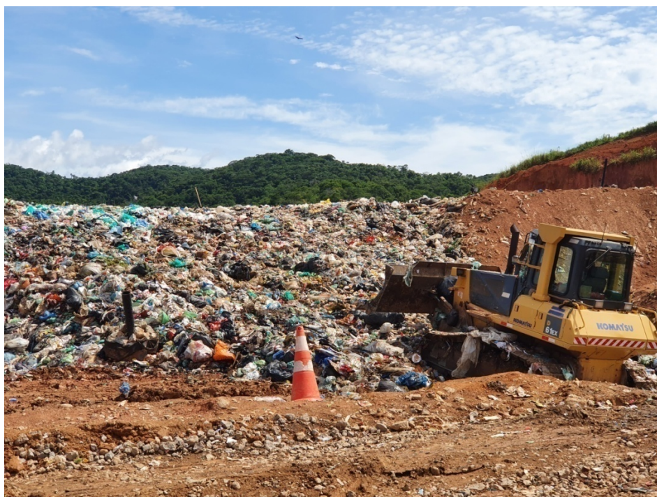
Figura 8: Vista da frente de trabalho.
