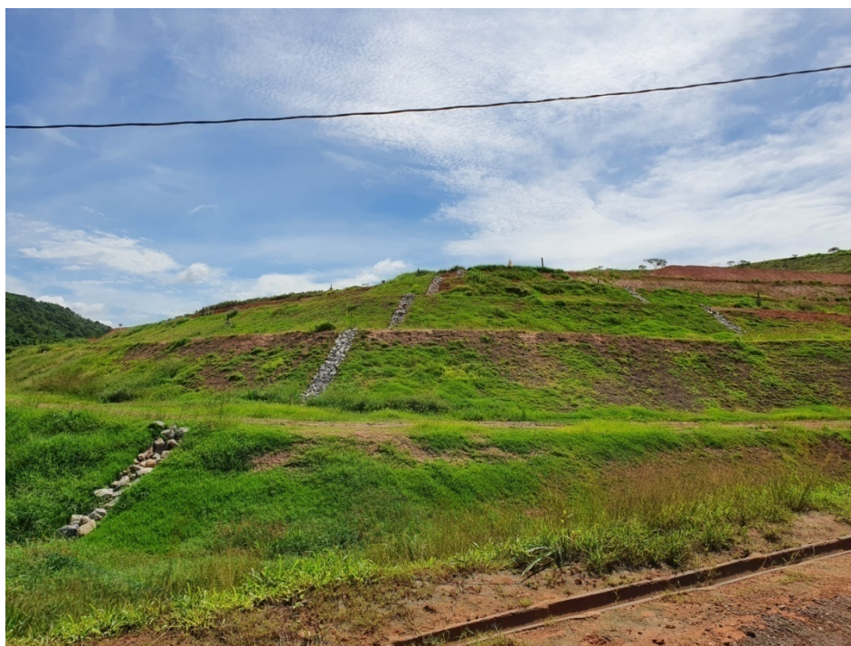
Figura 14: Vista de camadas concluídas da célula b.
