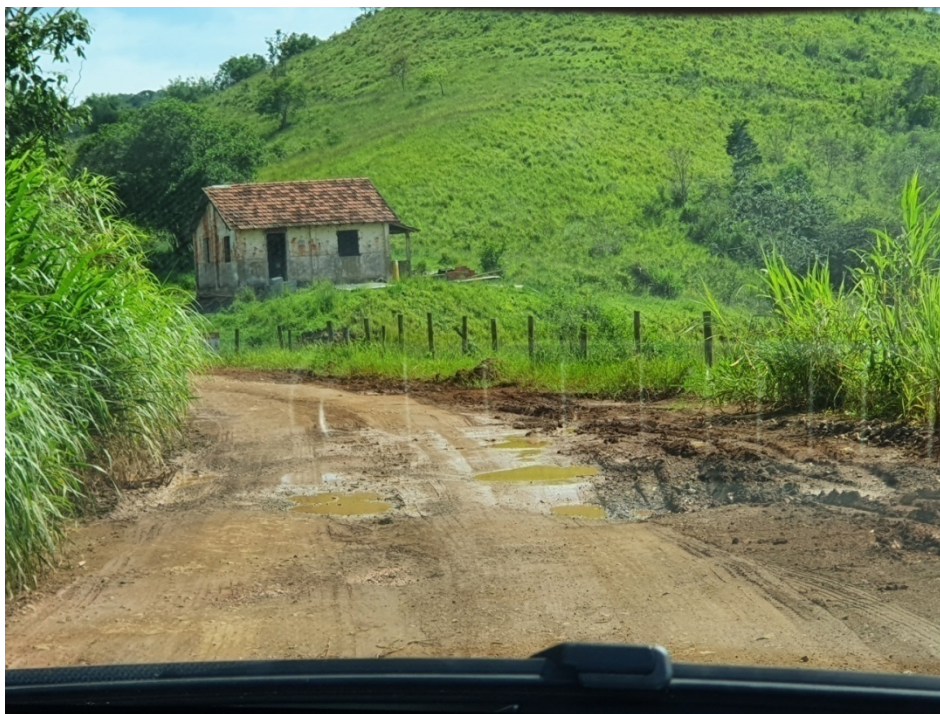
Figura 3: Vista do trecho da estrada de acesso com presença de buracos e poças de água.
