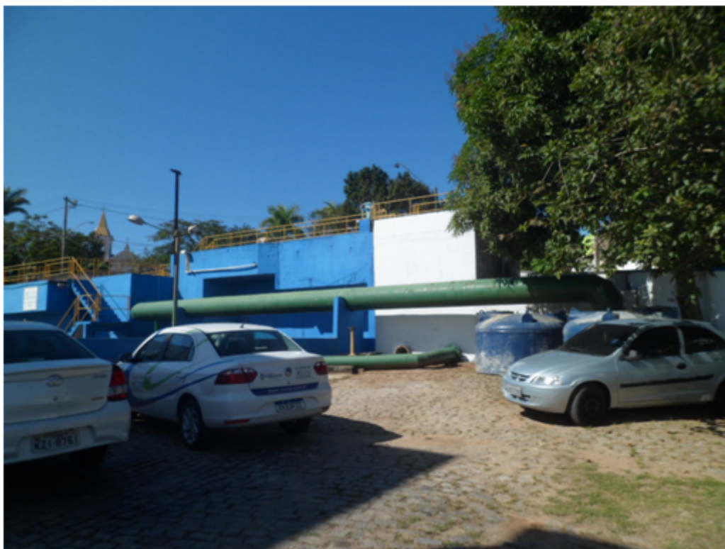
Foto 02 – Área Interna e Estacionamento da ETA
