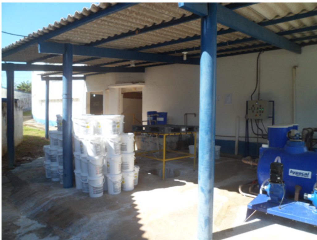
Foto 20– Armazenamento de Produtos Químicos
