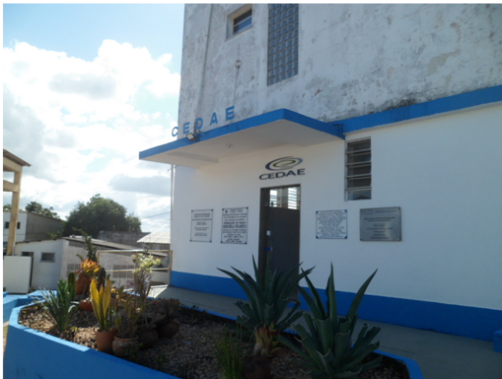
Foto 01 – Entrada do Prédio Principal da Estação de Tratamento de Água (ETA) Macaé
