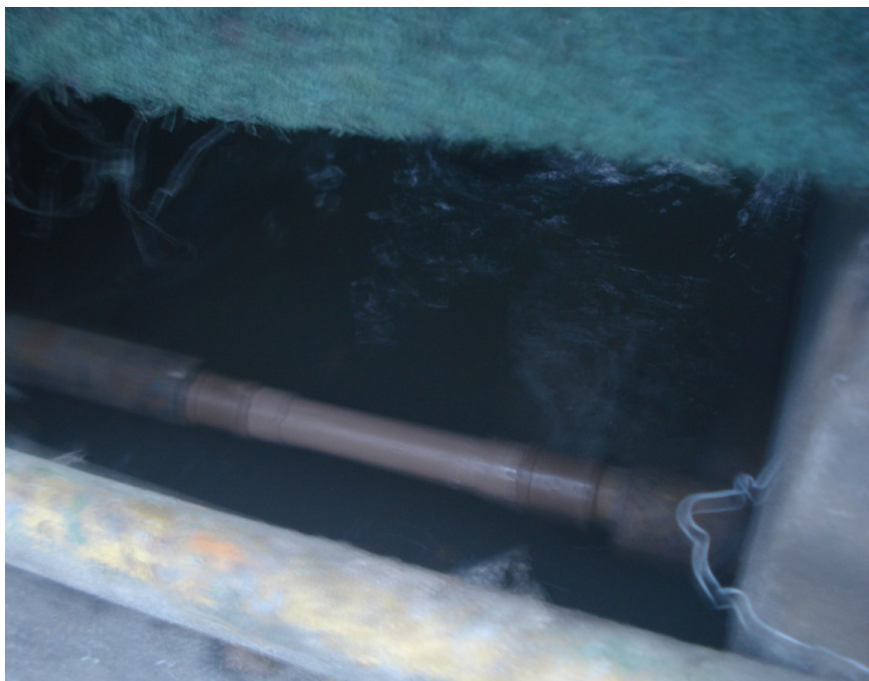
Foto 15– Substituição de tubulação (Rua do Valão) ponto crítico da visita
