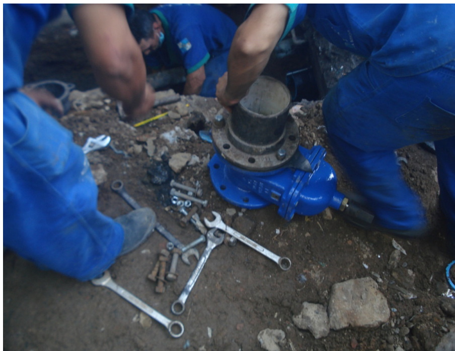
Foto 14— Substituição de Registro (Largo do Boiadeiro)
