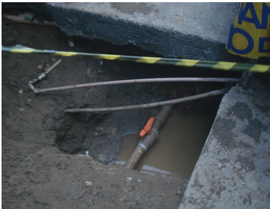
Foto 17 – Substituição de tubulação e registro (Rua do Valão) ponto crítico da visita
