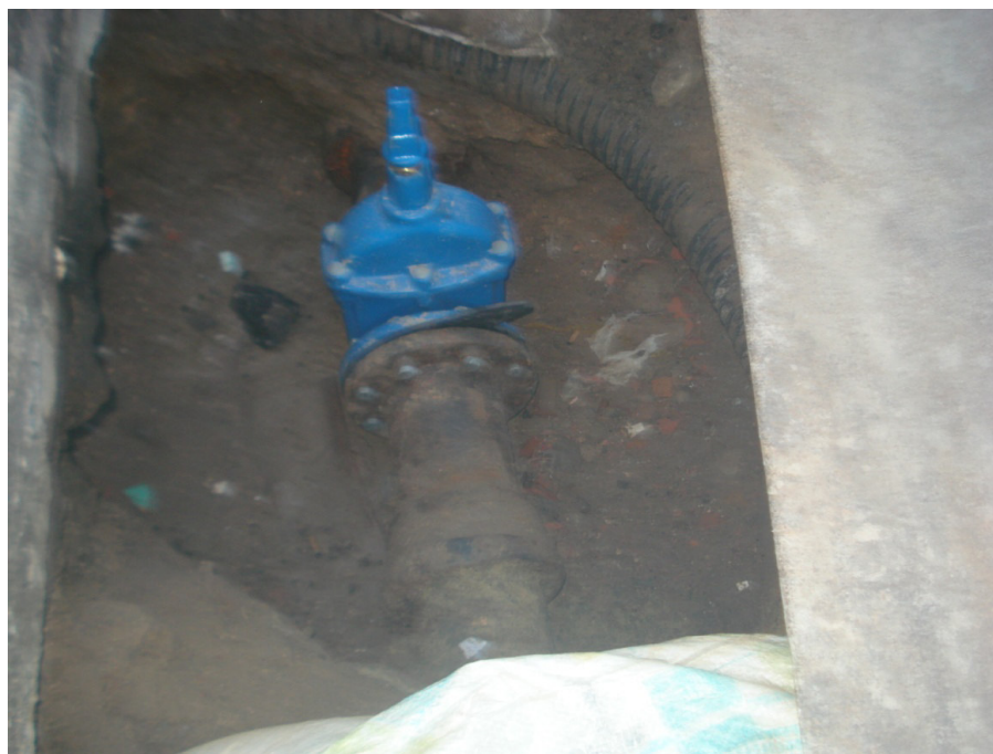
Foto 06 – Substituição de Registro (Travessa Mesopotânia do Bairro Barcelos), sem placa de sinalização
