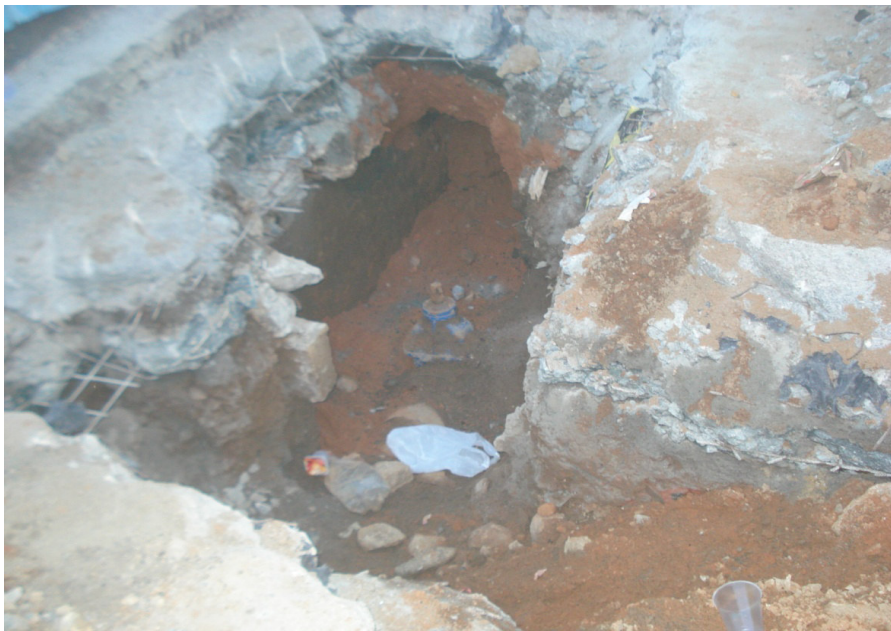
Foto 04 – Substituição de Registro (Estrada Lagoa Barra)
