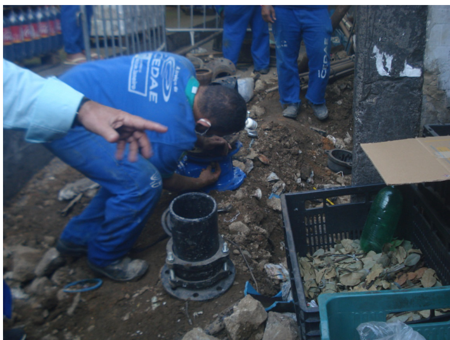
Foto 12 – Funcionários da CEDAE trabalhando e preparando os equipamentos (Largo do Boiadeiro)
